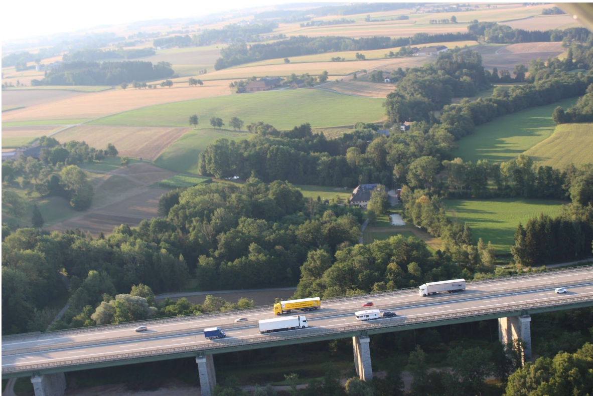
Abb. 1: Albersdorf (Blick nach Norden), topographischer Überblick über den direkt nördlich der Aitertailbrücke gelegenen Fundplatz mit nach Westen hin ansteigender Geländeterrasse (Foto: Franz X. Wimmer 2016, CC BY 4.0)
