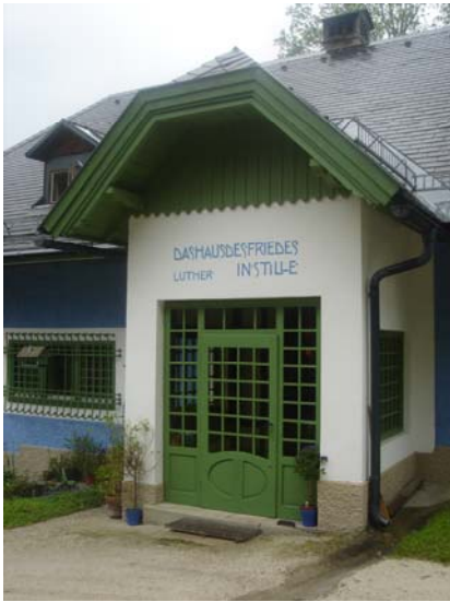
Abb.94: Hoffmann: Bergerhöhe, Eingangsvorbau, 1899
