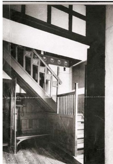
Abb.99: Hoffmann: Bergerhöhe, Vorraum, 1899
