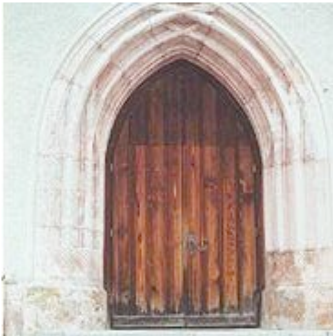
Abb. 111: Hall in Tirol, Pfarrkirche, Westportal mit restaurierten Originalfassungen der Portalgewände (rot-gelbe Bänderung) um 1470 (Zustand 1999)
