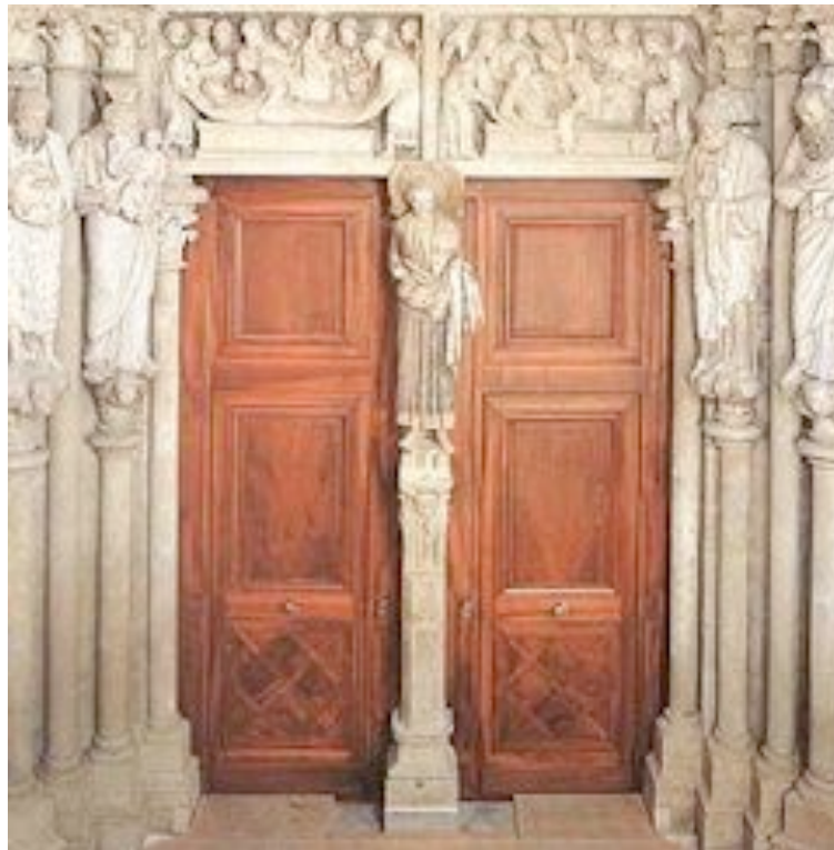
Abb. 164: Lausanne, Kathedrale, Portal
