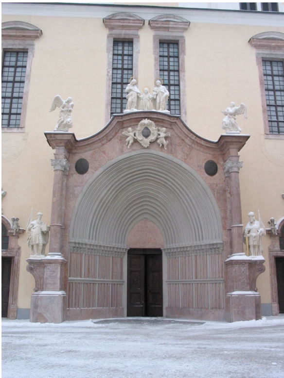
Abb. 102: Stift Lilienfeld, Westportal nach der Restaurierung
