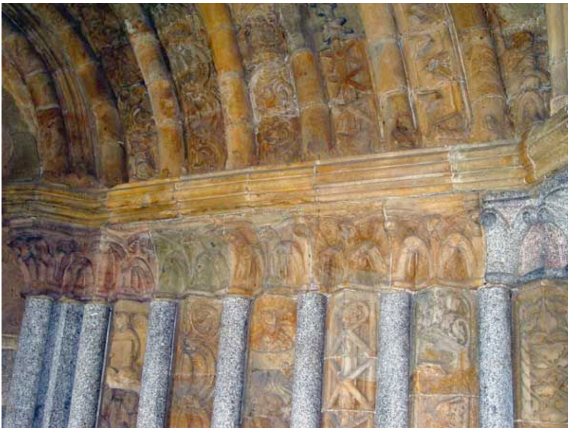
Abb. 129: Trebic, Zisterzienserkirche, Paradiesstor, Gewändedetail
