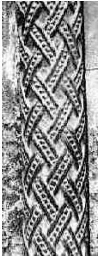
Abb. 33: Wien, St. Stephan, Riesentor, rechts, 3. Gewändesäule, Rautenförmiges, diamantiertes Flechtband
