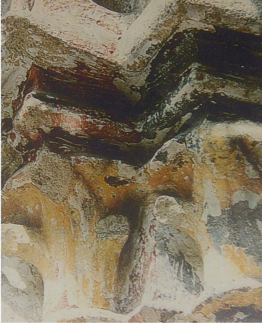
Abb. 122: Kremsmünster, Südportal, linkes Gewände, Farbreste auf Kapitellen und Fries, gelb, rot, grün
