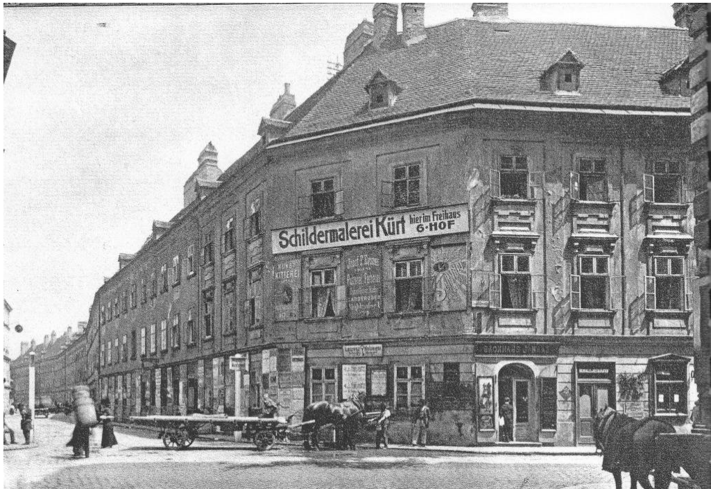
Abb. 116 Freihaus auf der Wieden zur Mühlgasse Ecke Schleifmühlgasse, Foto 1910.
