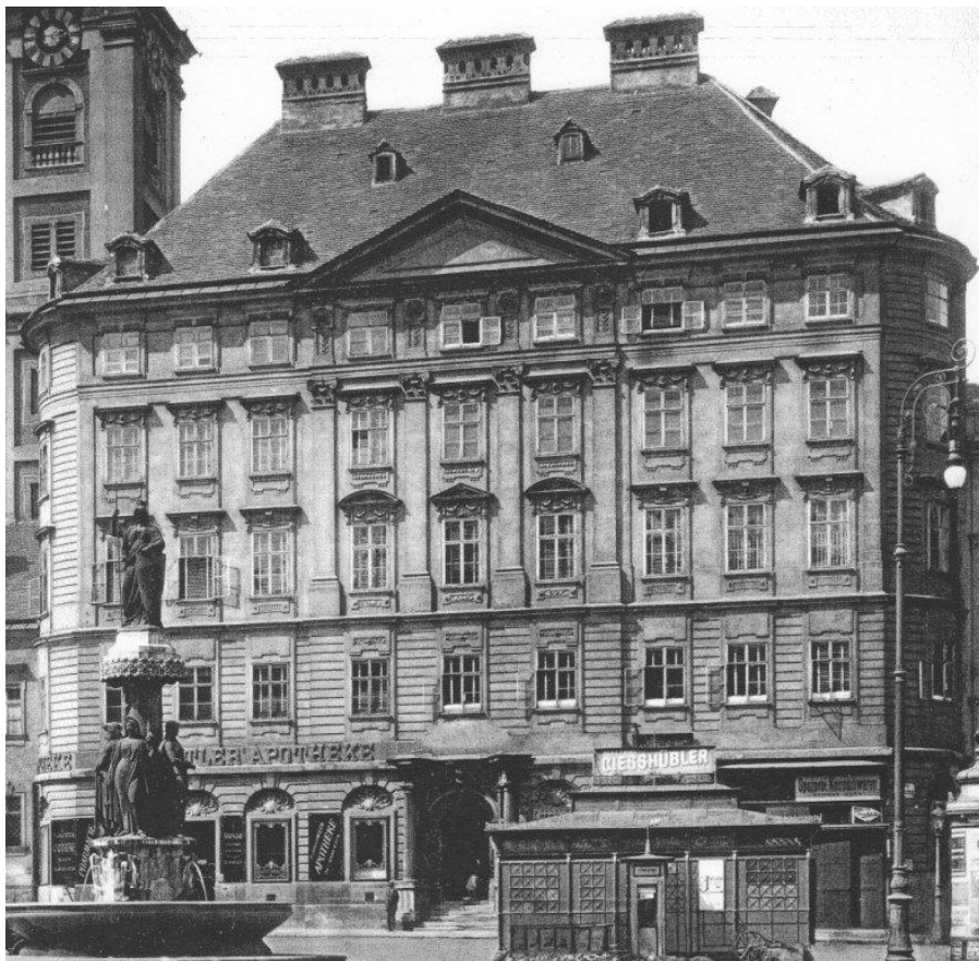
Abb. 133 Prioratshaus des Schottenklosters in Wien, Andreas Zach 1774, Foto Hübl.
