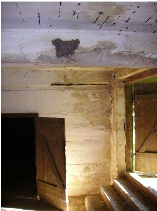
Abb.5: Nest IV, befestigt an einer Deckenstruktur des Weinkellers.
