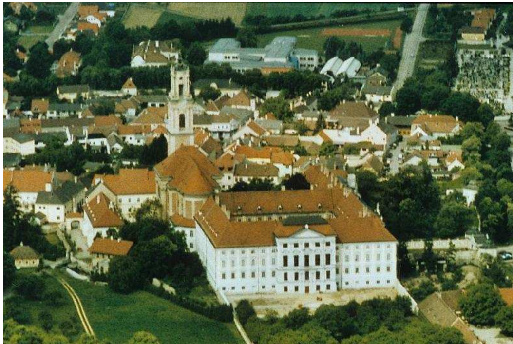
Abb. 13: Herzogenburg, Augustiner-Chorherrenstift Herzogenburg, Luftbild
