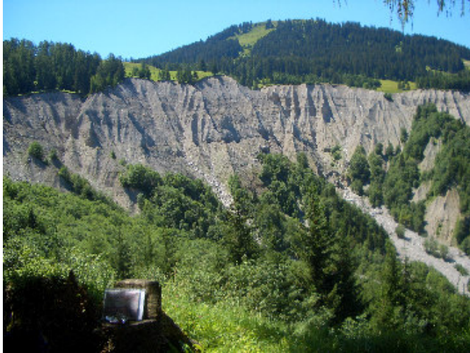
Abb. 3.11: SchesabruCHKesselwand unterhalb der Burtschaalpe vom Bereich E der St. Martin Rutschung aus fotografiert: Blick nach W. Im Hintergrund der Loischkopf. Deutlich erkennbar die ca. nach ESE einfallende Schichtung des Sedimentstapels.
