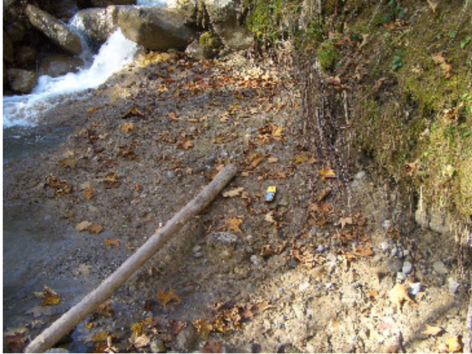
Abb. 2.7: Konglomeratvorkommen im Bachbett des Mühlebachs, S Davider Moor. ~1180 m SH (GK28:-43706/223342). Vorkommen dieser Formation sind bis in den Unterlauf des Mühlebachs, bis kurz vor dessen Mündung in den Schesatobel, zu finden.
