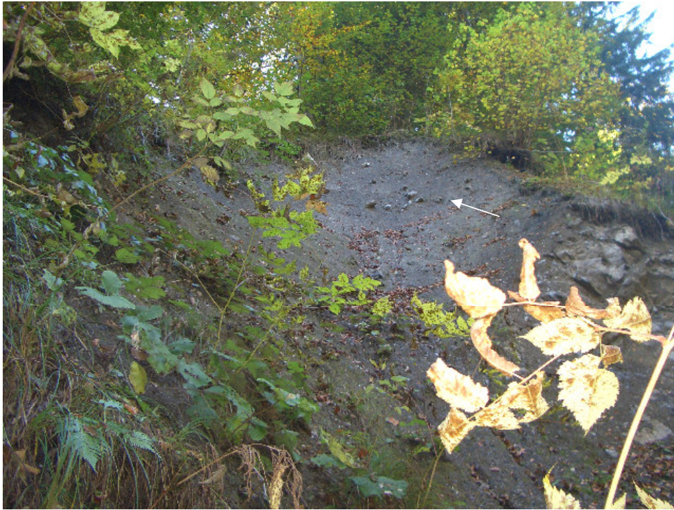
Foto Nr. 4: Uferanbruch, Plattenbach, rechtsufrig. Spätglaziale Lockersedimente, evtl. Murgänge. Horizontale Grobkieslage ersichtlich (Pfeil). Unterlagert von gebankten Raibler Kalken (Einfallen: 56° NNW). Blick nach SW. GK28:-42274/224198, rund 830 m SH.
