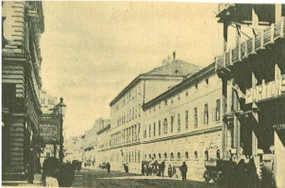
Abb.72: Portois & Fix Gebäude in Bau, Die Ungargasse um 1900.
