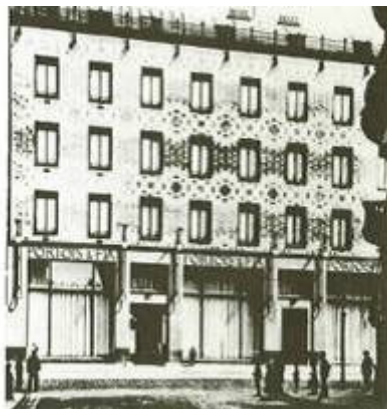
Abb.80: Frontansicht: Verkaufsräume im Parterre, Geschäftshaus Portois & Fix. In: Bestand Bezirksmuseum Landstrasse.
