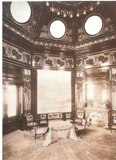
Abb.43: Innenraum des Hofpavillons der Wiener Stadtbahn, Warteraum des Kaisers im originalen Zustand, 1899. © Paul und Stefan Asenbaum.
