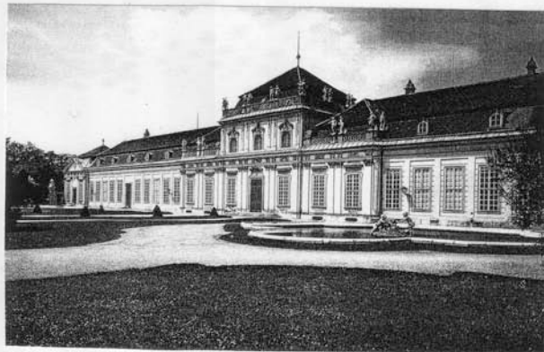
Abb. 35 Unteres Gartenschloss, Blick zur Gartenseite mit vorgelagerten Bassins.
