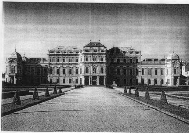
Abb. 72 Blick zur Nordseite des Oberen Gartenschlosses unter Hinweis auf die verglaste Front der Sala terrena und die Silhouette der Dachkonstruktion.
