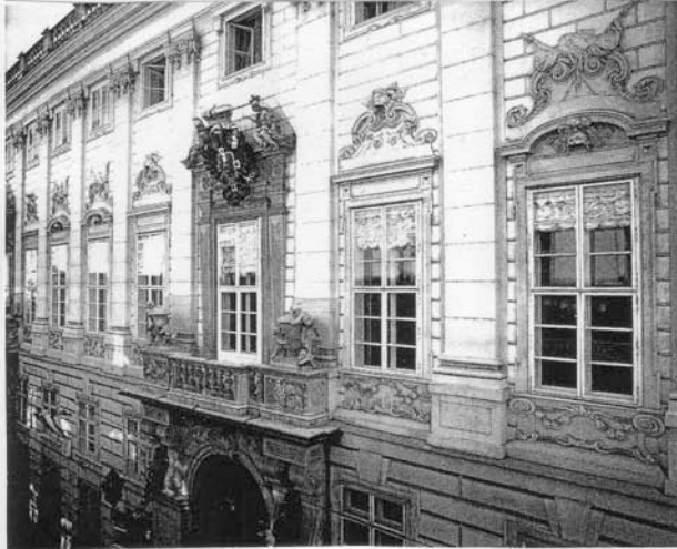
Abb. 10 Stadtpalais in der Himmelfortgasse, Piano nobile des Kernbaus, Fensterfront mit Balkon über dem Haupteingang, mit Pilastern und militärischen Personifikationen sowie Trophäendekor bei den Fensterverdachungen.
