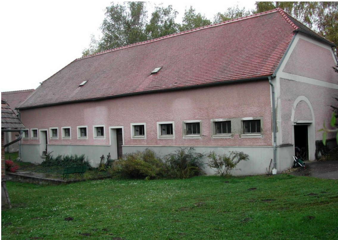
Abb.55: Nebengebäude (ehemalige Stallung) des Minoritenklosters; darin ist die Werkstätte Ferdinys ausgestellt
