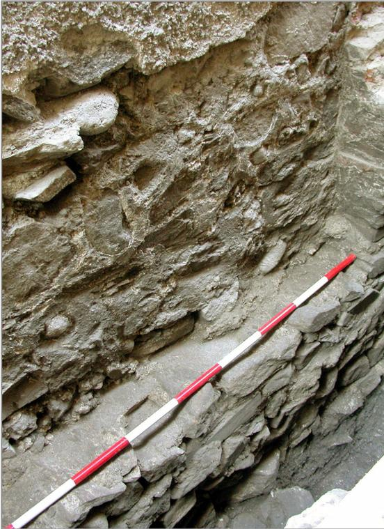
Abb. 110: St. Pölten, Dom: Mauerwerk der Klosterkirche 1 (um 1000 n. Chr.), heute Fundament der Südmauer des Domes
