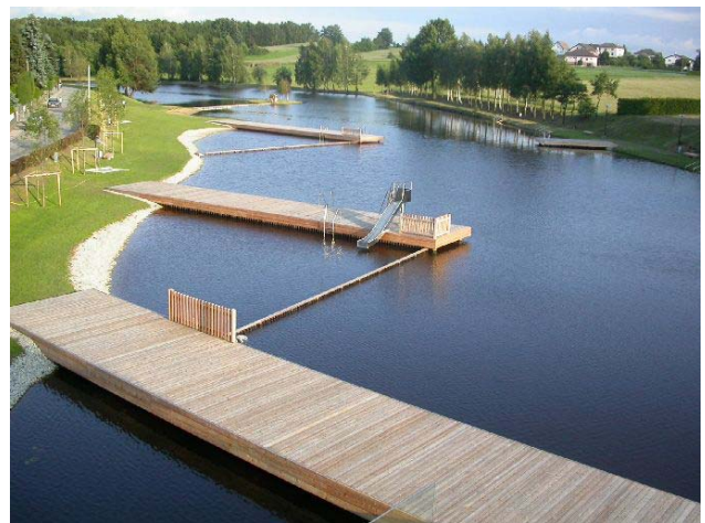
Abbildung 35: Neues Moorbad Schrems (Quelle: http://www.dorf-stadterneuerung.at/classen/bildanzeige.php?id=921 , Stand 04.04.2009)
