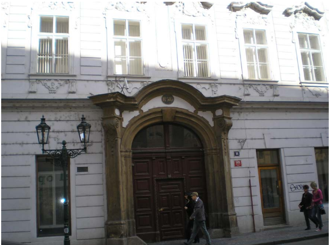
Abb. 73 Prag, Palais Langerovsky, Portal, 1737-1740
