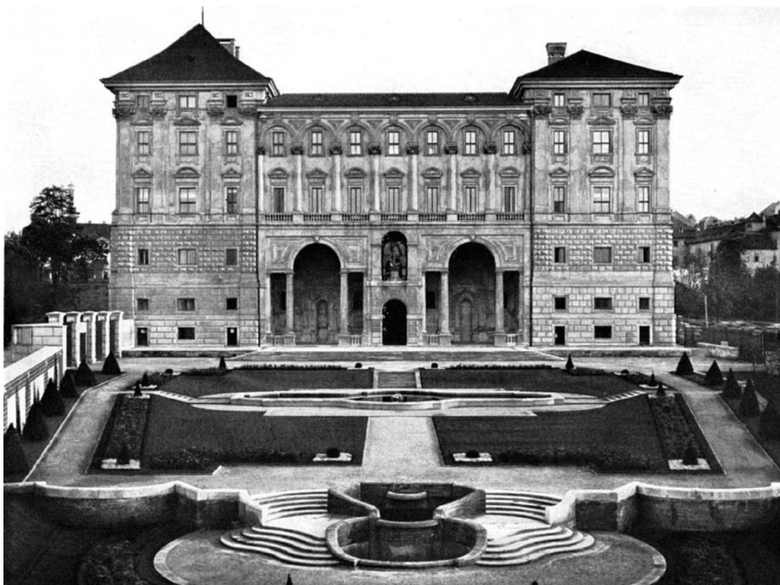
Abb. 74 Prag, Palais Czernin, 1669, Gartenfassade
