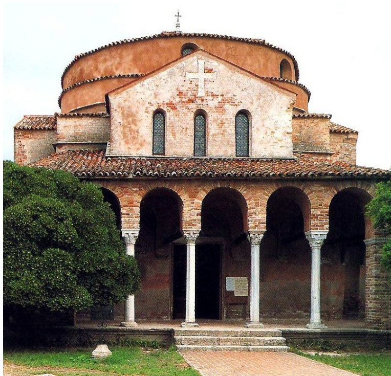
Abbildung 18 Santa Fosca. Außenansicht.
