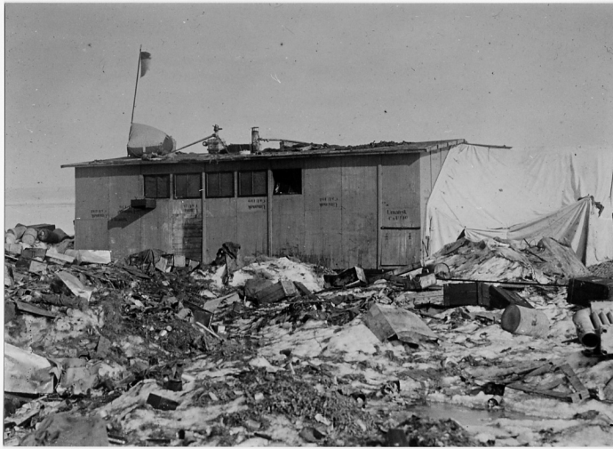
Abbildung 5-3: Weststation - Rückseite des Hauses 28
