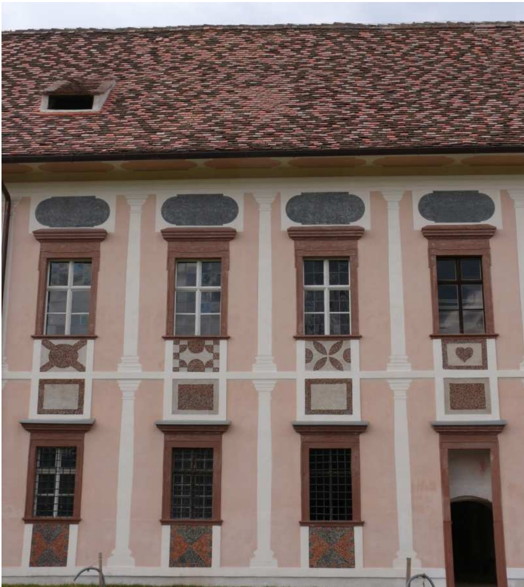
Abbildung 26: Detail Südfassade, Sommer 2008
