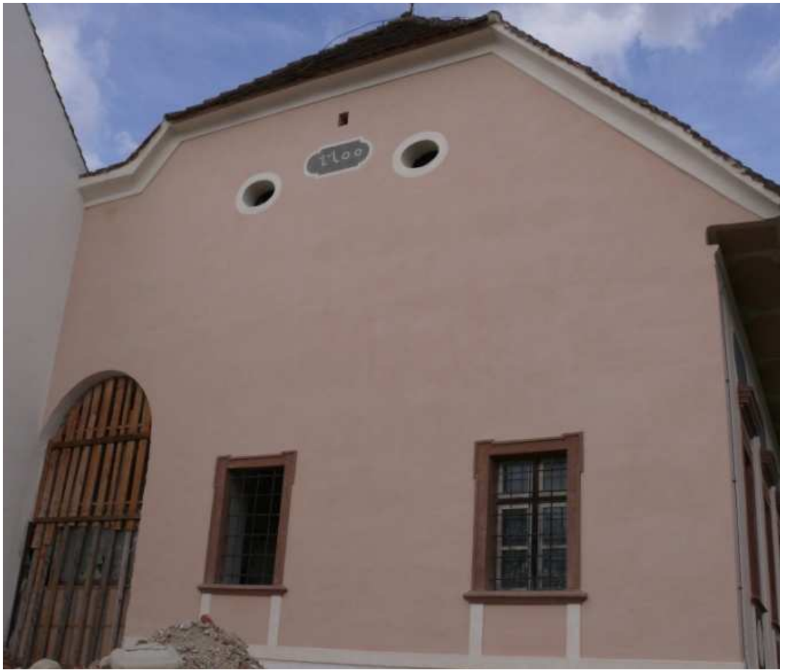
Abbildung 29: Westtrakt, alte Bausubstanz, Sommer 2008
