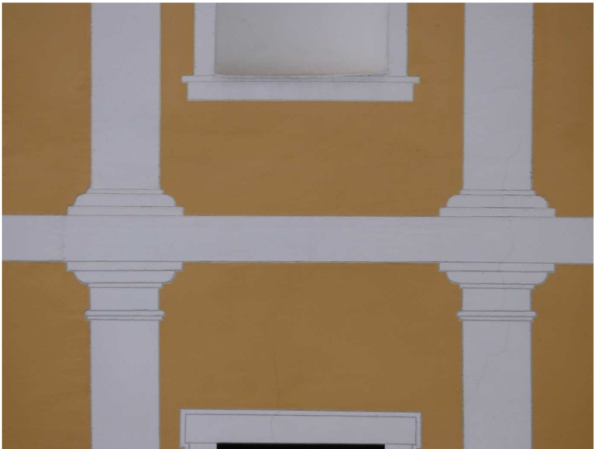
Abbildung 168: Detail Putzpilaster von Schloss Gleinstätten
