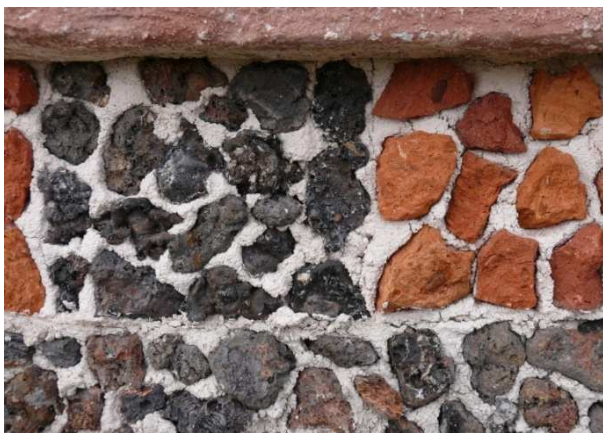
Abbildung 141: Detail, Putzfeld; Ziegel- und Tuffsteine
