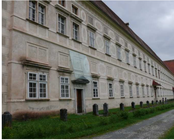
Abbildung 174: Stift St. Lambrecht Fassade, Frühjahr 2008
