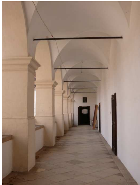
Abbildung 33: Arkadenumgang mit Kreuzgratgewölbe, März 2008
