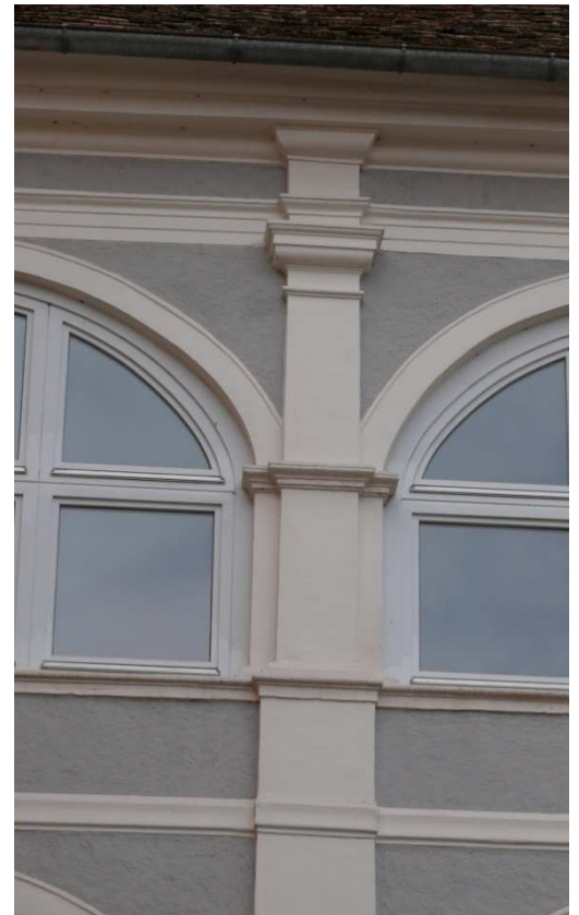
Abbildung 160: Detail oberstes Arkadengeschöß in Pöllau
