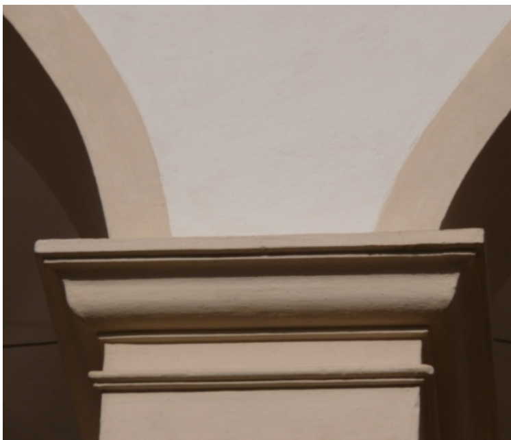
Abbildung 139: Detail Pfeiler, Sommer 2008
