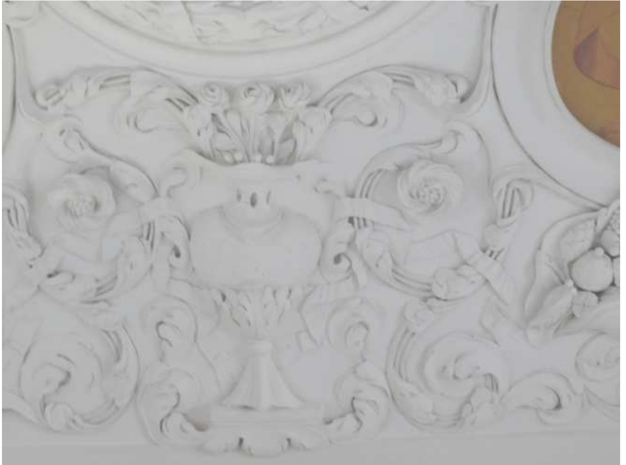
Abbildung 78: Detail Stuckverzierung, Speisezimmer
