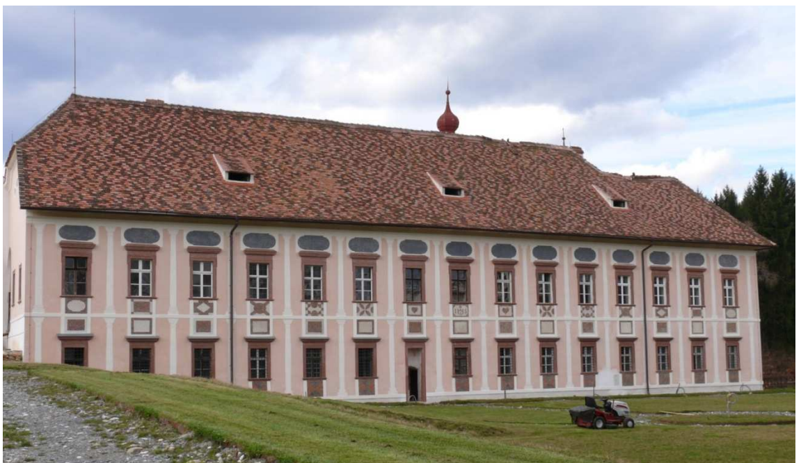
Abbildung 25: Südfassade Schloss Külm, Sommer 2008
