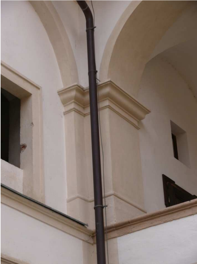
Abbildung 138: Ecklösung zwischen Nordtrakt und Westtrakt, Sommer 2008
