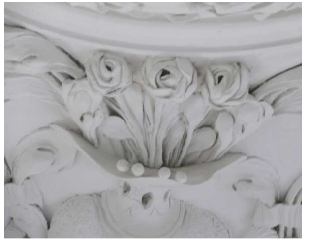
Abbildung 80: Detail Stuckverzierung, Speisezimmer
