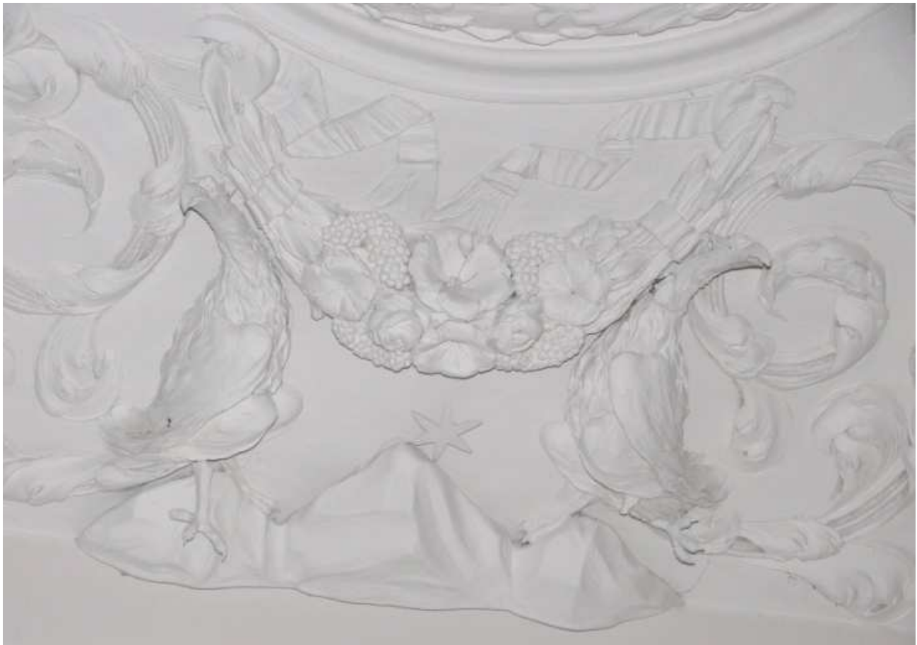
Abbildung 77: Detail Stuckverzierung, Speisezimmer
