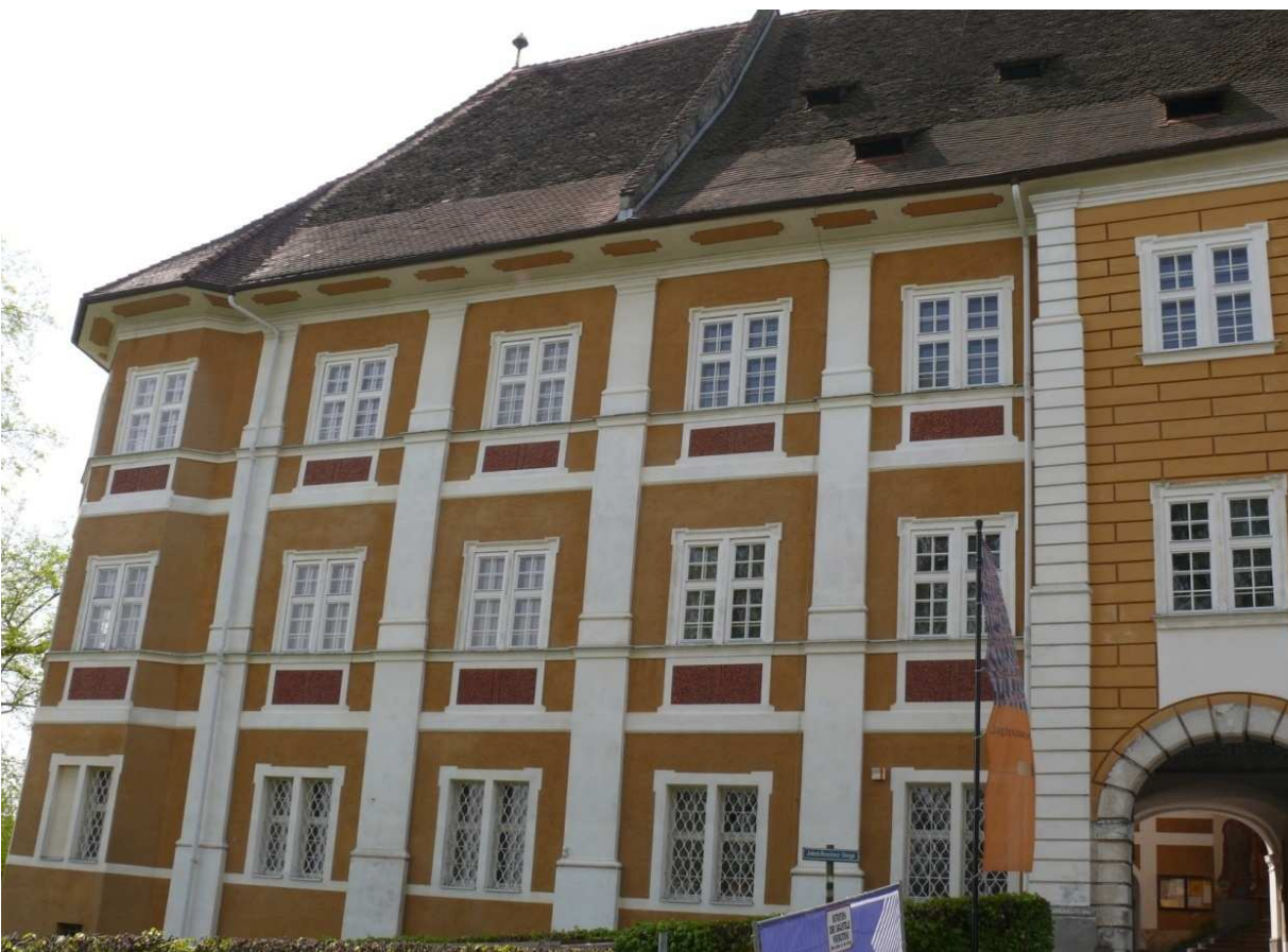
Abbildung 151: Hauptfassade Schloss Stainz, Sommer 2008
