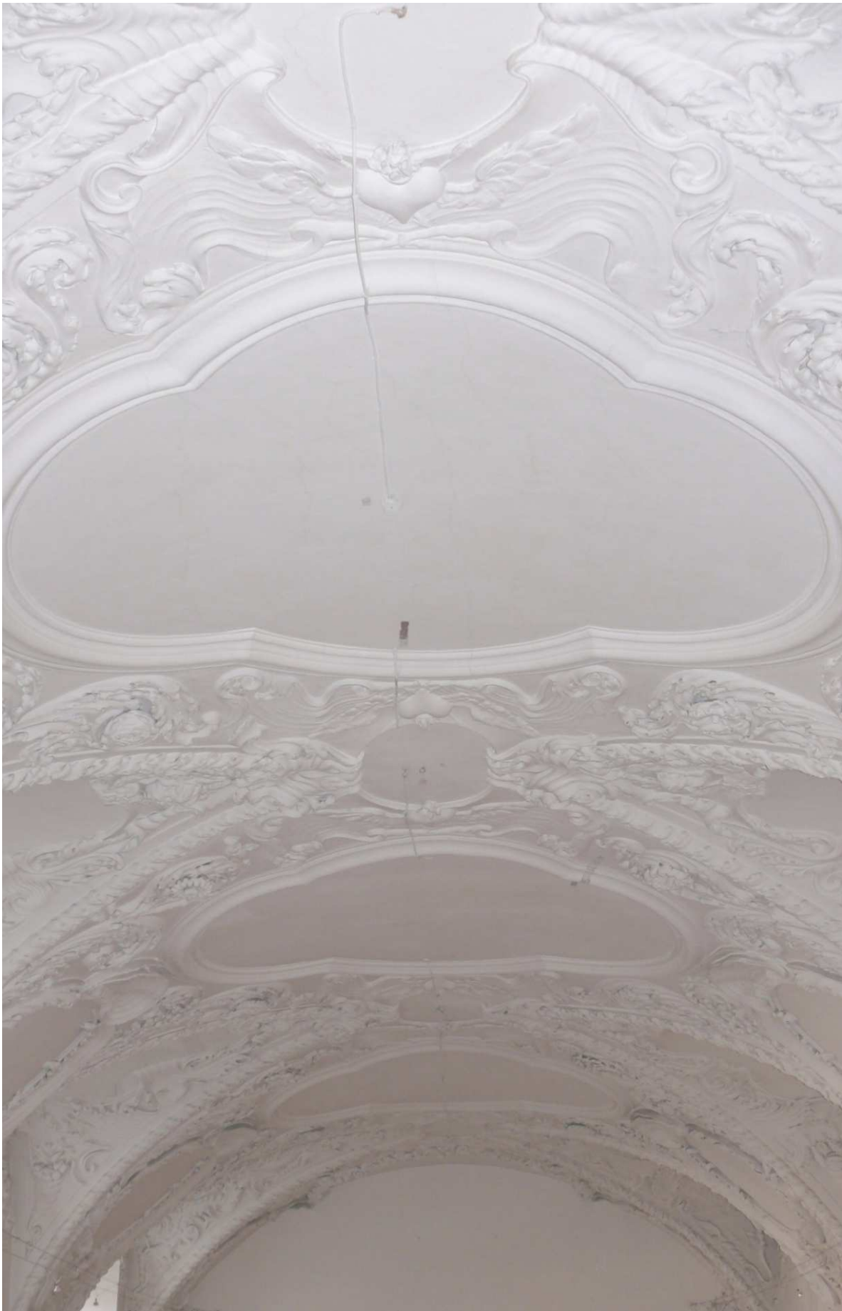
Abbildung 128: Deckenaufblick, ehem. Speisesaal, März 2009
