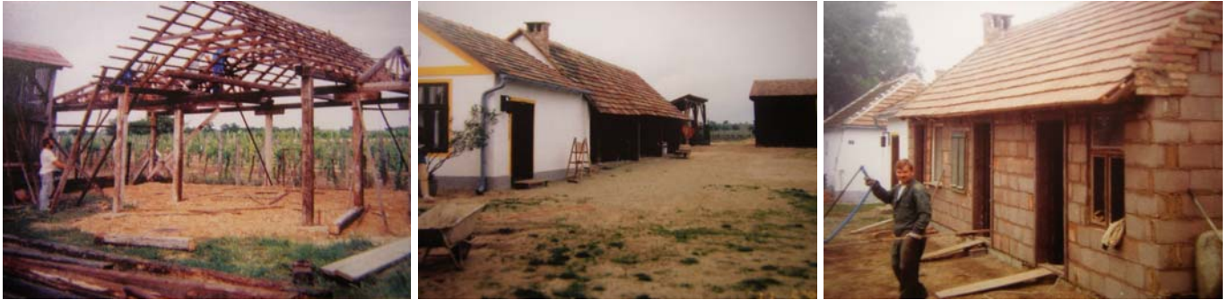
Abb. 27-29: Das Holzgerüst des Wirtshauses ist fertig.
