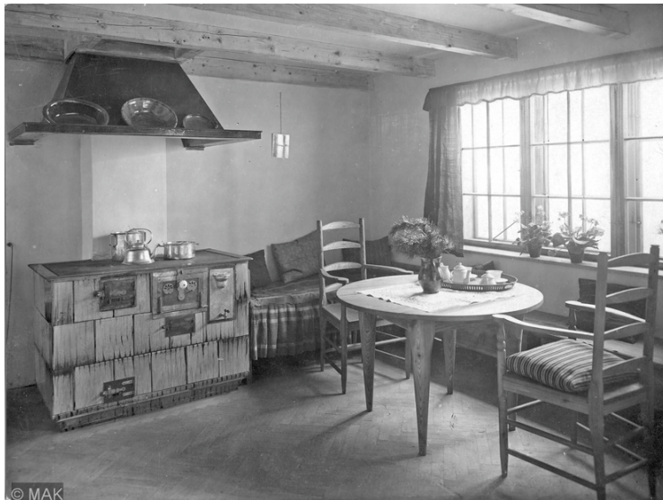
Abb. 107 Josef Frank, Wohnküche in einem Siedlungshaus, Einfacher Hausrat, ÖMKI, 1920 (MAK)
