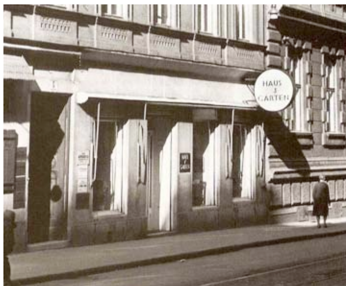
Abb. 72 Geschäftslokal von Haus & Garten, Außenansicht (ÖNB)
