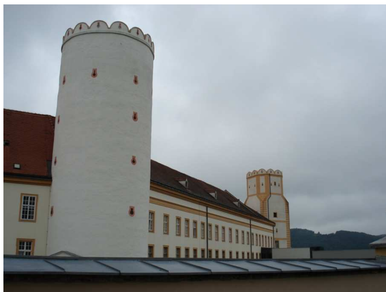
Abb. 2: Schimmelturm im Vordergrund, Gartenmauer als Verbindung der beiden Türme, Pulverturm im Hintergrund, Stift Melk
