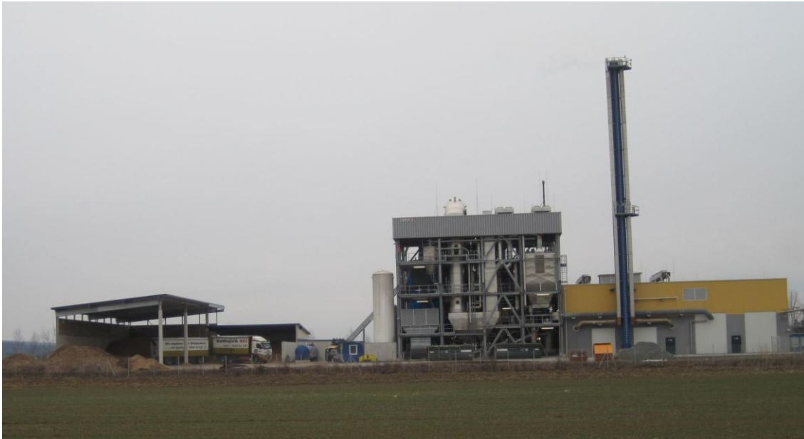
Abbildung 5.3-1: Biomassekraftwerk Oberwart Quelle: Eigenfotografie
