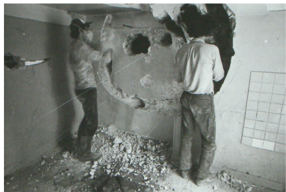
Abb. 46 Bauarbeiten an CONICAL INTERSECT, 1975 Fotografie, schwarzweiß Maße unbekannt © Marc Petitjean
