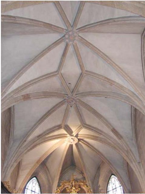
Abb. Nr. 295: Muthmannsdorf, Pfarrkirche, Chorgewölbe
