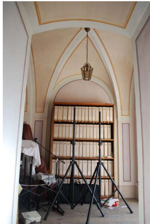
Abb. Nr. 48: Emporenbereich – Raum über dem südwestlichen Langhausjoch
