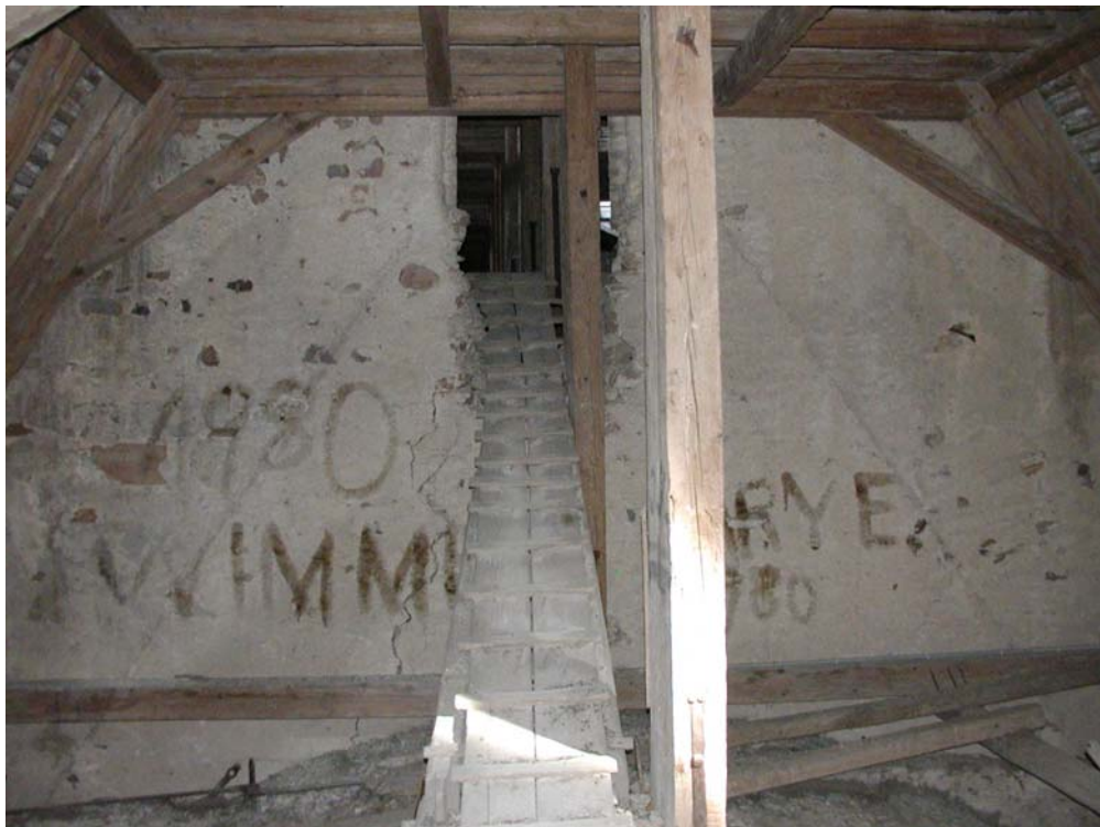
Abb. Nr. 113: Mittelschiffdachboden, Chorgiebelwand
