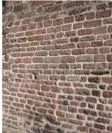
Abb. Nr. 216: Hirsau im Schwarzwald, ehem. Klosterkirche St. Aurelius, Mauerwerk Nordseite
