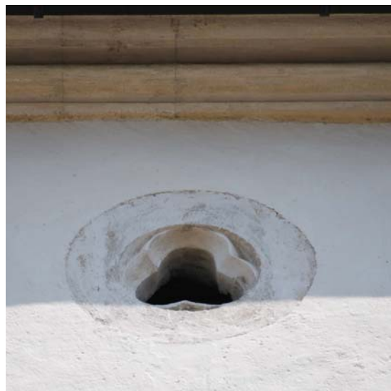
Abb. Nr. 28: Chor, Lüftungsöffnungen Dachraum
