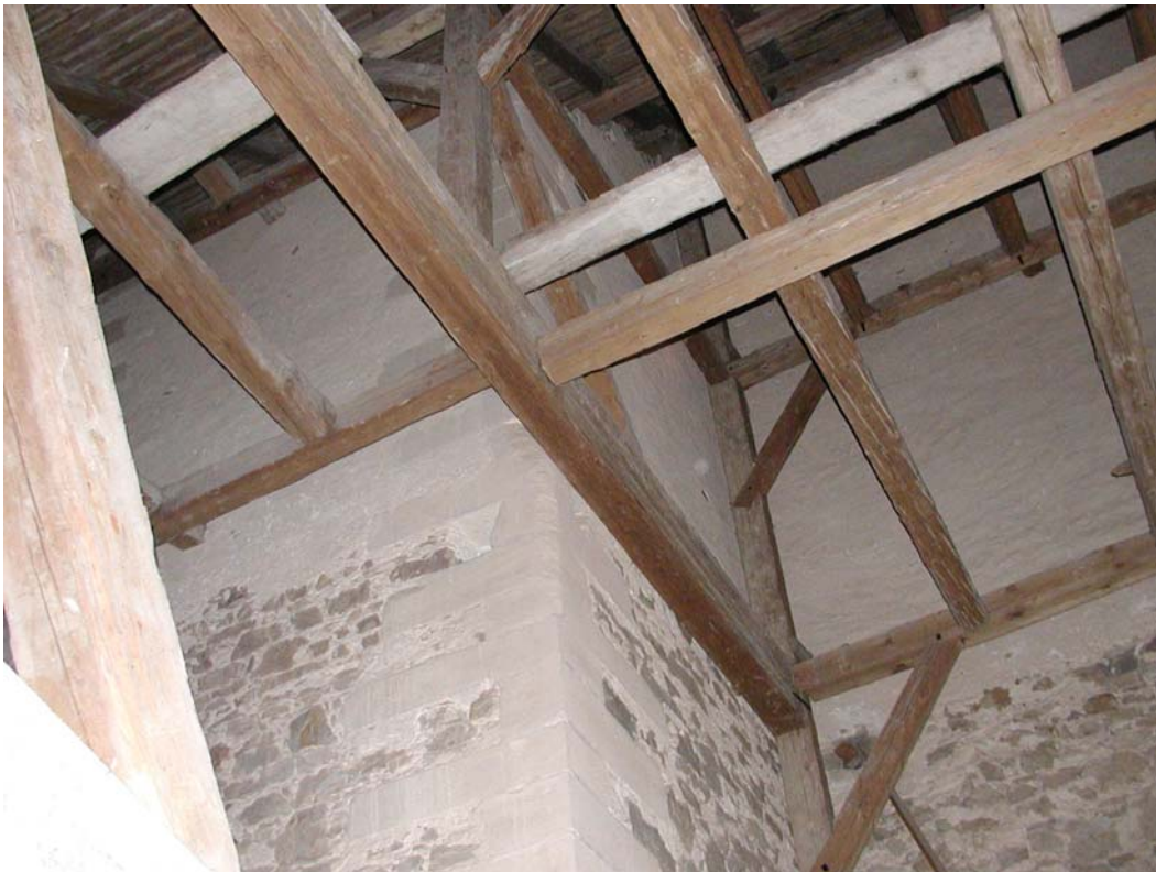
Abb. Nr. 144: Sommersakristei, Dachraum, Aufsicht zum Treppenturm - ehem. Dachansatz/Putzkante
