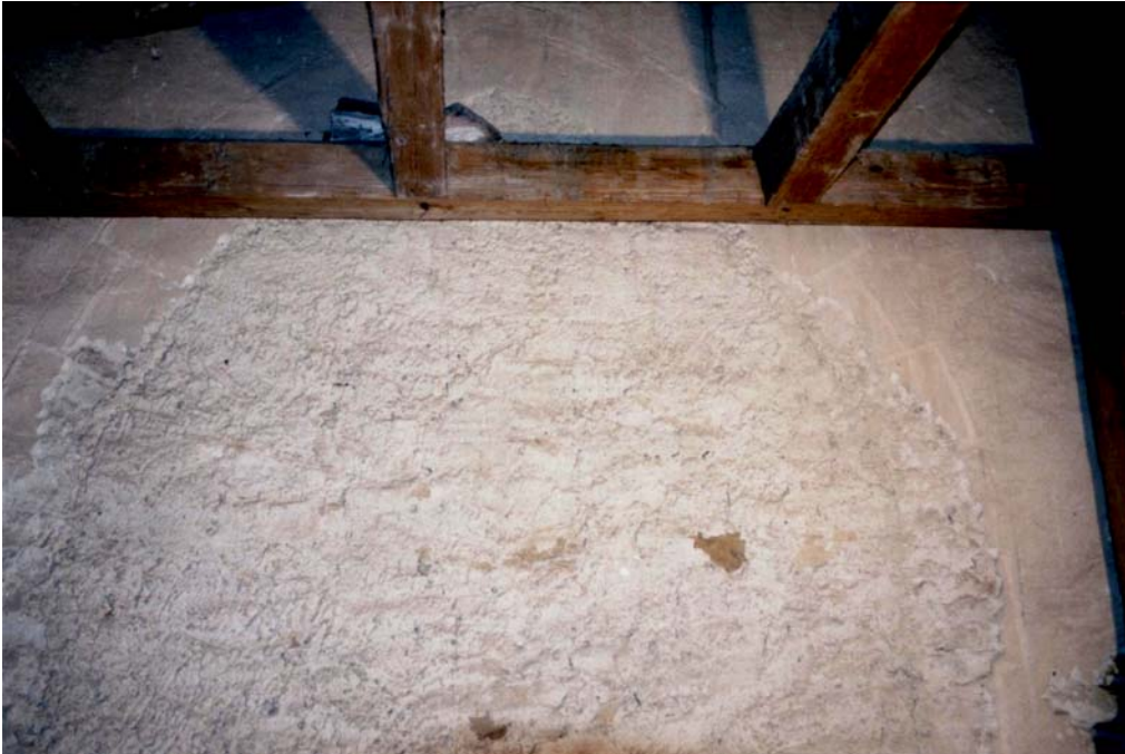
Abb. Nr. 120: Südseitenschiff, Dachboden, abgemauertes Langhausfenster
