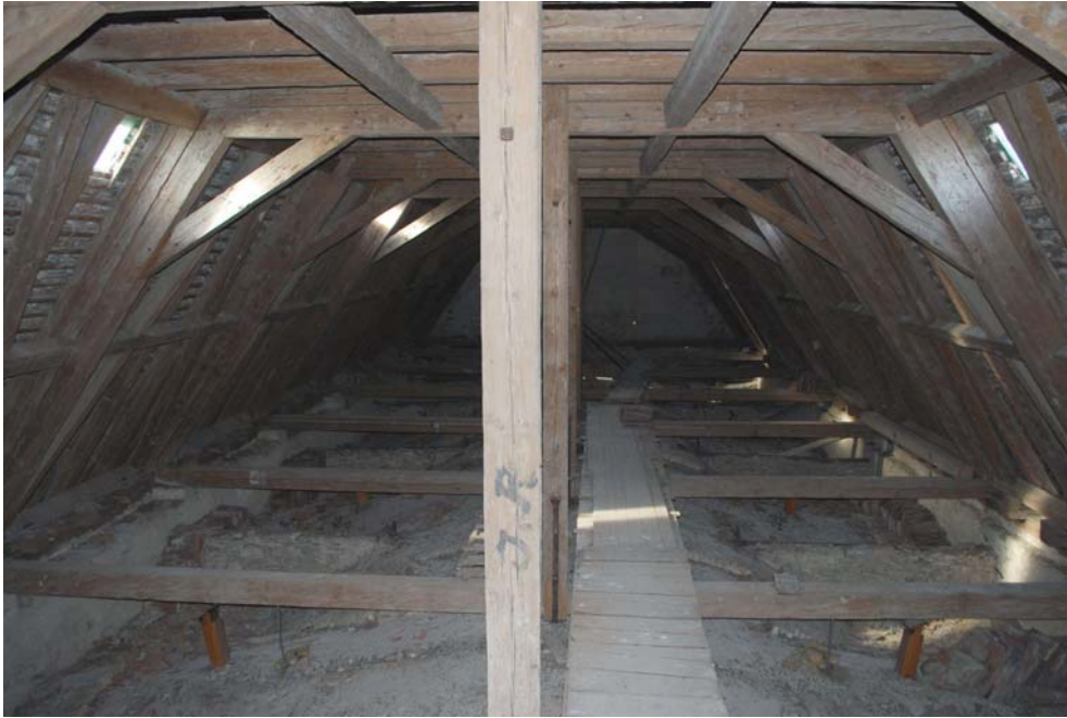
Abb. Nr. 106: Dachraum über dem Mittelschiff, Einblick nach Westen
