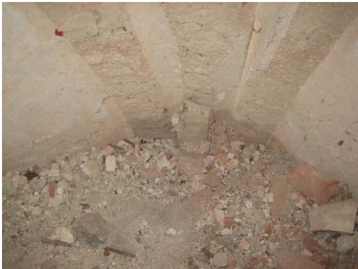
Abb. Nr. 186: Wintersakristei Dachraum, ehem. Gewölbeanlauf -
