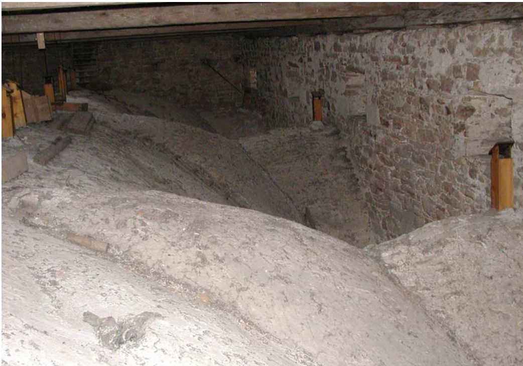
Abb. Nr. 102: Chordachboden, Gewölbeschale, Südseite
