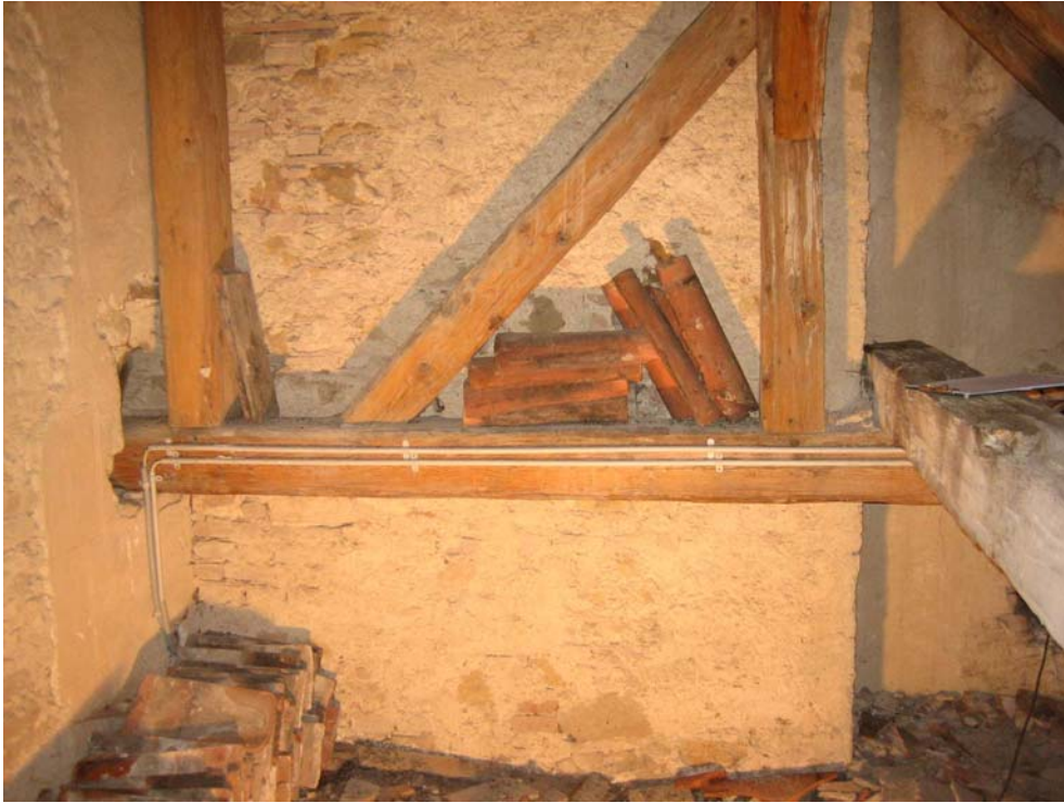
Abb. Nr. 124: Südseitenschiff, Dachboden, angestellter Strebepeiler Achse 1
