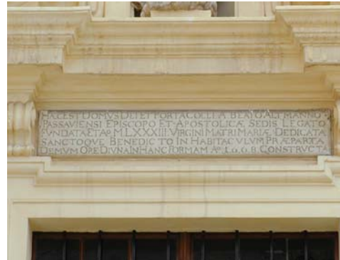
Abb. Nr. 14: Südportal, Bauinschrift
