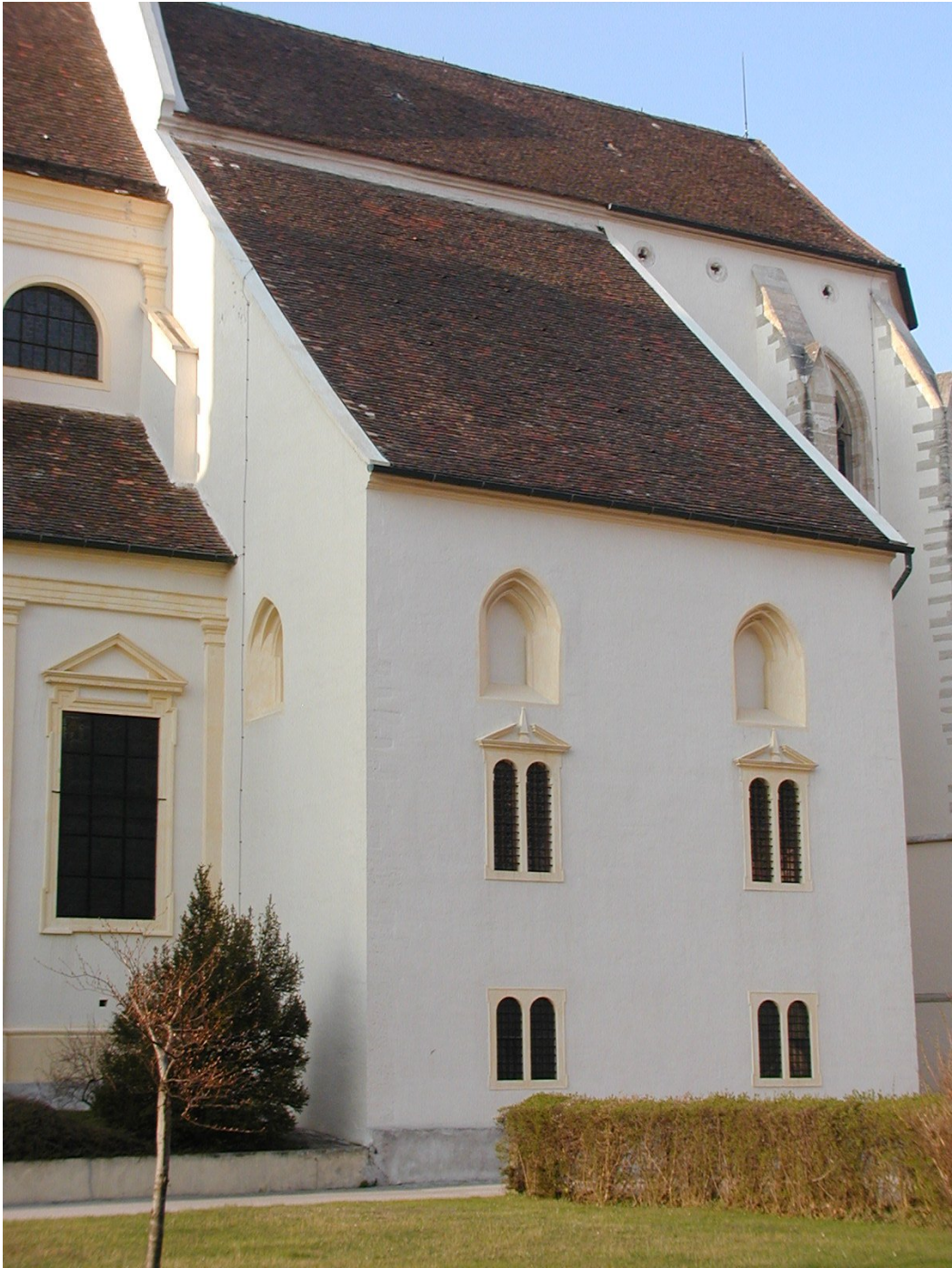
Abb. Nr. 29: Sommersakristei, Ansicht von Südwesten
