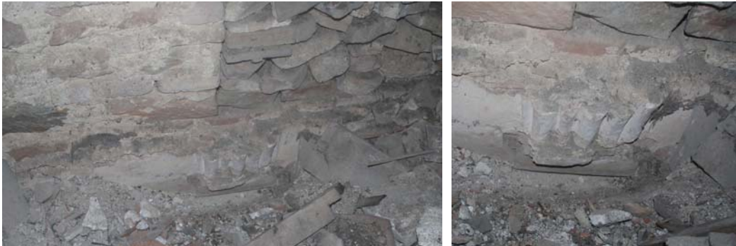
Abb. Nr. 167-168: Dachraum Nordseitenschiff, Bereich III., Ansätze einer ehem. Wölbung
