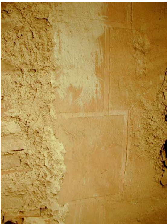
Abb. Nr. 121: Südseitenschiff, Dachboden, ehem. Langhausfenster , Quaderung
