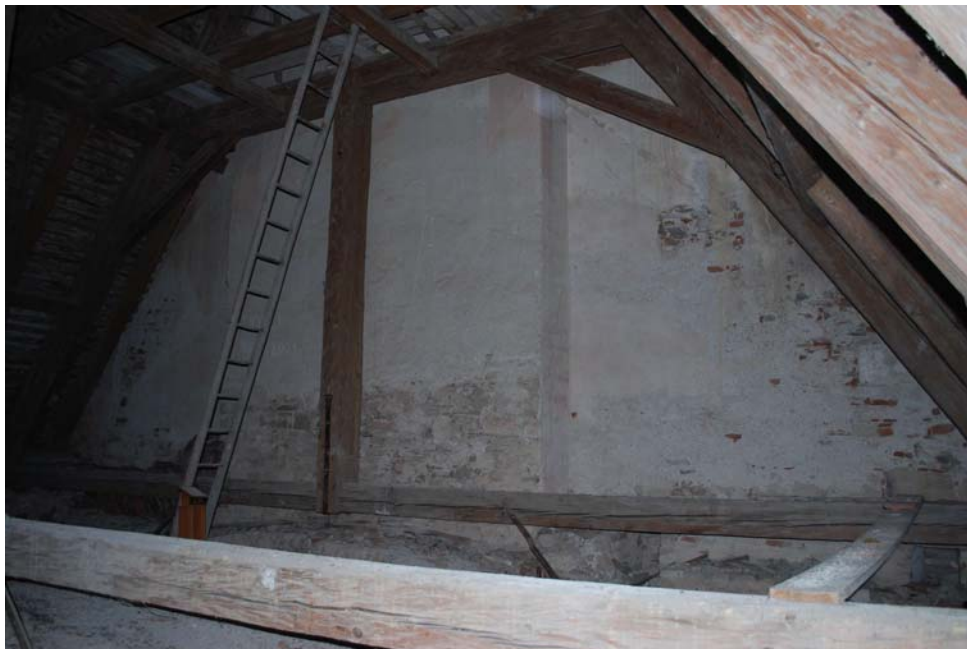
Abb. Nr. 114: Mittelschiffdachboden, westliche Giebelwand
