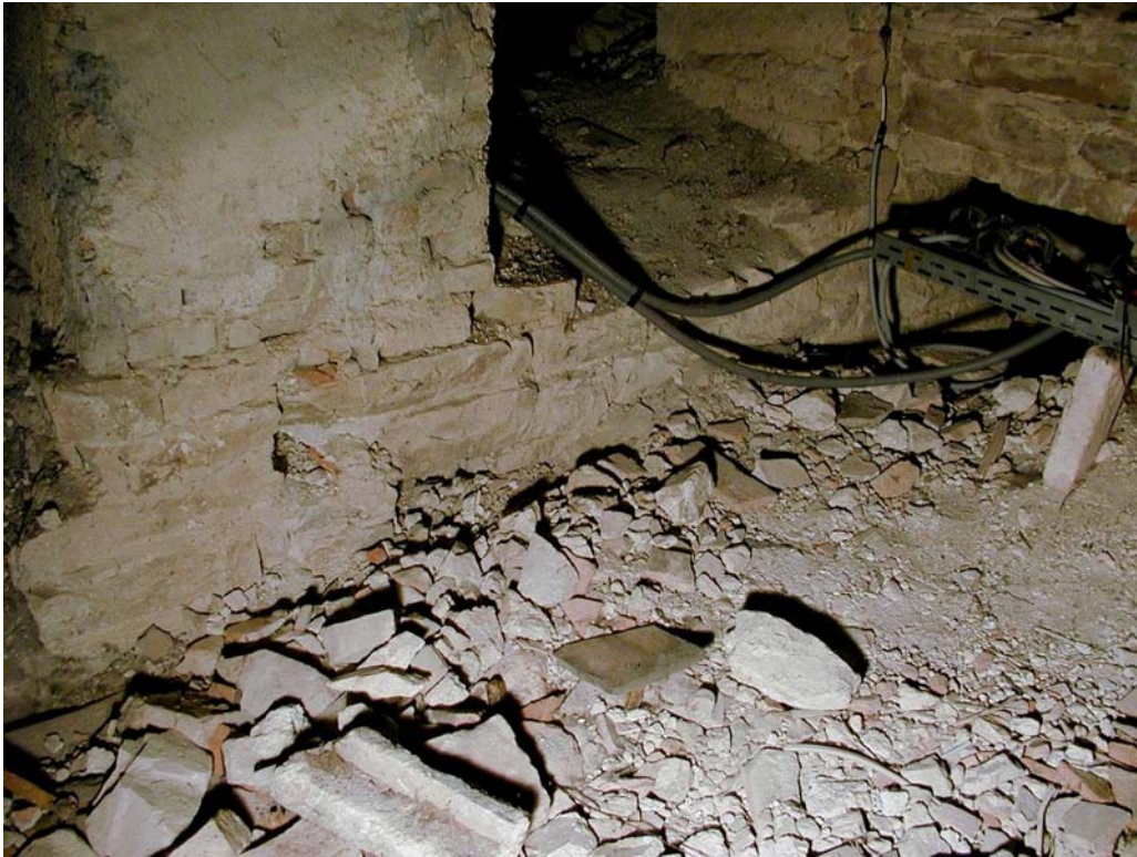
Abb. Nr. 177: Dachraum Kreuzgang Bereich IV. Achse 0, romanische Quermauer
