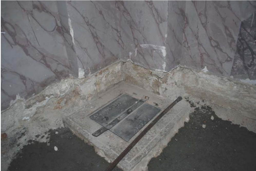
Abb. Nr. 133: Südseitenschiff, Südwestjoch, Mauerwerk auf Fußbodenniveau, Umbauarbeiten 2010
