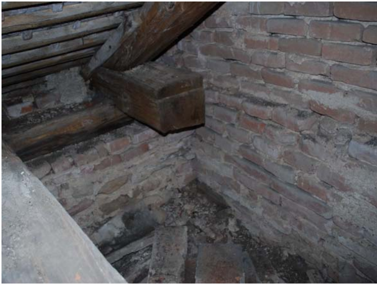
Abb. Nr. 195: Wintersakristei Dachraum, Einblick nach Nordosten (Ostwand-Nordwand)
