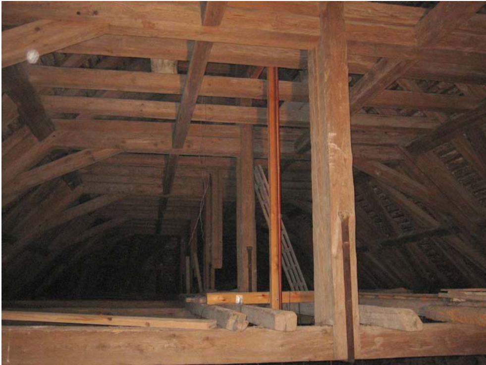
Abb. Nr. 104: Chordachwerk (Hängewerk), Einblick nach Osten
