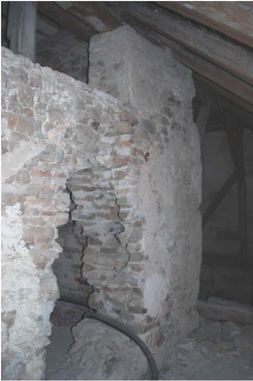
Abb. Nr. 154: Dachraum Kreuzgang/Nordseitenschiff, Bereich II., Westwand ostseitig
