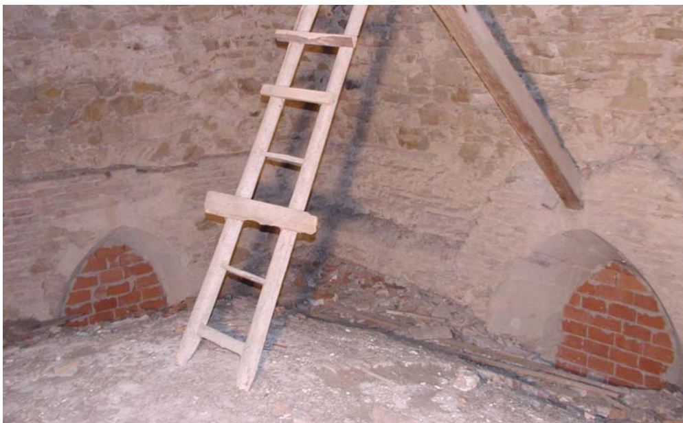
Abb. Nr. 140: Sommersakristei, Dachraum, Einblick nach Südosten – vermauerte Spitzbogenfenster
