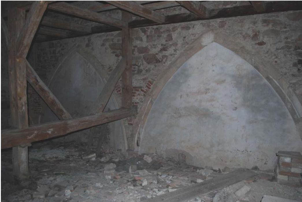
Abb. Nr. 183: Wintersakristei Dachraum, Einblick nach Norden
