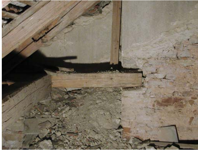
Abb. Nr. 171: Dachraum Nordseitenschiff, Bereich III., Achse 1 westseitig Anstellungssituation neuzeitlicher Strebepfeiler
