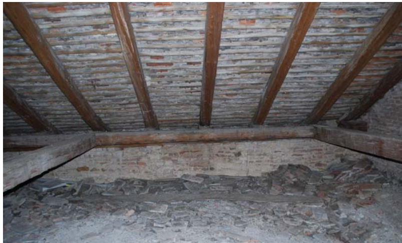
Abb. Nr. 190: Wintersakristei Dachraum, Einblick nach Norden
