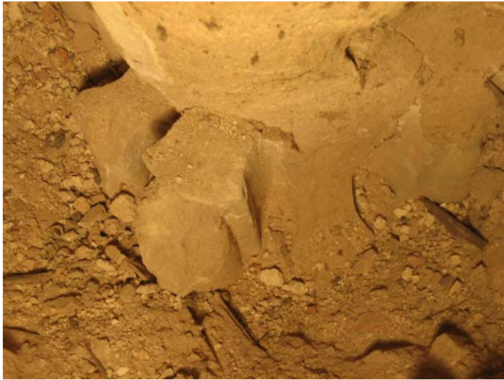
Abb. Nr. 185: Wintersakristei Dachraum, ehem. Gewölbeanlauf - Mitte
