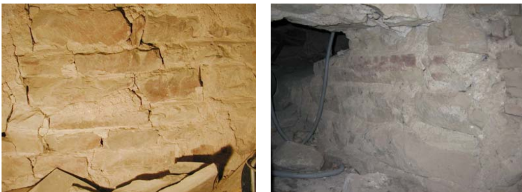
Abb. Nr. 178-179: Dachraum Kreuzgang Bereich IV. Achse 0, romanische Quermauer, Details
