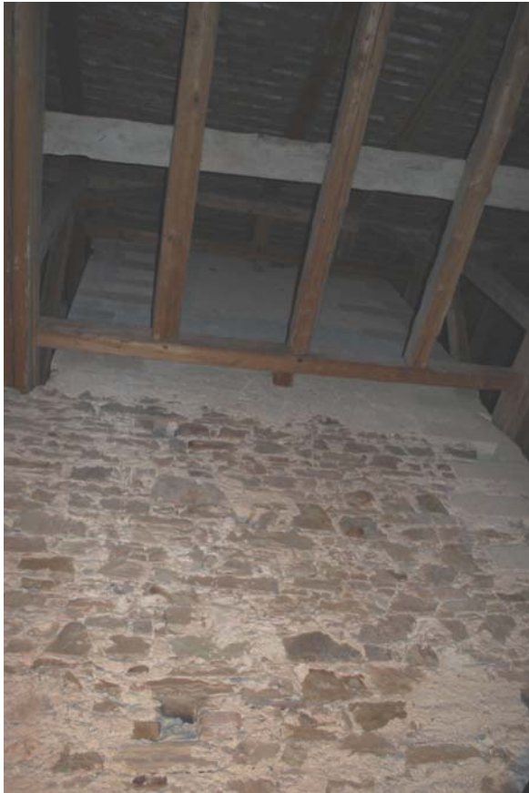
Abb. Nr. 141: Sommersakristei, Dachraum, Aufsicht zum Treppenturm
