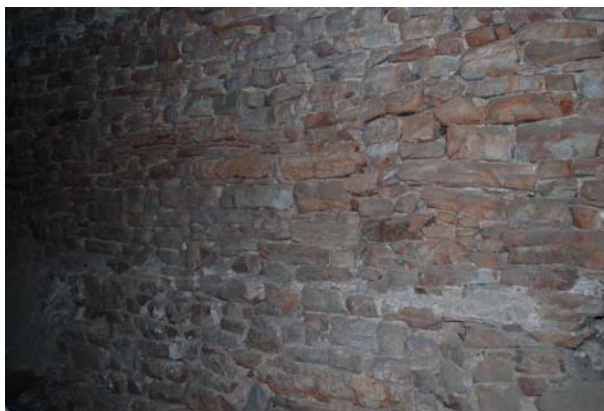
Abb. Nr. 163: Dachraum Kreuzgang, Bereich III., Seitenschiffwand
