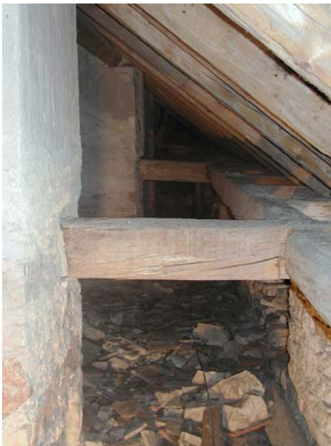
Abb. Nr. 172: Dachraum Nordseitenschiff, Einblick nach Westen
