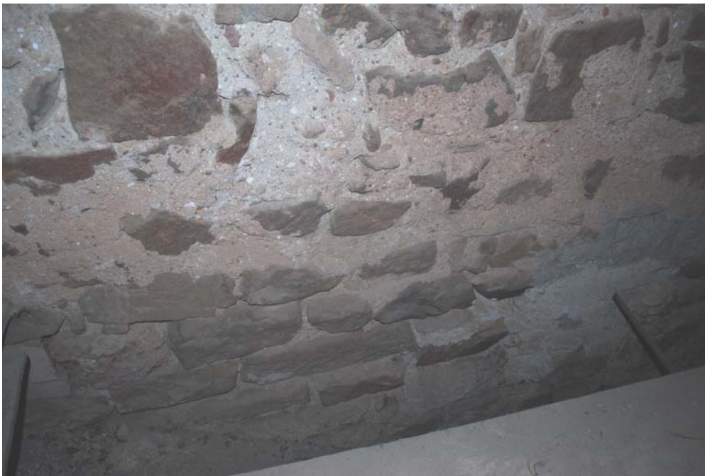
Abb. Nr. 201: Ehem. Stiftskirche Ardagger, Kreuzgang Südflügel, Nordseitenschiffmauer – romanisches Mauerwerk des Gründungsbaues
