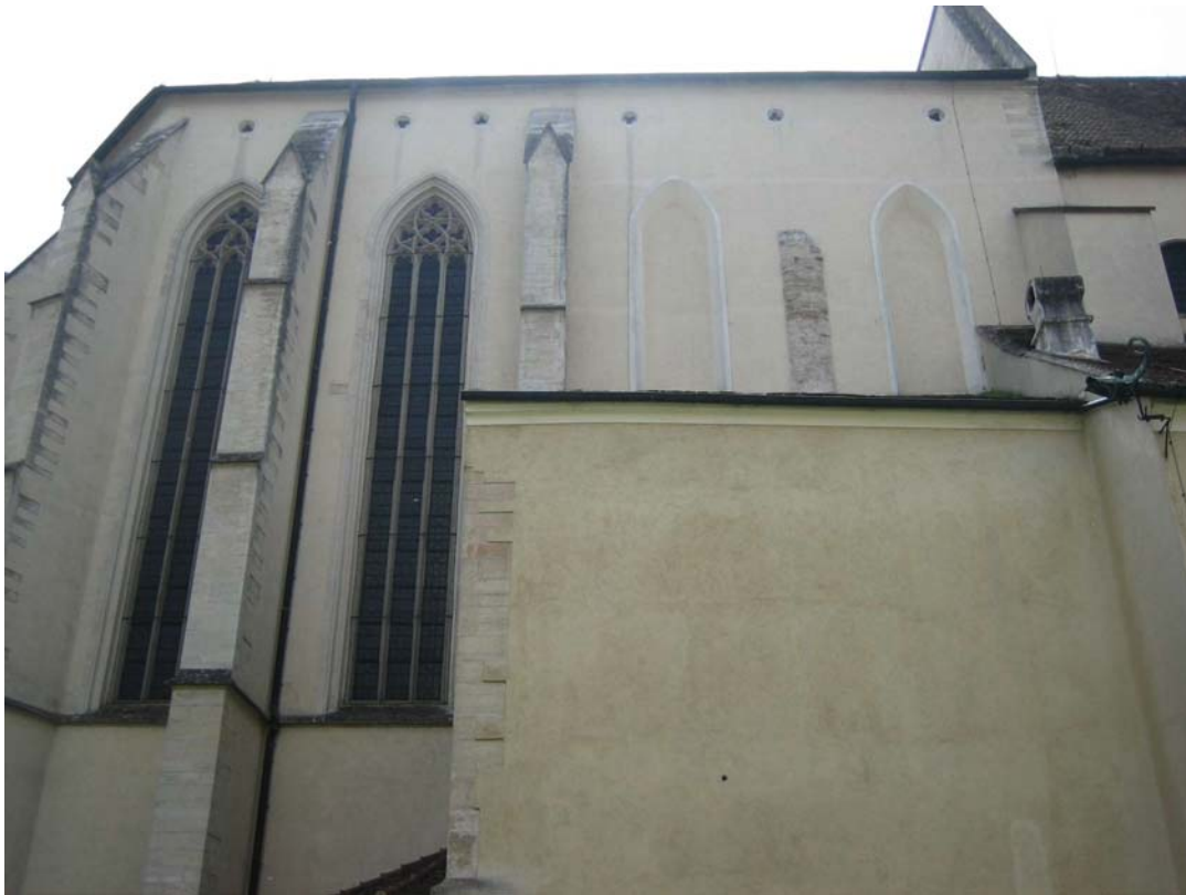
Abb. Nr. 27: Chor Nordseite
