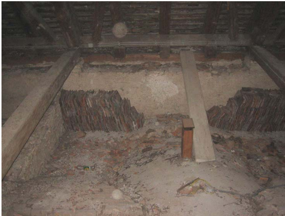
Abb. Nr. 108: Mittelschiffdachboden, Einblick nördliche Hochschiffwand
