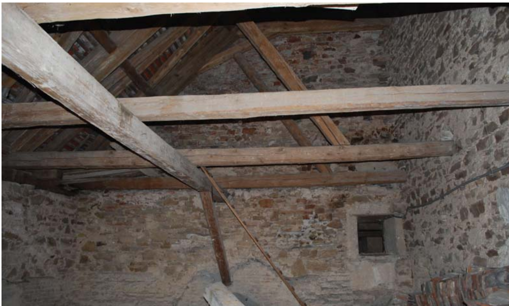
Abb. Nr. 137: Sommersakristei Dachboden, Einblick nach Westen
