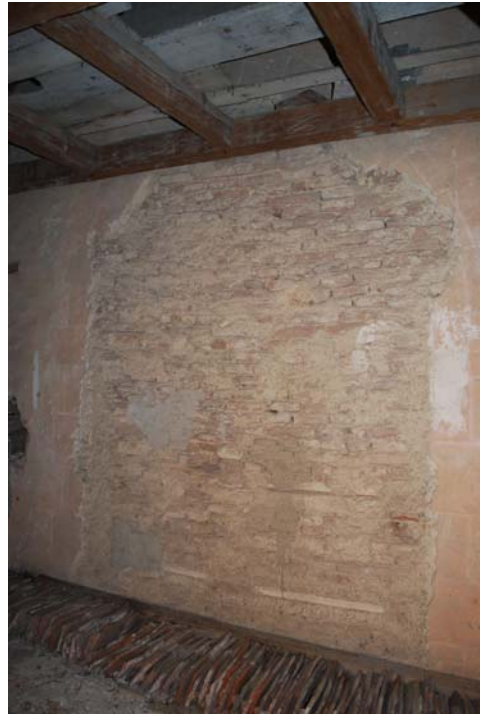
Abb. Nr. 323: Südseitenschiff Dachboden, vermauertes Spitzbogenfenster
