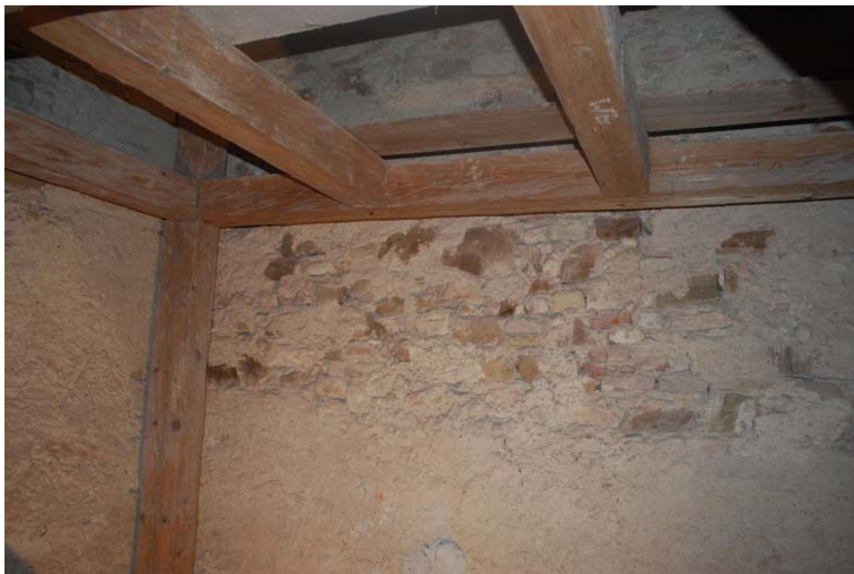
Abb. Nr. 129: Südseitenschiff, Dachboden, Hochschiffwand Bereich Achse 5-6
