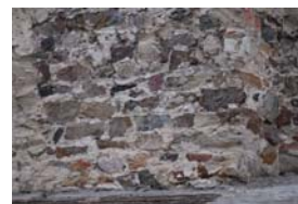
Abb. Nr. 207: Mautern, Margarethenkapelle, Mauerwerk Südseite
