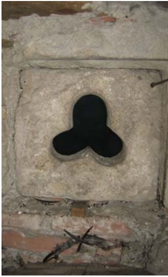
Abb. Nr. 101: Chordachboden, Lüftungsöffnung
