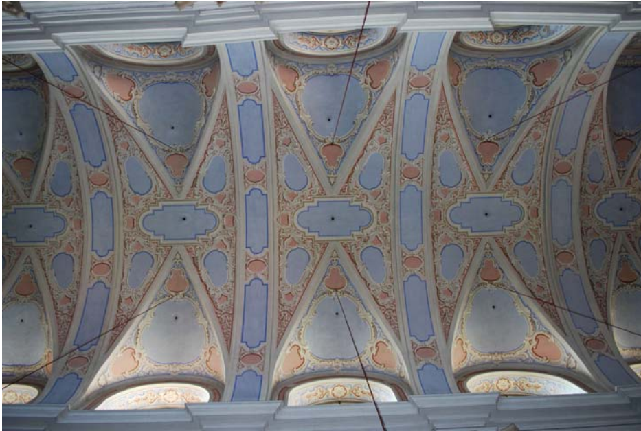
Abb. Nr. 37: Langhausgewölbe
