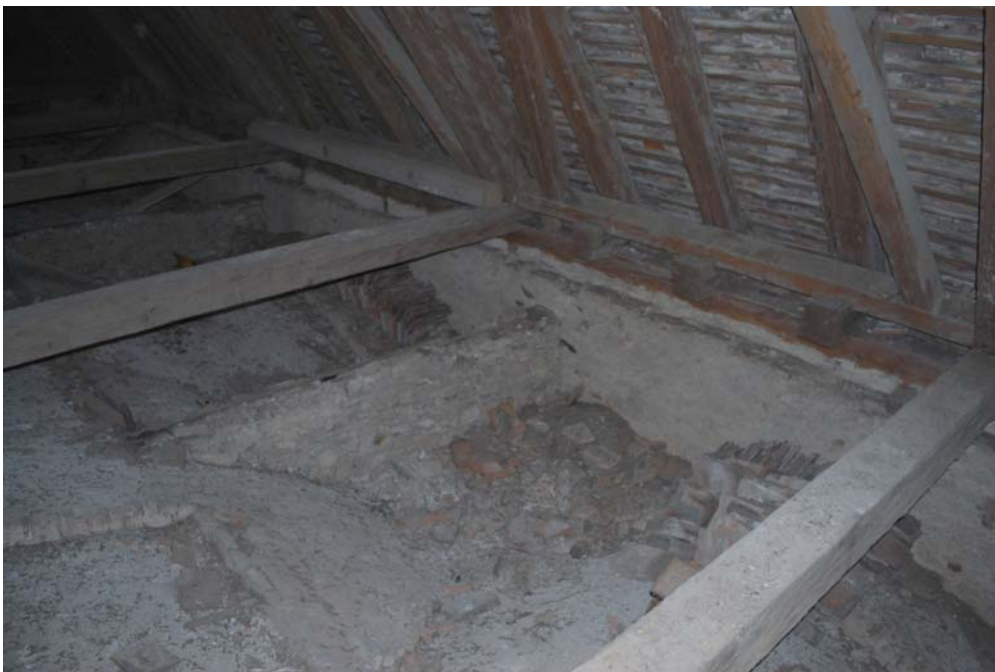
Abb. Nr. 107: Mittelschiffdachboden, Einblick südliche Hochschiffwand mit anschließenden Quermauern
