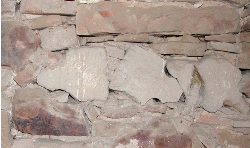
Abb. Nr. 164: Dachraum Kreuzgang, Bereich III., Seitenschiffwand, Spolien
