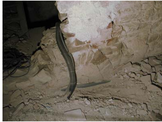
Abb. Nr. 156: Dachraum Kreuzgang/Nordseitenschiff, Bereich II., Rundbogenfenster, Nordseite
