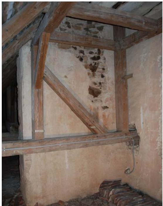
Abb. Nr. 116: Südseitenschiff, Dachboden, Strebepeiler (Achse 2)
