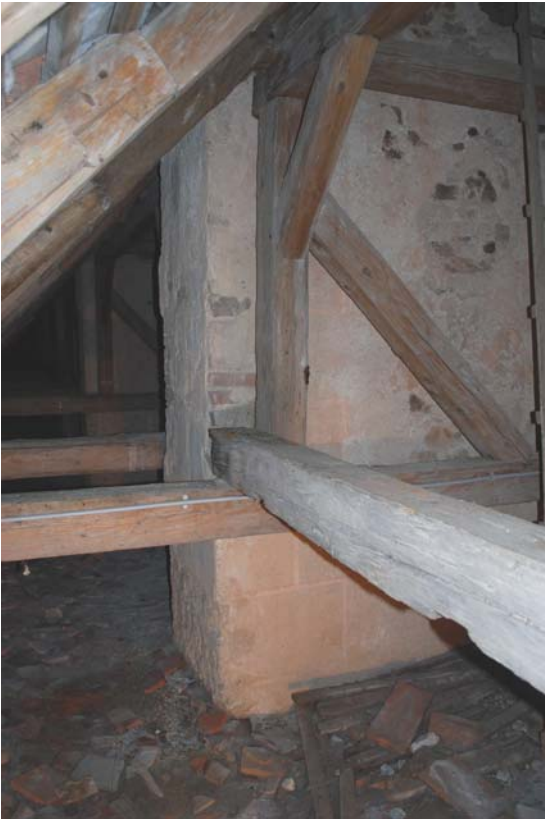
Abb. Nr. 122: Südseitenschiff, Dachboden, Strebepfeiler
