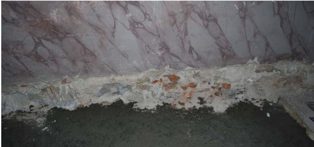
Abb. Nr. 132: Südseitenschiff, Südwestjoch, Mauerwerk auf Fußbodenniveau, Umbauarbeiten 2010
