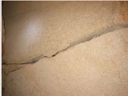
Abb. Nr. 145: Sommersakristei, Dachraum, Treppenturm – Bearbeitungsspuren Schariereisen
