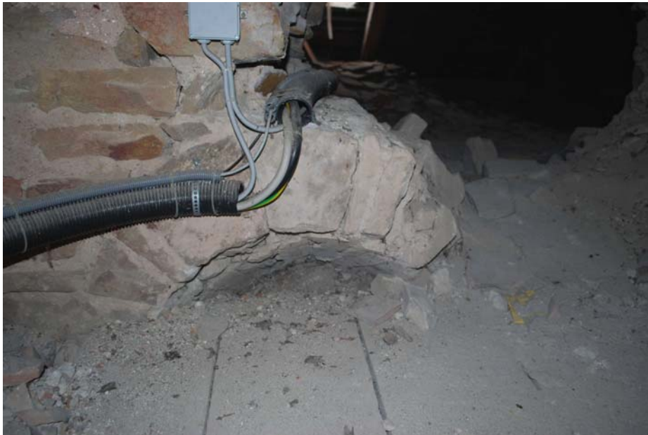
Abb. Nr. 155: Dachraum Kreuzgang/Nordseitenschiff, Bereich II., Westwand ostseitig
