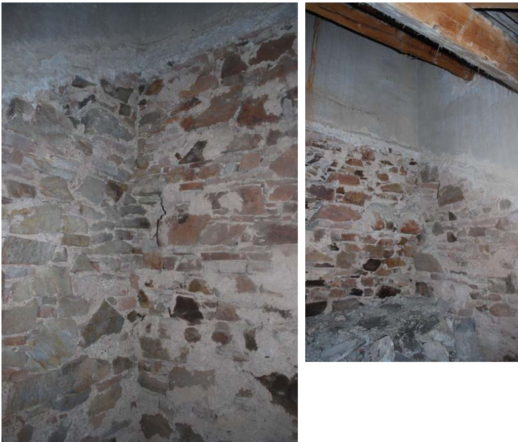
Abb. Nr. 169-170: Dachraum Nordseitenschiff, Bereich III., Hochschiffwand mit ehem. Dachansatz
