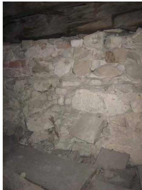
Abb. Nr. 119: Südseitenschiff, Dachboden, südliche Außenmauer – Ansatz ehem. Quermauer
