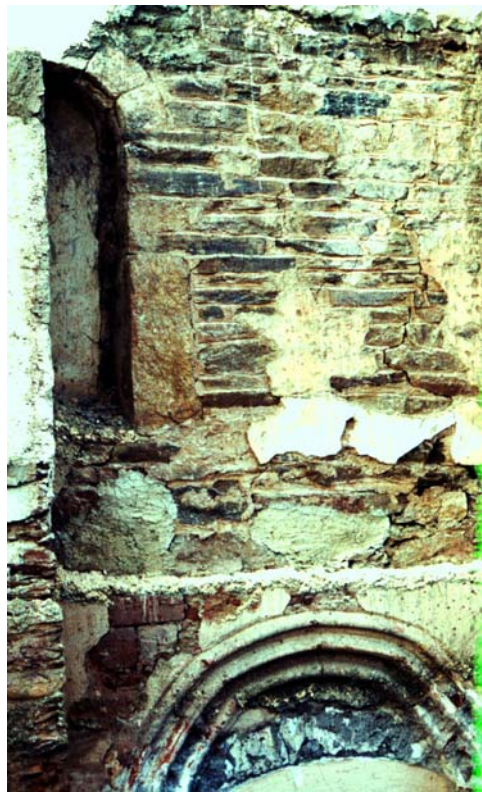
Abb. Nr. 198: Horn Pfarrkirche, Langhausmauerwerk. Foto: Oliver Fries
