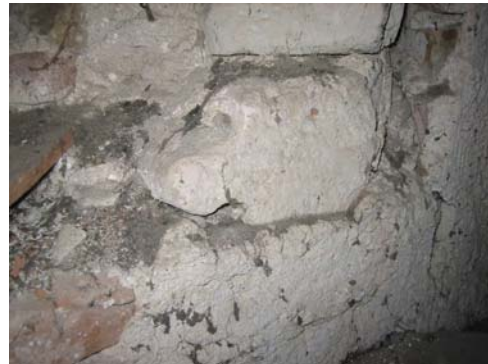
Abb. Nr. 112: Mittelschiffdachboden, Baukörper, Spolie
