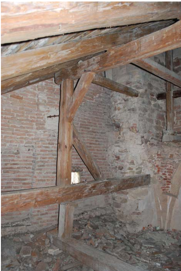
Abb. Nr. 196: Wintersakristei Dachraum, Einblick nach Südosten (Ostwand-Südwand)
