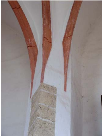
Abb. Nr. 279: Schwallenbach, Filialkirche, Wandpfeiler, Gewölbeanlauf
