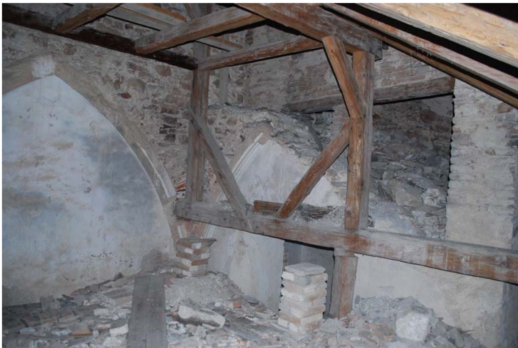
Abb. Nr. 184: Wintersakristei Dachraum, Einblick nach Nordwesten
