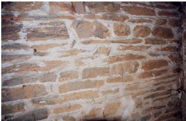
Abb. Nr. 197: Horn Pfarrkirche, Langhausmauerwerk
