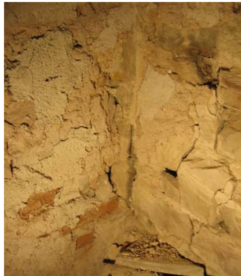
Abb. Nr. 153: Dachraum Kreuzgang/Nordseitenschiff, Bereich II., Westwand ostseitig Mauerverband
