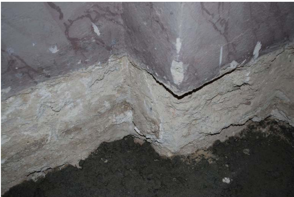
Abb. Nr. 134: Südseitenschiff, Südwestjoch, Mauerwerk auf Fußbodenniveau, Umbauarbeiten 2010
