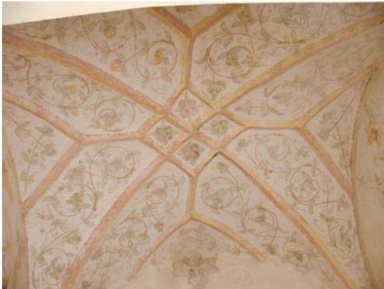
Abb. Nr. 318: Sitzendorf an der Schmida, Pfarrkirche, Vorhalle, Gewölbe
