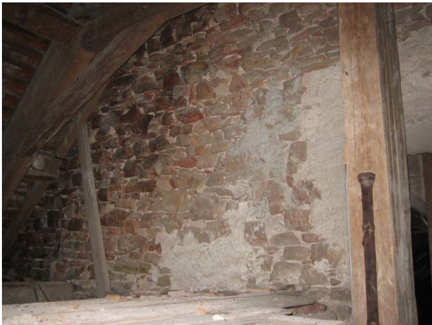
Abb. Nr. 100: Chordachboden, Giebelwand, Mauerwerk
