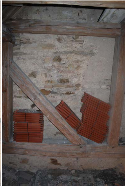
Abb. Nr. 131: Südseitenschiff, Dachboden, Strebepfeiler Achse 7
