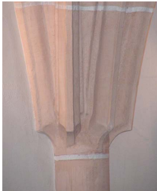
Abb. Nr. 83: Krypta, Hauptraum, Gewölbeanlauf, Detail
