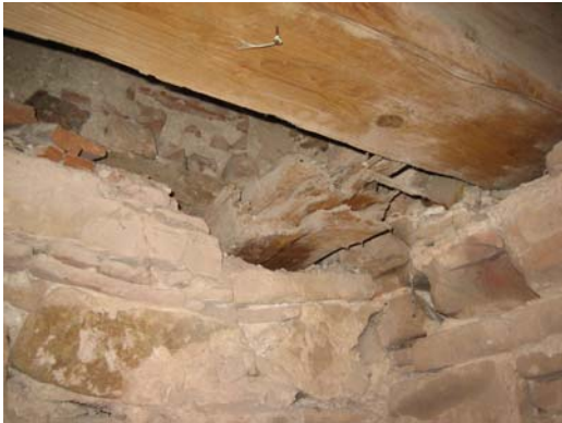
Abb. Nr. 143: Sommersakristei, Dachraum, Balkenkopf (1608) eines ehem. Dachwerkes
