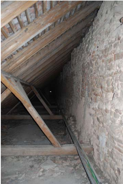
Abb. Nr. 146: Kreuzgang Südflügel - Nordseitenschiff, Dachraum, Einblick Richtung Osten
