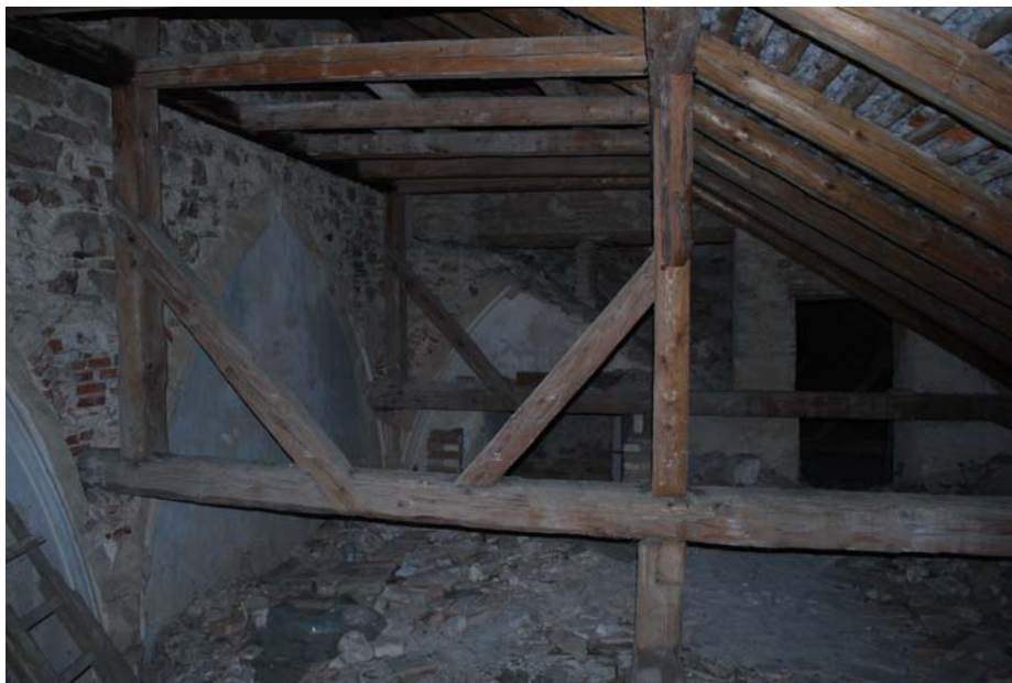
Abb. Nr. 182: Wintersakristei Dachraum, Einblick nach Westen
