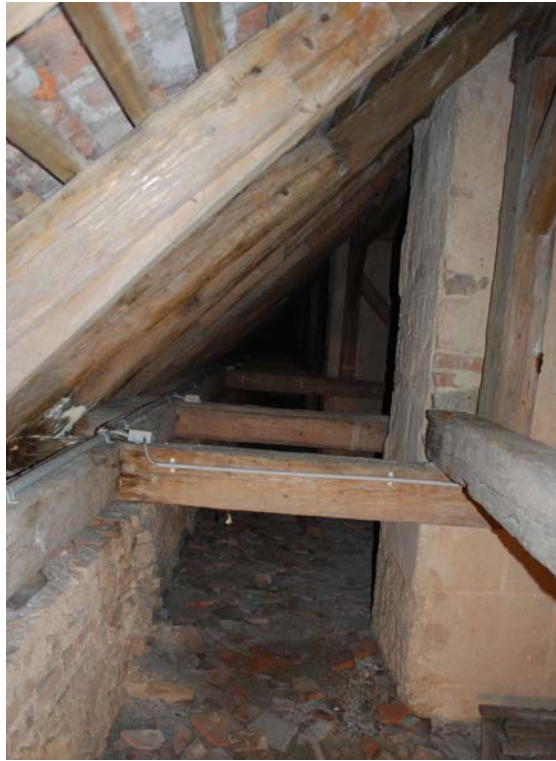
Abb. Nr. 115: Südseitenschiff, Dachboden, Einblick nach Westen
