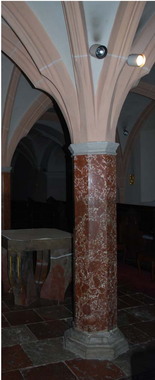
Abb. Nr. 84: Krypta, Hauptraum, barock umgestalteter Freipfeiler
