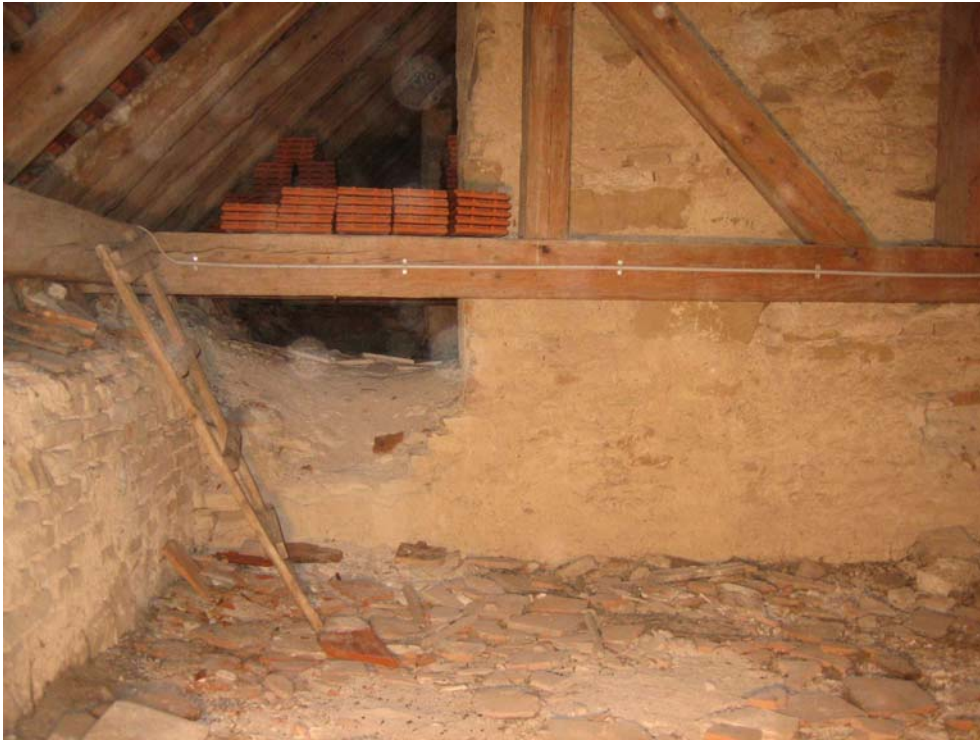
Abb. Nr. 117: Südseitenschiff, Dachboden, Einblick nach Westen, Achse 5
