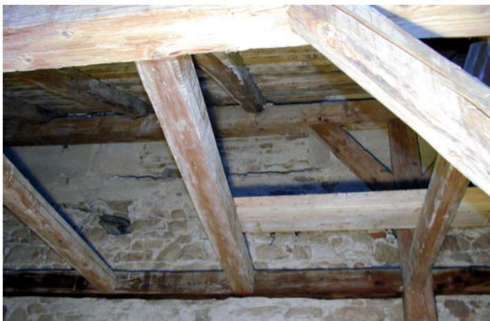
Abb. Nr. 187: Wintersakristei Dachraum, ehem. Dachansatz und vermaueretes Fenster
