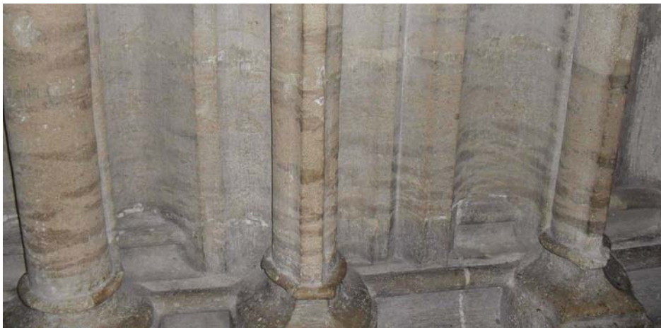
Abb. Nr.301: Wien, St. Stephan, Nordturm – Anschlussbereich Langhaus
