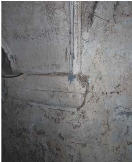
Abb. Nr. 321: Zwettl Stift, Konventshof, Ostflügel Erdgeschoß/Keller Gewölbekonsolle
