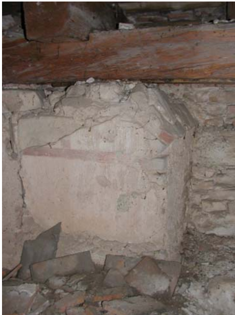
Abb. Nr. 111: Mittelschiffdachboden, Baukörper, Detail – Kämpfer und Reste der Quadermalerei
