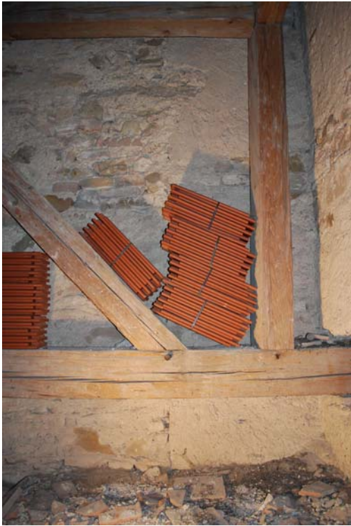
Abb. Nr. 130: Südseitenschiff, Dachboden, Strebepfeiler Achse 6
