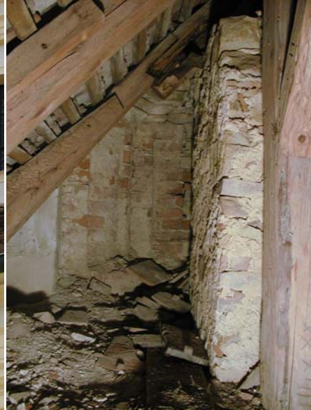
Abb. Nr. 136: Südseitenschiff, Anschluss der spätbarocken Westfassade an das Langhaus
