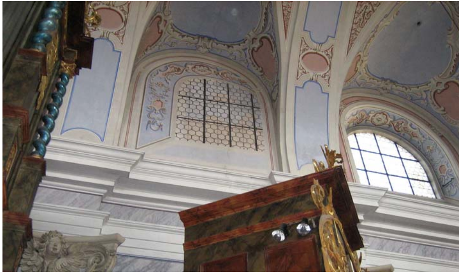
Abb. Nr. 52: Empore, Nordwand, Scheinfenster
