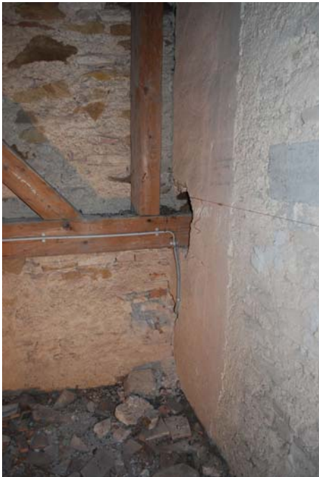
Abb. Nr. 127: Südseitenschiff, Dachboden, Strebepfeiler Achse 5, Detail Ostseite
