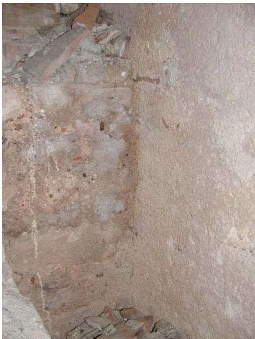
Abb. Nr. 109: Mittelschiffdachboden, Anschluss Seitenschiffwand an der Chorgiebelwand
