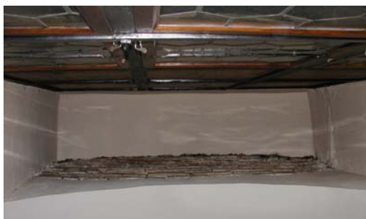
Abb. Nr. 50-51: Langhaus, Seitenkapellen, Nordseite, sekundäre Vermauerung der Seitenschiffenster
