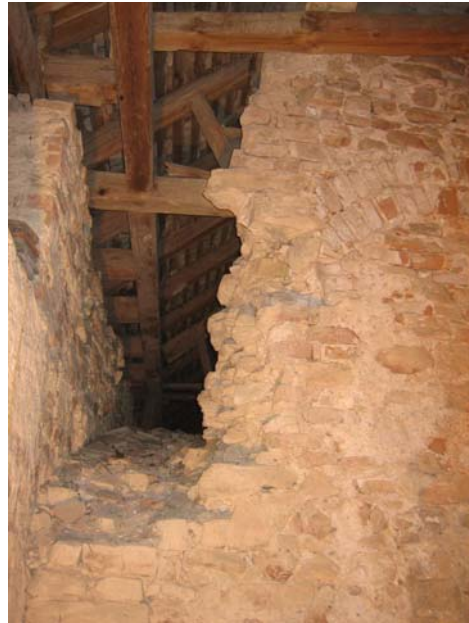
Abb. Nr. 158: Dachraum Kreuzgang/Nordseitenschiff, Bereich II., Wand Achse 5 - westseitig
