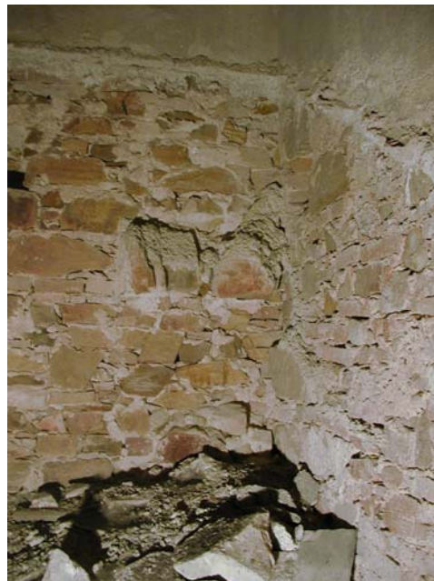
Abb. Nr. 173: Dachraum Nordseitenschiff, Achse 2, Hochschiffwand – ehem. Ansatz
