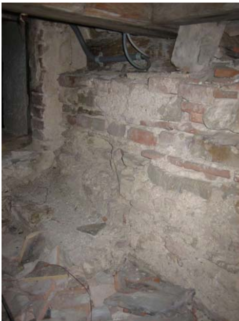
Abb. Nr. 118: Südseitenschiff, Dachboden, südliche Außenmauer
