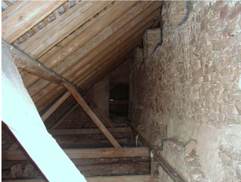
Abb. Nr. 161: Dachraum Kreuzgang, Bereich III., Seitenschiffwand
