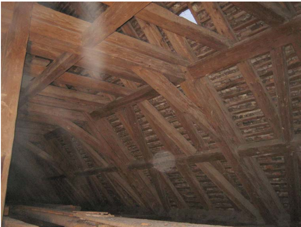
Abb. Nr. 105: Chordachwerk (liegender Stuhl), Südseite
