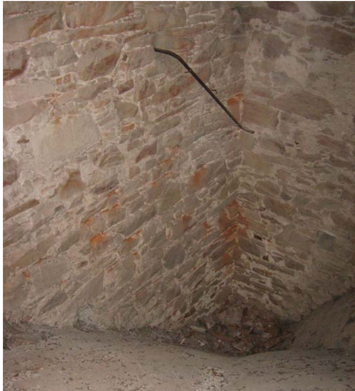
Abb. Nr. 99: Chordachboden, Nordwestecke, Mauerwerk
