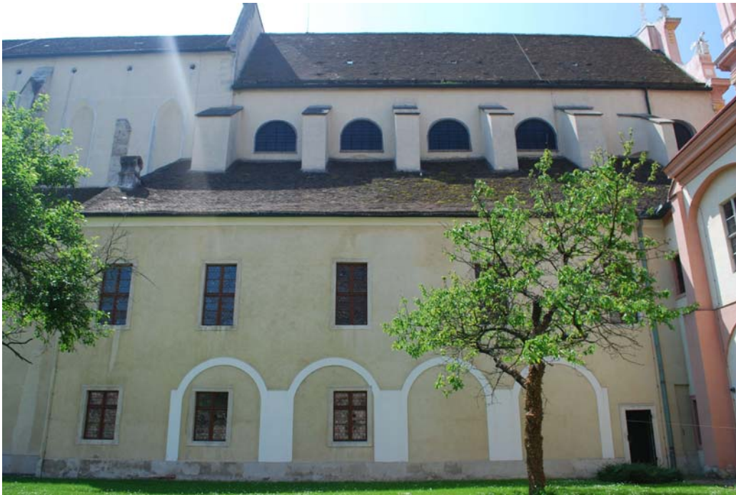
Abb. Nr. 15: Stiftskirche, Ansicht Langhaus Nordseite vom Priorgarten
