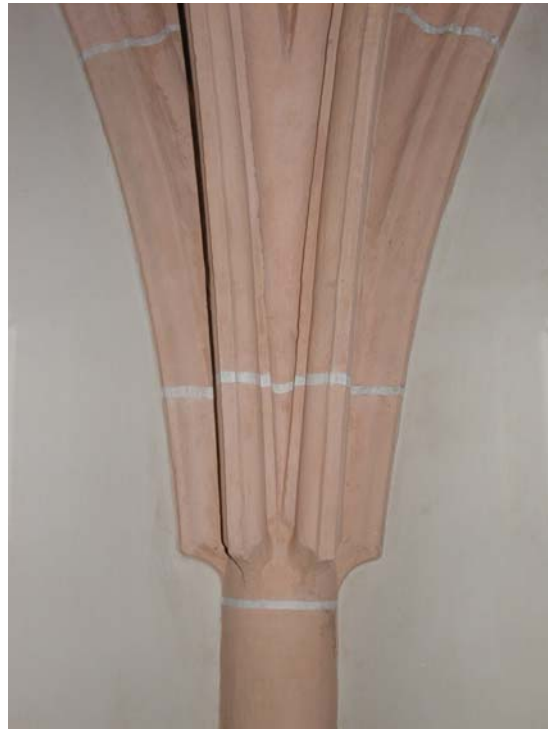
Abb. Nr. 82: Krypta, Hauptraum, Gewölbeanlauf
