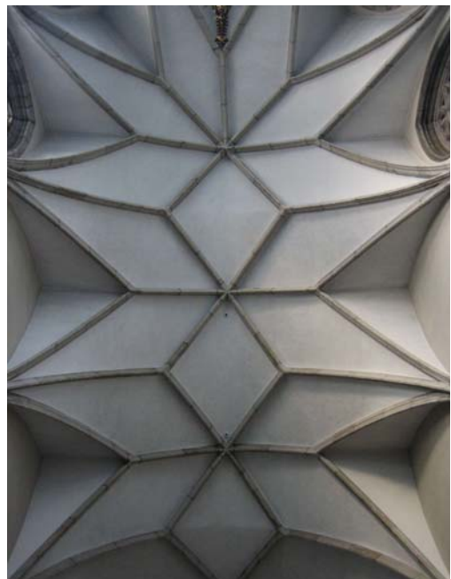
Abb. Nr. 298: Amstetten, Pfarrkirche, Chorgewölbe
