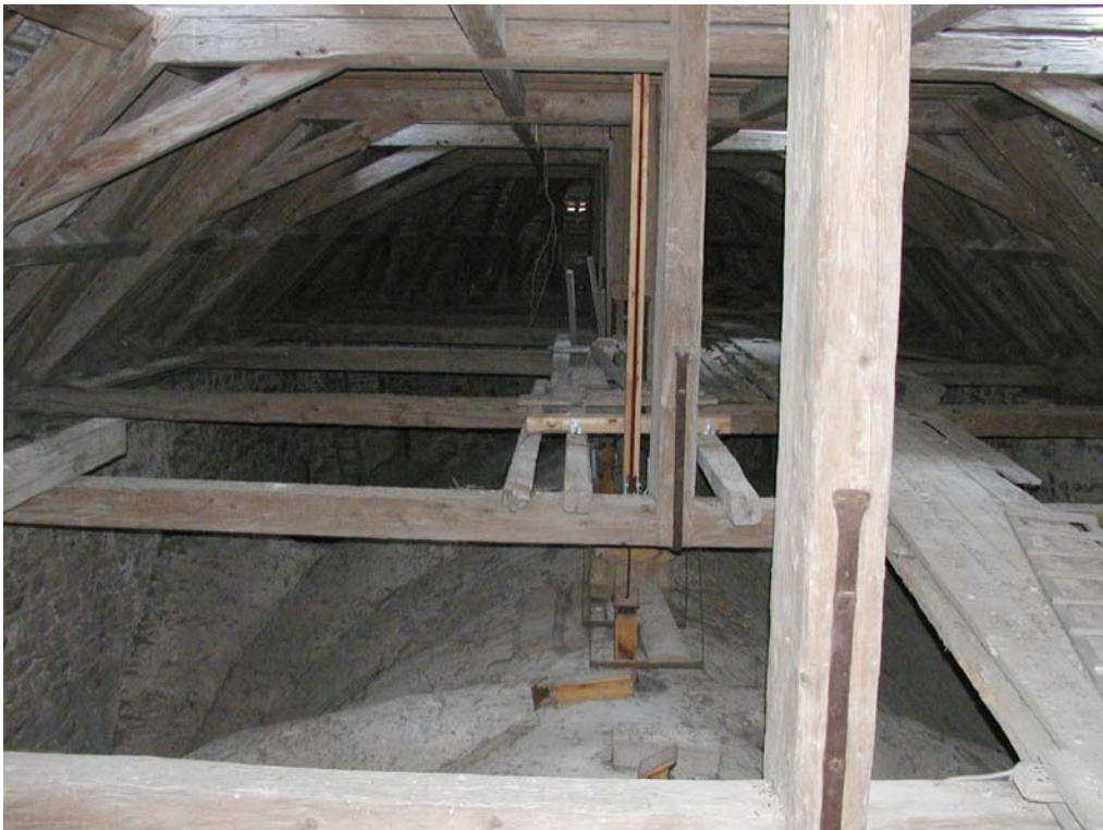
Abb. Nr. 98: Dachraum über dem Chor, Einblick nach Osten
