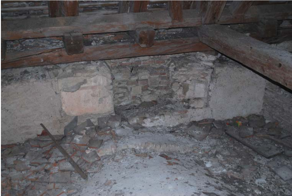
Abb. Nr. 110: Mittelschiffdachboden, nördliche Hochschiffwand, Baufugen/Baukörper
