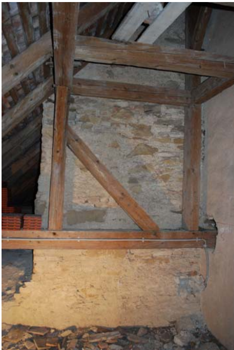
Abb. Nr. 125: Südseitenschiff, Dachboden, Strebepeiler Achse 5
