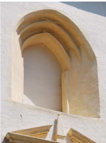
Abb. Nr. 31: Sommerakristei, abgemauertes spätgotisches Fenster
