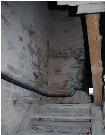
Abb. Nr. 152: Dachraum Kreuzgang/Nordseitenschiff, Bereich II., Westwand ostseitig
