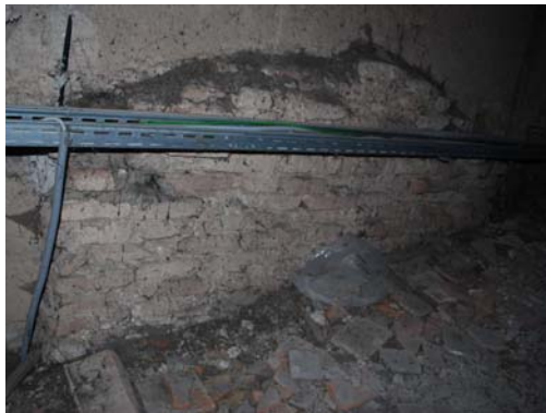
Abb. Nr. 162: Dachraum Kreuzgang, Bereich III., Seitenschiffwand – Vermauerung Seitenschifffenster
