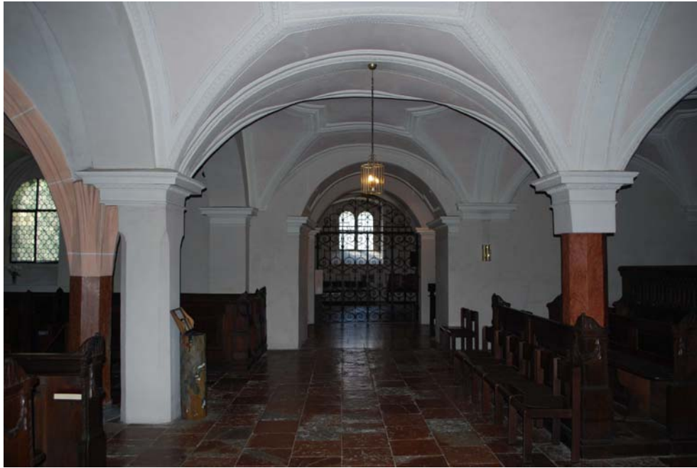
Abb. Nr. 85: Krypta, Hauptraum, barockisierter Westbereich, Einblick nach Süden zur Altmannikrypta
