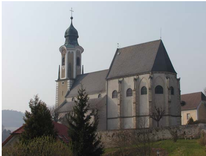
Abb. Nr. 315: Emmersdorf an der Donau, Pfarrkirche, Ansicht von Südosten
