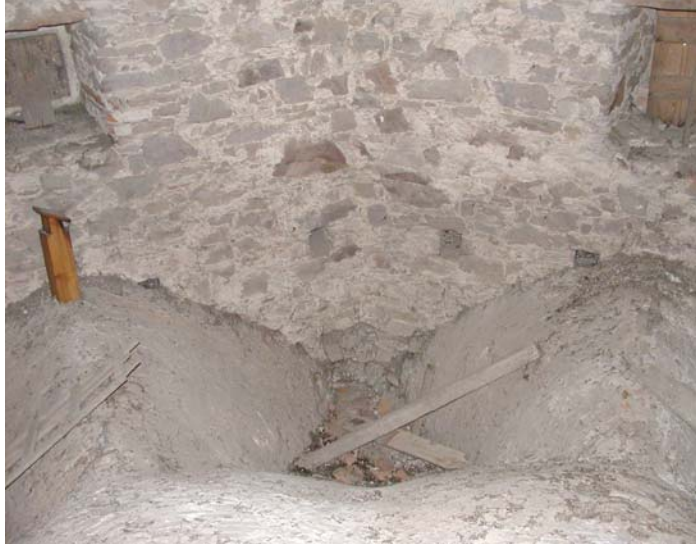
Abb. Nr. 103: Chordachboden, Gewölbeschale, Polygonbereich
