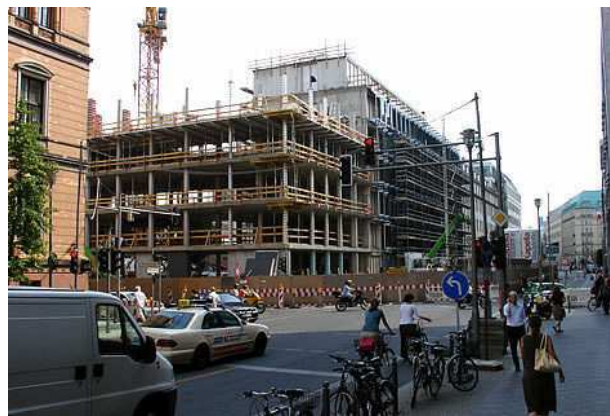
Abb. 14: Dorotheenstraße 97/ Wilhelmstraße 65 – 67, Berlin, 1974 – 1976 / Lieb + Lieb Architekten, Stand der Umbauarbeiten am 21. Juli 2010.
