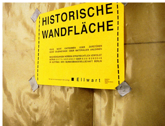
Abb. 51: Schutzmaßnahme für eine historische Wandfläche im Zuge der Entkernung des Reichstagsgebäude, 1995.
