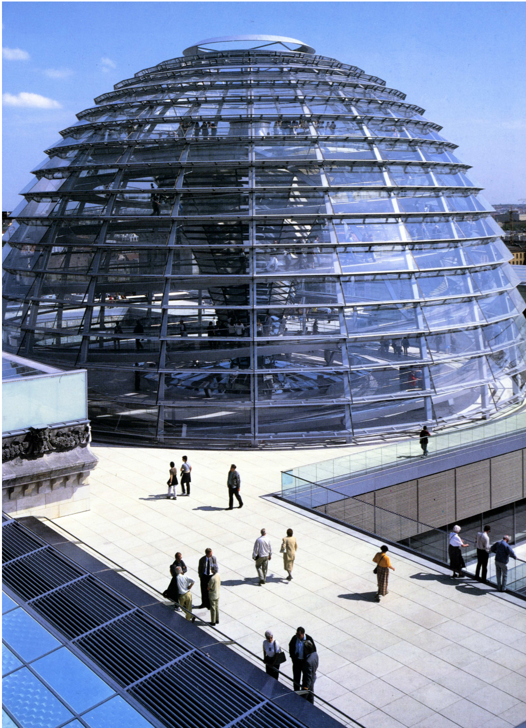
Abb.: 80: Reichstagsgebäude, Berlin, Glaskuppel und Dachterrasse, Norman Foster 1995 – 1999.
