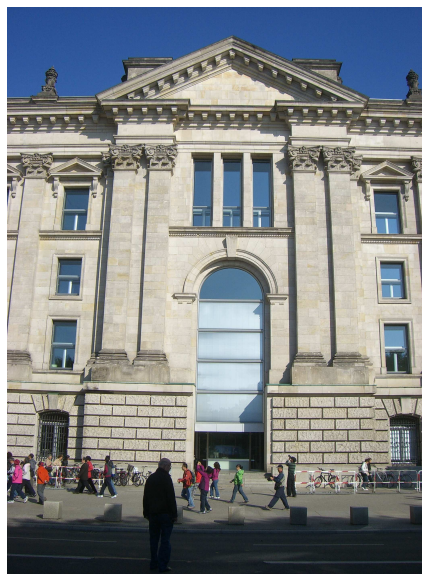
Abb. 42: Reichstagsgebäude, Berlin, Seitenportal der nördlichen Fassade, Paul Wallot 1884 – 1894 / Norman Foster 1995 – 1999.
