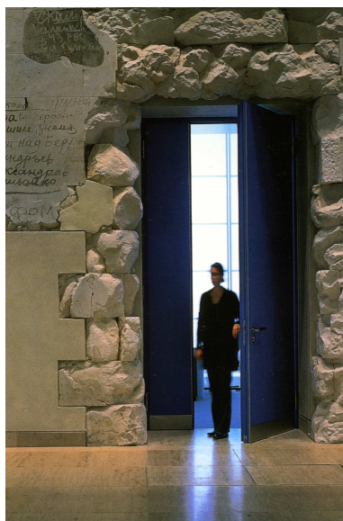
Abb. 54: Reichstagsgebäude, Berlin, wieder geöffneter Türdurchgang, Norman Foster 1995 – 1999.
