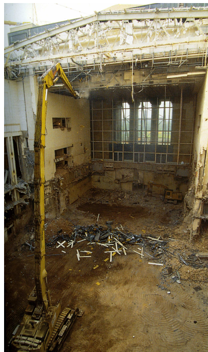
Abb. 50: Entkernung des Reichstagsgebäudes, 1995.
