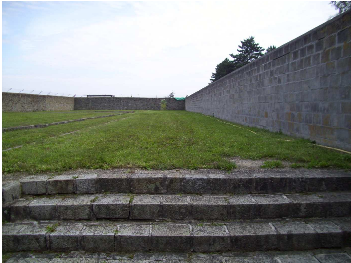
Abbildung 5. Das Areal des Blocks 20, Blick Richtung Osten, September 2010. Die Umfassungsmauern haben sich erhalten, links ist noch das Fundament der Baracke zu erkennen, die 1967 abgetragen wurde. Foto Matthias Kaltenbrunner. (Privatbesitz Matthias Kaltenbrunner).
