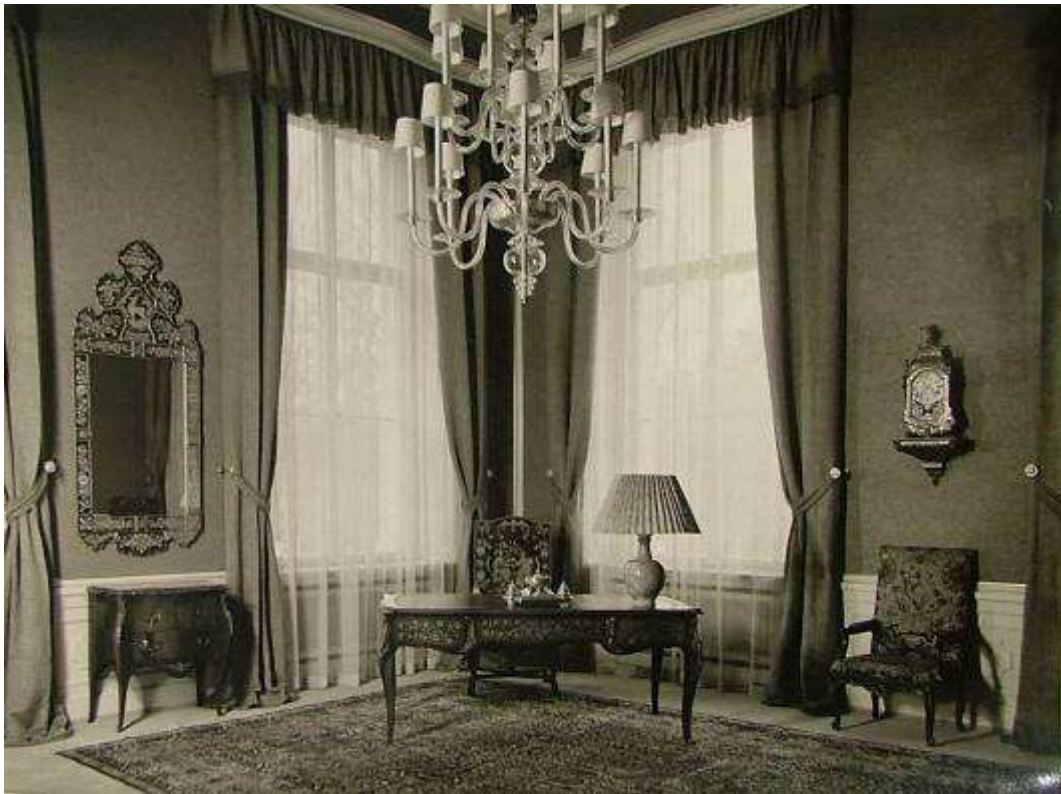
Abb. 55: Innenausstattung, Schloss Kleßheim, Salzburg, nach der zweiten Umbauphase zu einem Gästehaus des Führers, 1943 (HSS, INR 004.564).
