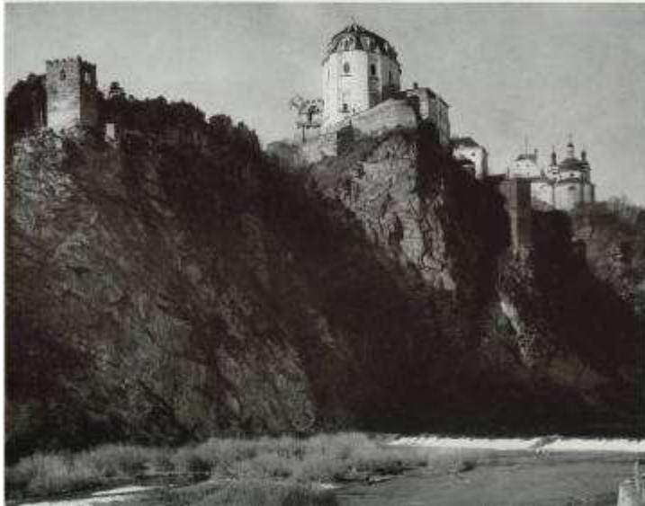
Abb. 289: Johann Bernhard Fischer von Erlach, Im Vordergrund der Ahnensaal, Schloss Frain, 1688/89 (Sedlmayr, 1956, Abb. 22).
