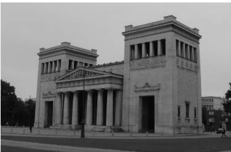
Abb. 208: Platzfassade, Propyläen, Königsplatz, München (Foto Ingrid Holzschuh, 2009).
