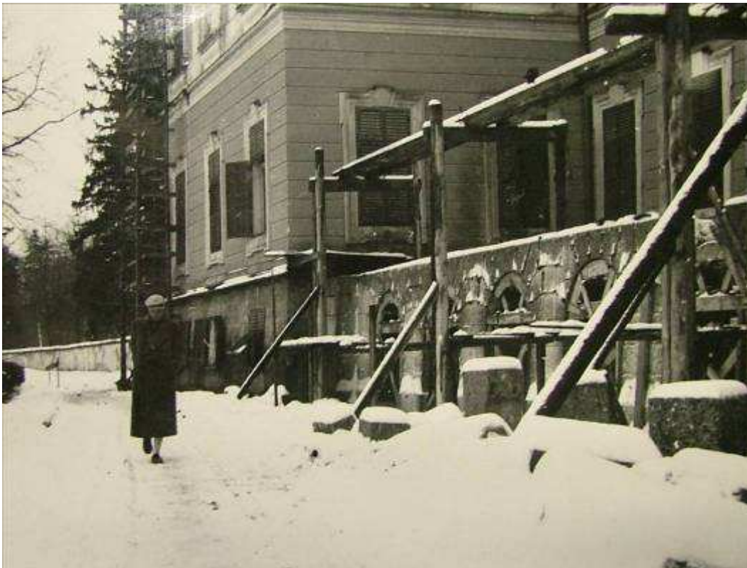
Abb. 46: Otto Strohmayer vor der Baustelle, Gartenseite Schloss Kleßheim, Salzburg (HSS, INR 004.564).
