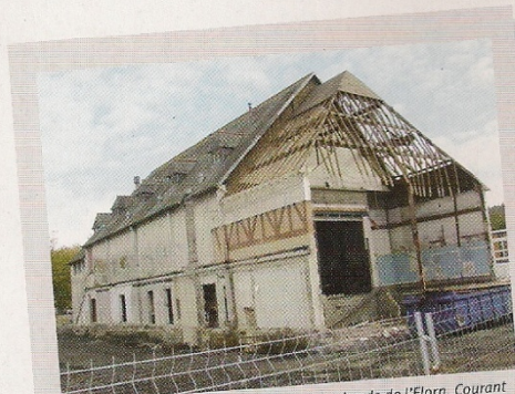
Le chantier du Family se poursuit sur les bords de l'Elorn. Courant octobre, les travaux sur l'arrière de la bâtisse (dépose des ardoises, enlèvement de la voûte, puis d'une partie de la charpente métallique, abattage du mur) se sont déroulés dans les délais. Rappelons que le bâtiment originel sera conservé mais subira un agrandissement permettant la jonction avec la médiathèque.
