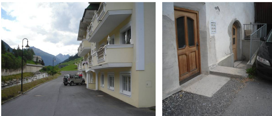
Abbildung 7.4: Tief positionierte Fenster in Ischgl (links) bzw. Türen in Pfunds (rechts). (Fotos: Ornetsmüller, Juli 2011)
