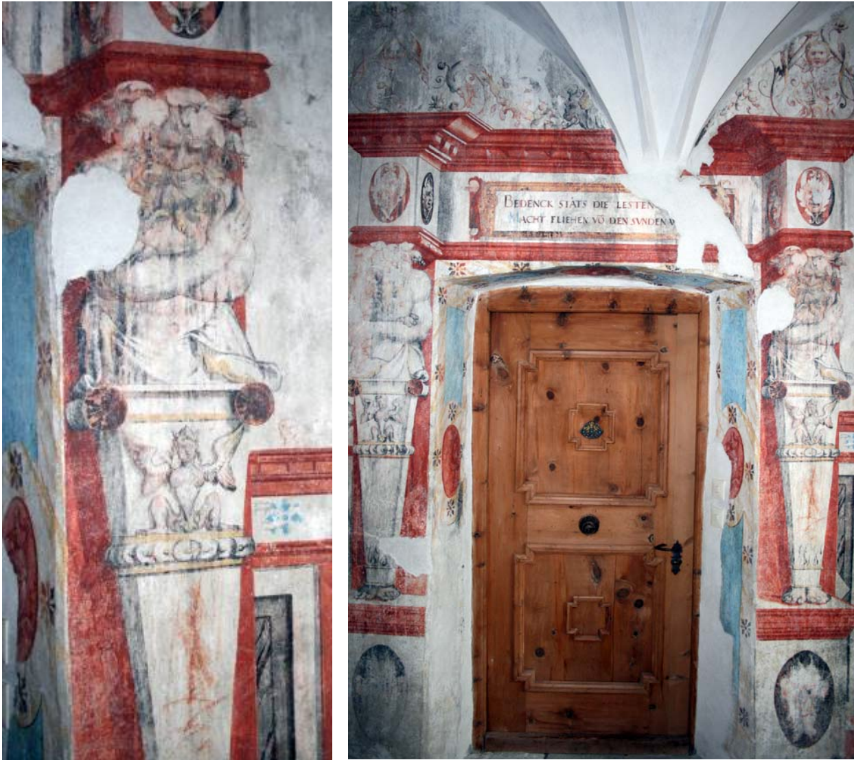
Abb. 116 und 117: Detail Fresken, Tür zum Wohnzimmer, Eingangsbereich.
