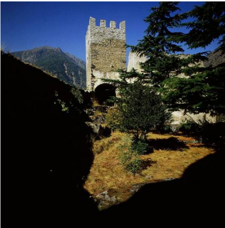
Abb. 248: Oberer Schlosshof mit Blick auf den Bergfried vor der Restaurierung, 1983-84.
