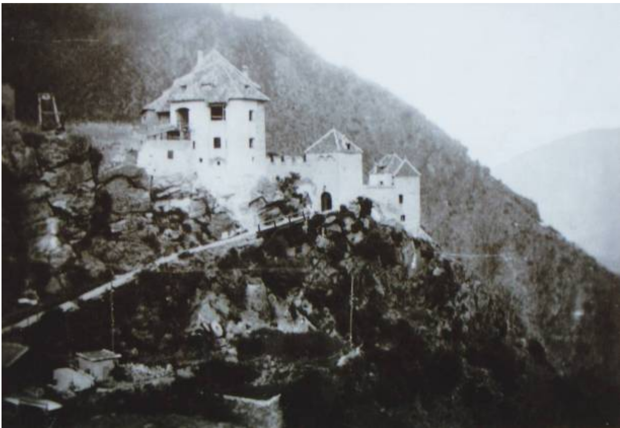
Abb. 211: Schloss Juval während der Sanierung.
