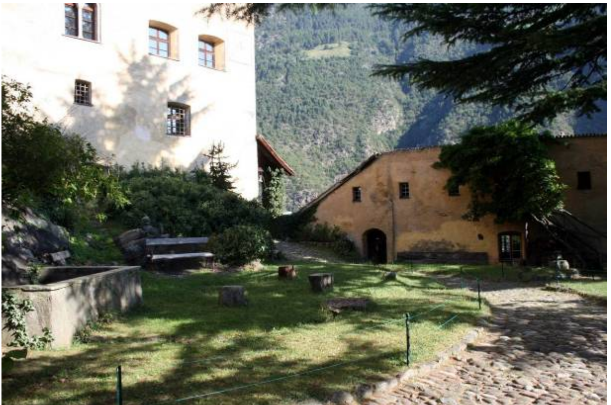
Abb. 20: Unterer Innenhof mit Blick auf Palas (links) und Gesindehaus (rechts).
