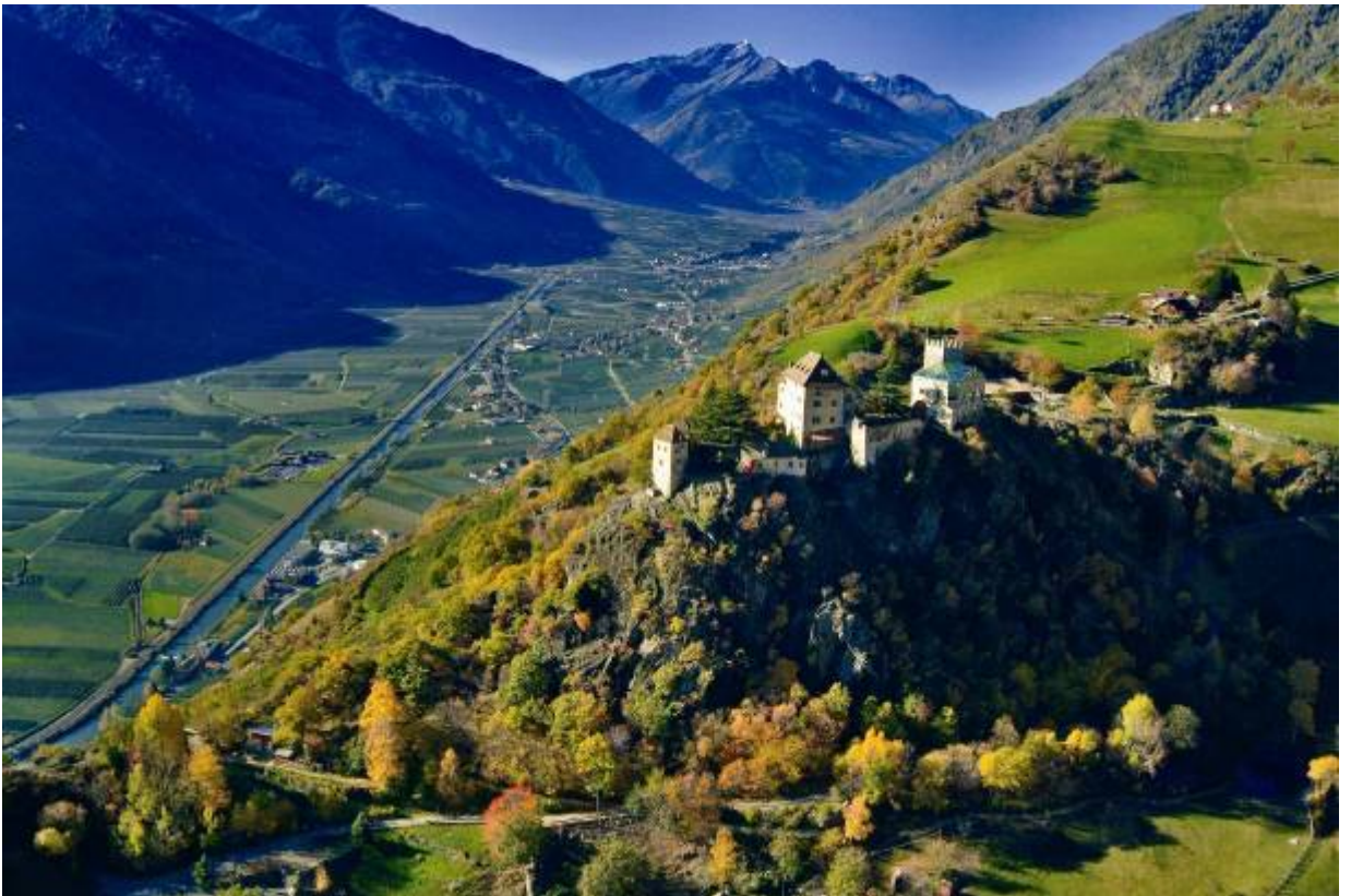
Abb. 320 und 321: Schloss Juval von Norden nach der Fertigstellung des Glasdachs.
