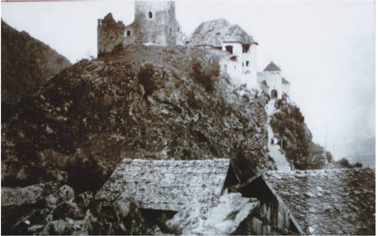
Abb. 212: Schloss Juval während der Sanierung, links im Vordergrund das Baumannhäuschen und rechts der Stadel des Unteren Schlossbauerns.
