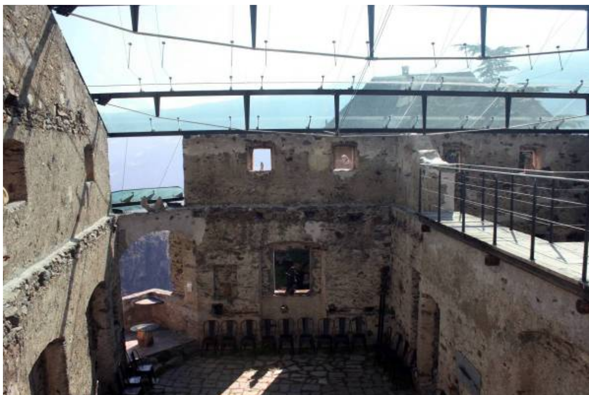
Abb. 318 und 319: Nordtrakt mit fertig gestelltem Glasdach.
