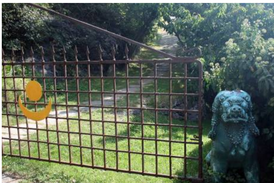
Abb. 16: Eingangsgitter des Zugangswegs Schloss Juvals.
