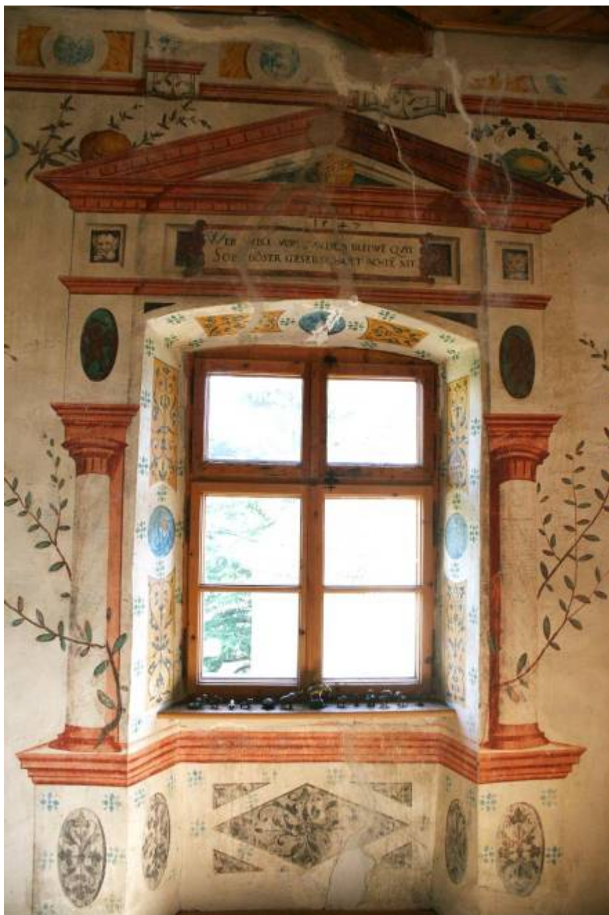
Abb. 124: Fresken Fensterzone, Speisezimmer.
