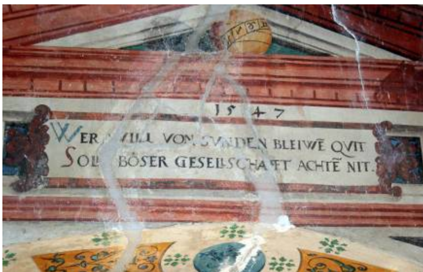
Abb. 125: Detail Fresken, Fensterzone, Speisezimmer.
