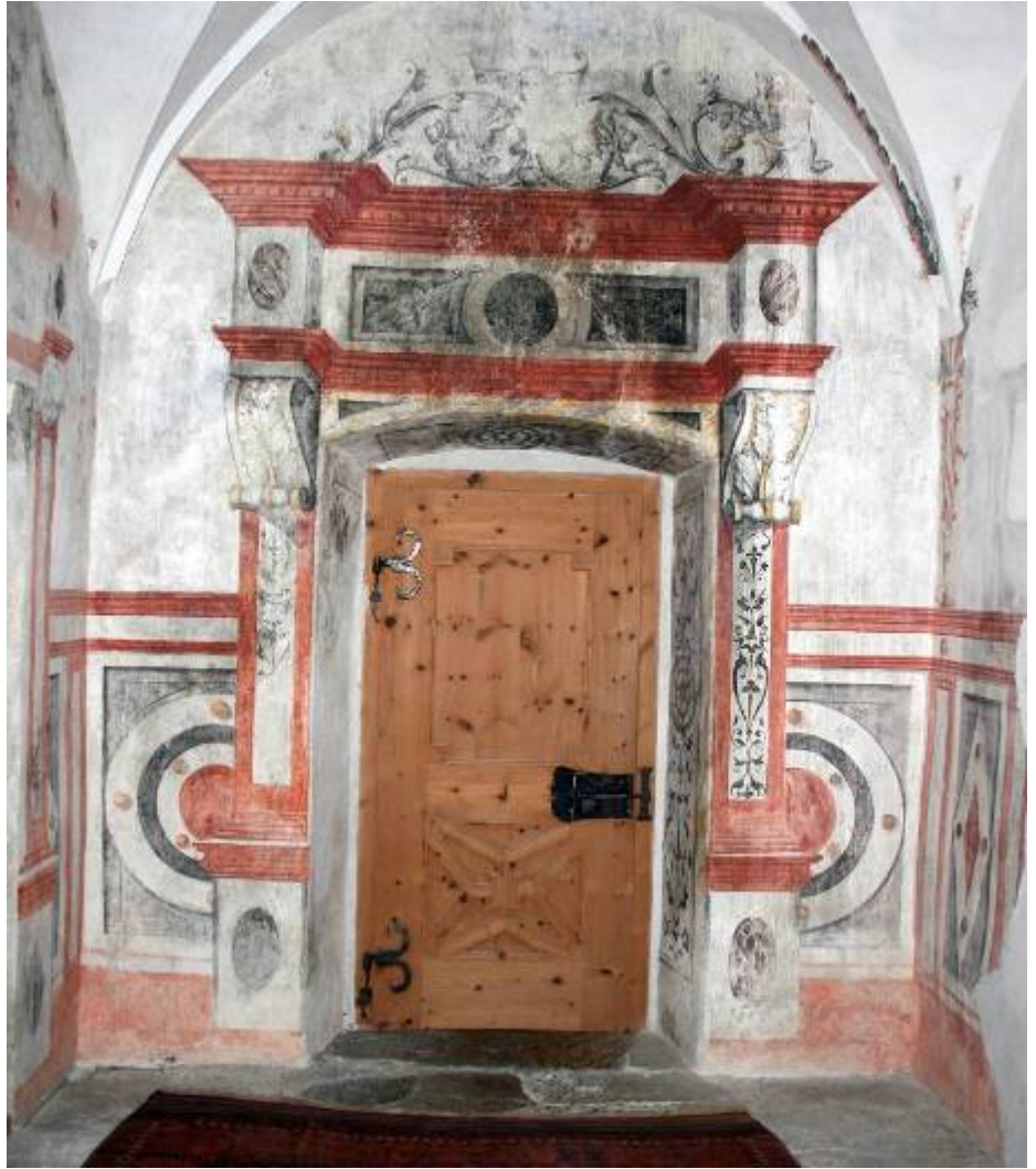
Abb. 114: Fresken Eingangstür, Eingangsbereich.
