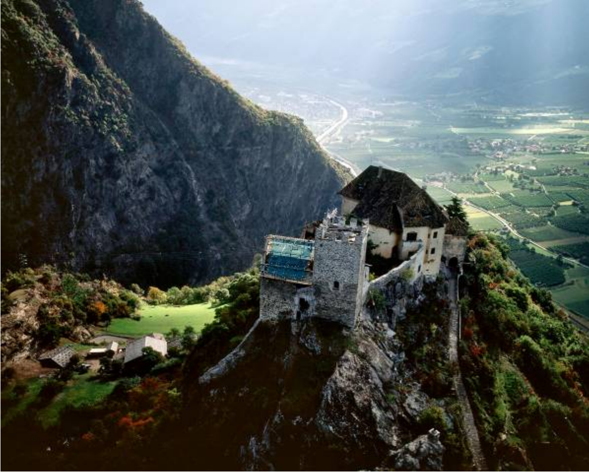
Abb. 310: Schloss Juval von Westen während der Errichtung des Glasdachs, 1996.
