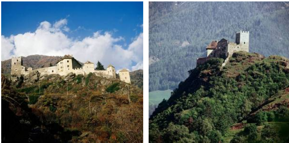
Abb. 295 und 296: Schloss Juval von Süden und Nordwesten nach der Restaurierung.
