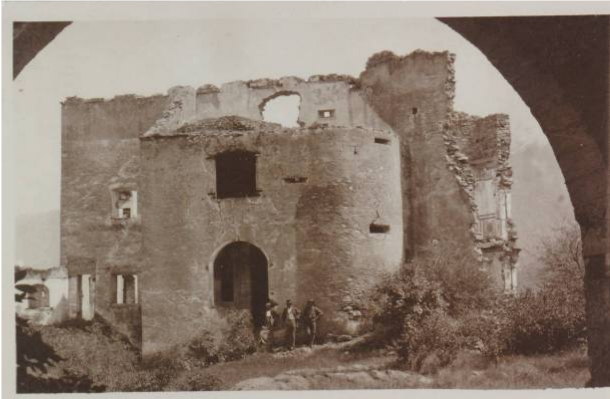
Abb. 210: Architekt Wietek, Seilbahnspezialist Weger und Bauherr Rowland im oberen Burghof vor dem Palas (Treppenhaus) vor der Restaurierung.
