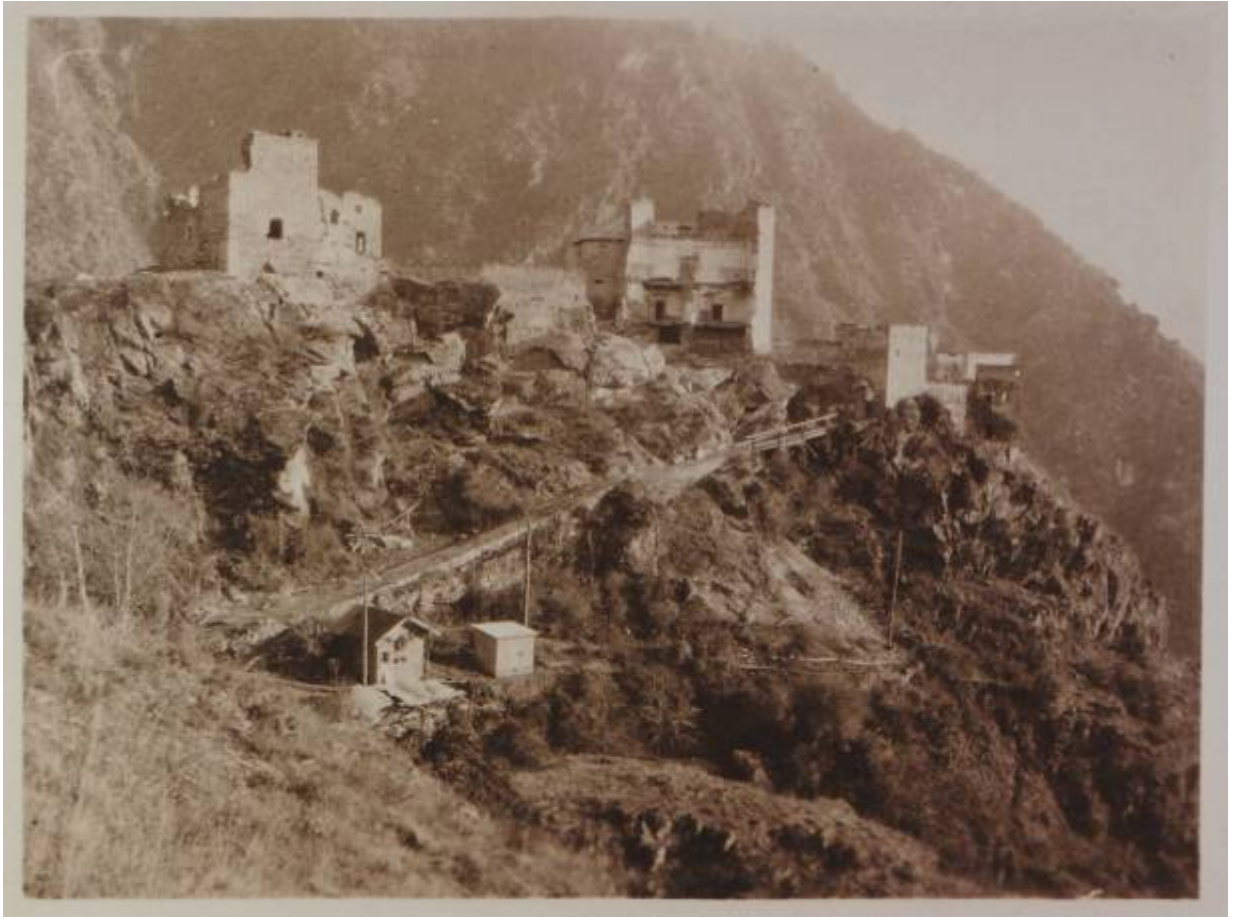
Abb. 203: Postkarte, Ruine Juval von Süden vor der Restaurierung, im Vordergrund die Bergstation der Materialseilbahn.
