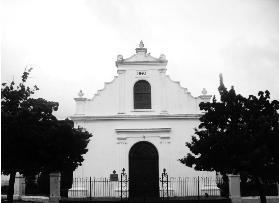
Abbildung 9: Rhenish Church Stellenbosch (Foto der Verfasserin, 2010)
