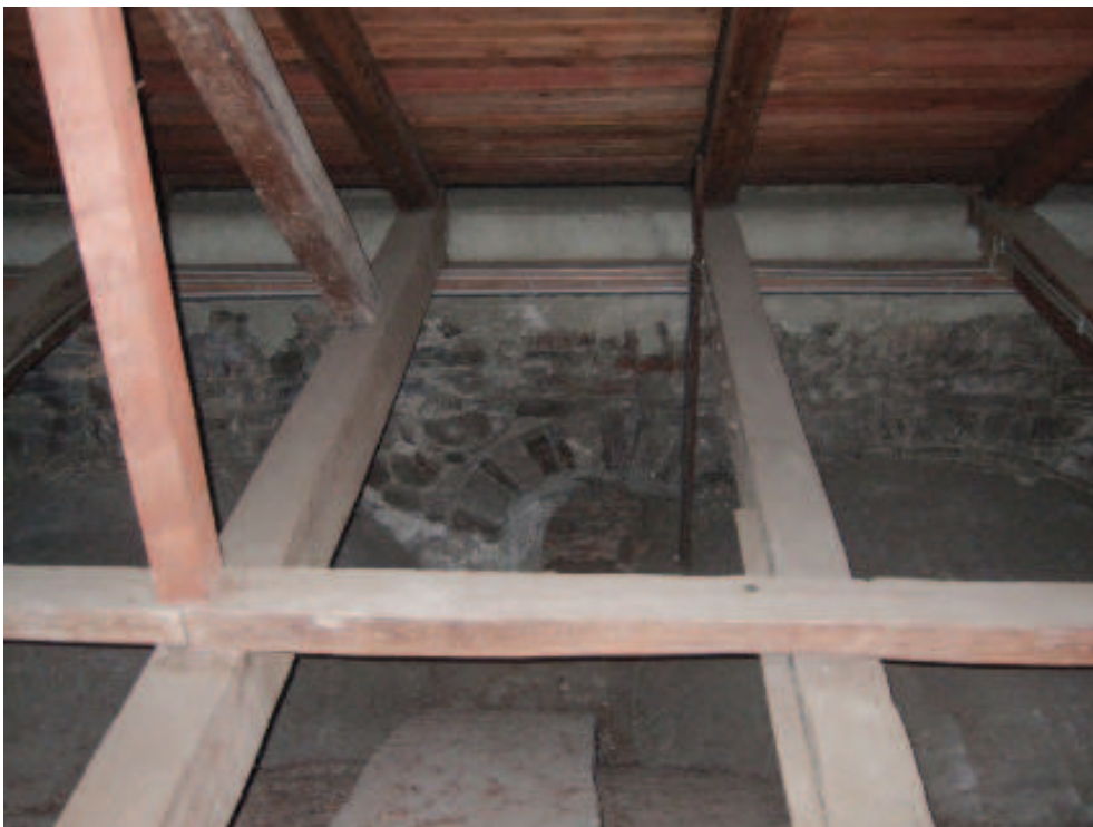
Abb. 36.: Kreuzkirche, Langhaus, nördliches Sargwand des Mittelschiffs, zweitwestlichstes Joch.
