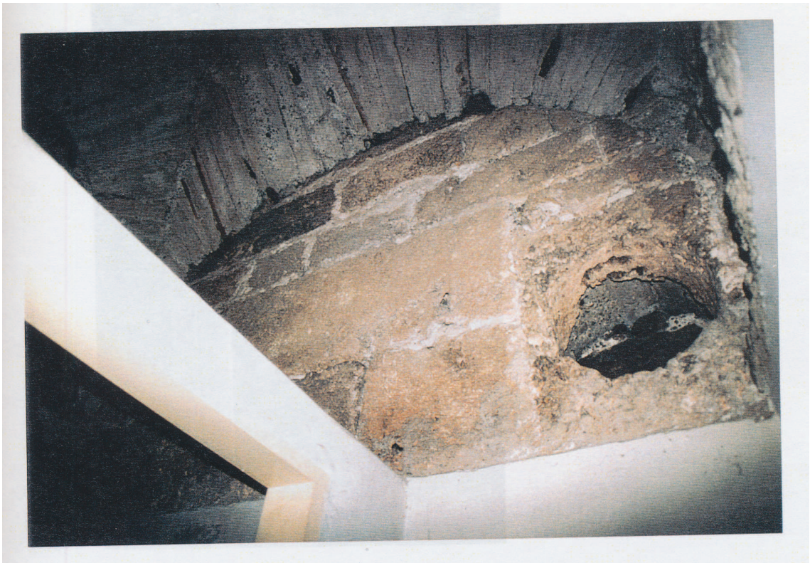
Abb. 67.: Marienkirche, Nordturm Untergeschoss, Ostwand Tuffquader.
