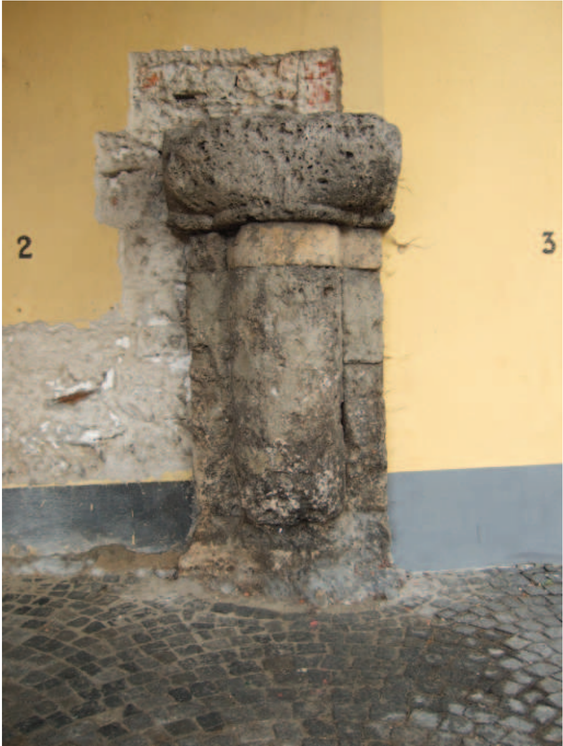
Abb. 74.: Marienkirche, Langhaus, nördlicher Westwandpfeiler aus Tuff.
