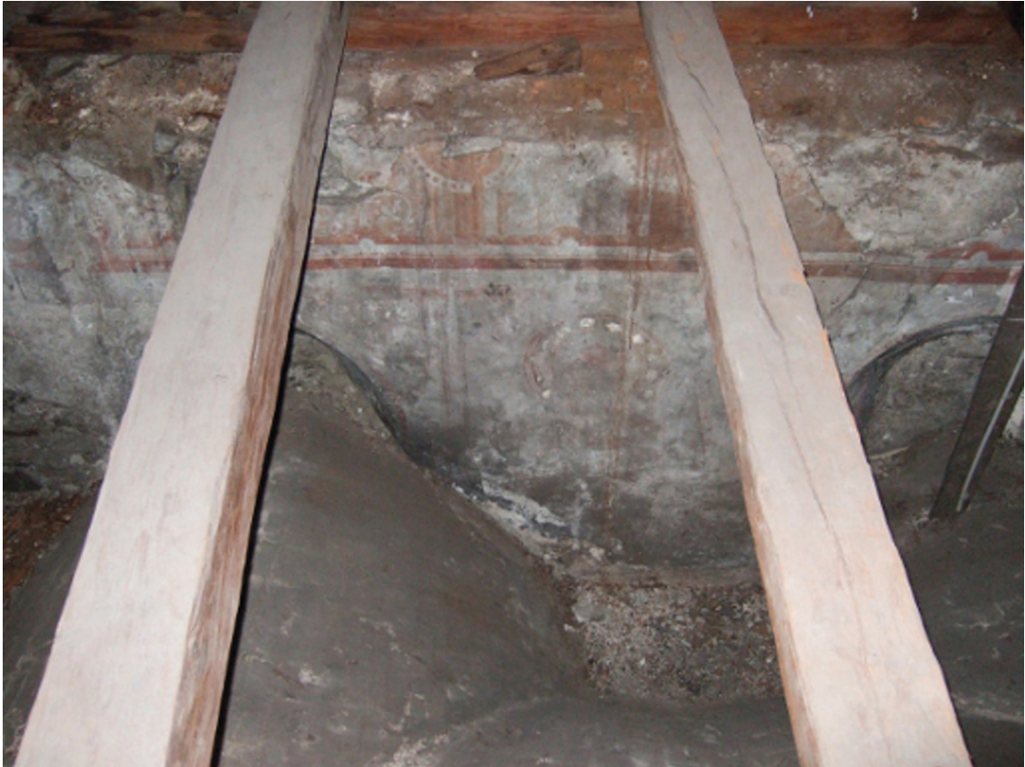
Abb. 14.: Kreuzkirche, Chor, Nordwand, freiliegende Rundbogenfenster mit Resten von Freskierung.
