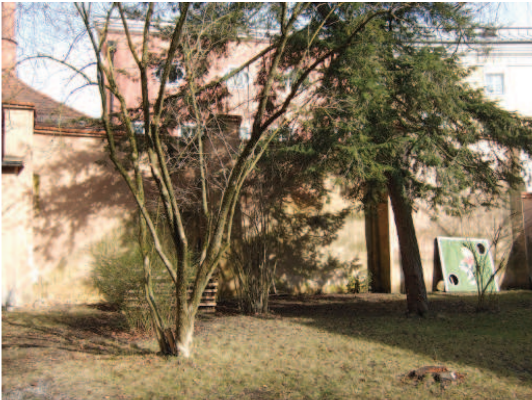
Abb. 90.: Heinrichskirche, Ostteil der Nordwand.
