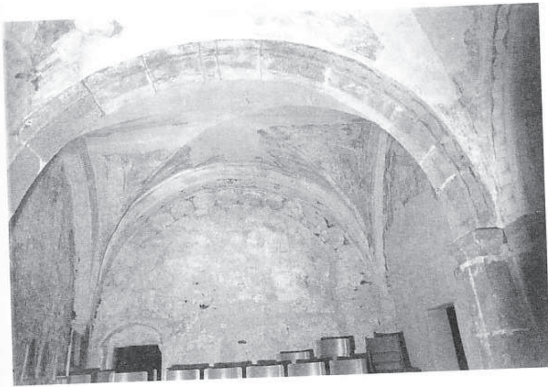
Abb. 63.: Marienkirche, Einblick in die Vorhalle, Blickrichtung Süden.
