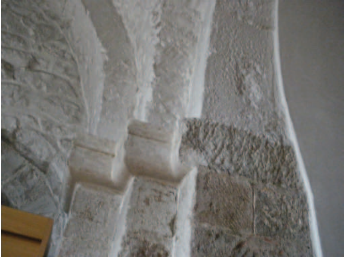
Abb. 53.: Kreuzkirche, Westempore, Detail: Kämpfergesims des nördlichen Wandpfeilers
