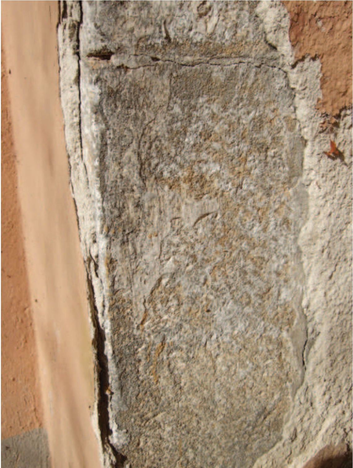
Abb. 91.: Heinrichskapelle, Granitquader der zweitwestlichsten Vorlage der Nordwand.
