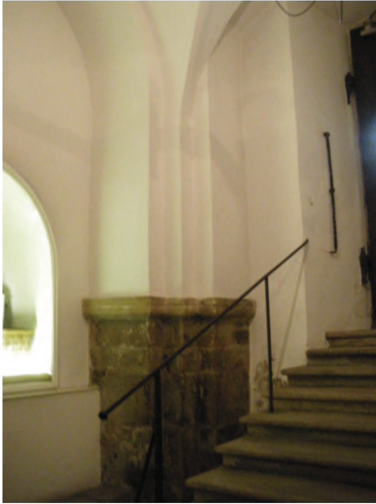
Abb. 41.: Kreuzkirche, Vorhalle, südwestlicher Wandpfeiler.
