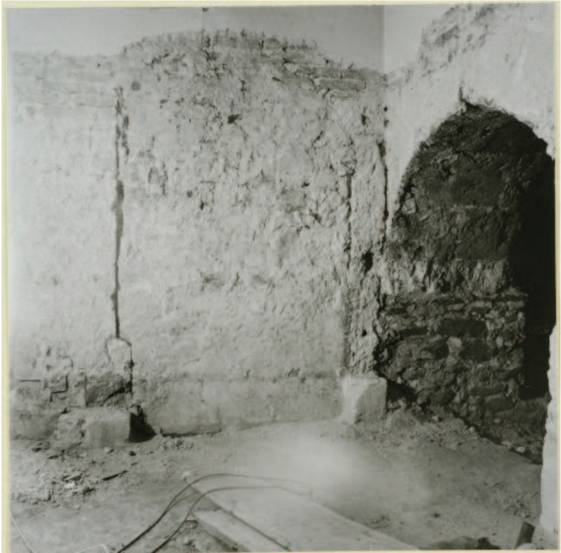
Abb. 75.: Marienkirche, Westempore, Ostwand. Foto vor 1968.
