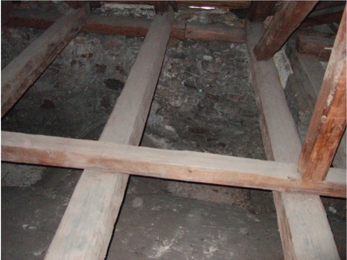
Abb. 16.: Kreuzkirche, Chor, Südwand, westlichstes Joch unter Dach.
