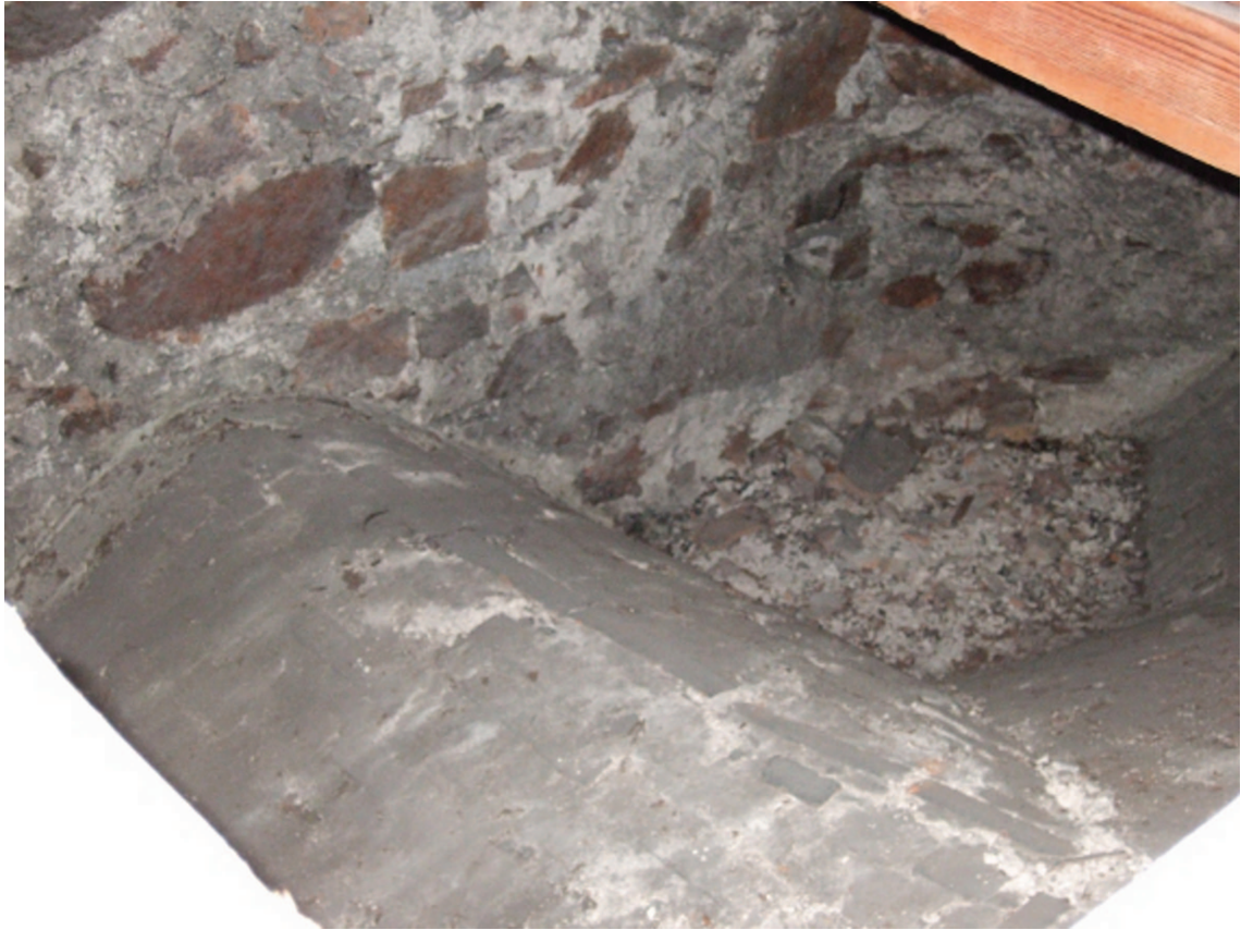
Abb. 21.: Kreuzkirche, Chor, Nordseite Chorpolygon unter Dach
