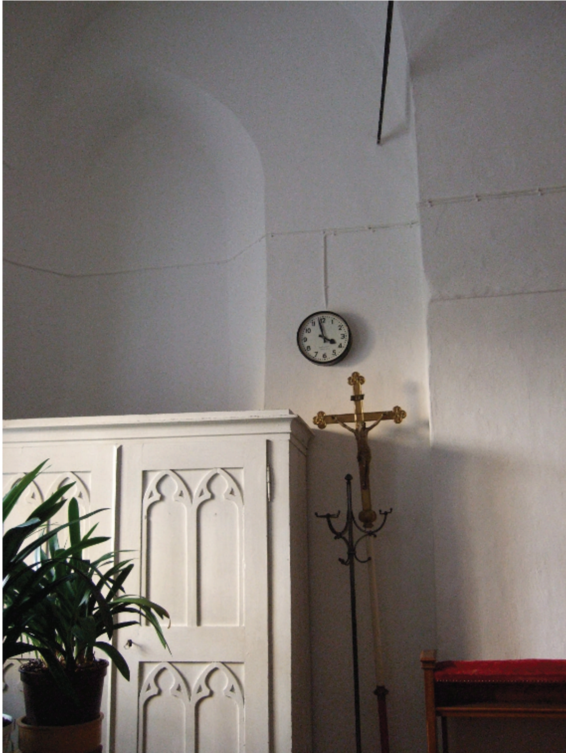
Abb. 17.: Sakristei der Kreuzkirche nördlich des Chores gelegen, erster Stock, Südwand, Mauerabsatz.
