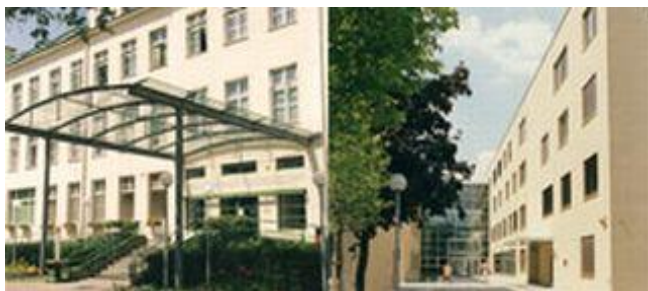
Bild 53: Haupteingang Krankenhaus Floridsdorf und Haupteingang des Geriatriezentrums Floridsdorf (von links nach rechts)
