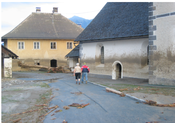
Abbildung 3.7: deutlich zur erkennende Anschlagshöhe an der Kirche (Foto: Ereignisdokumentation BOKU, IAN)
