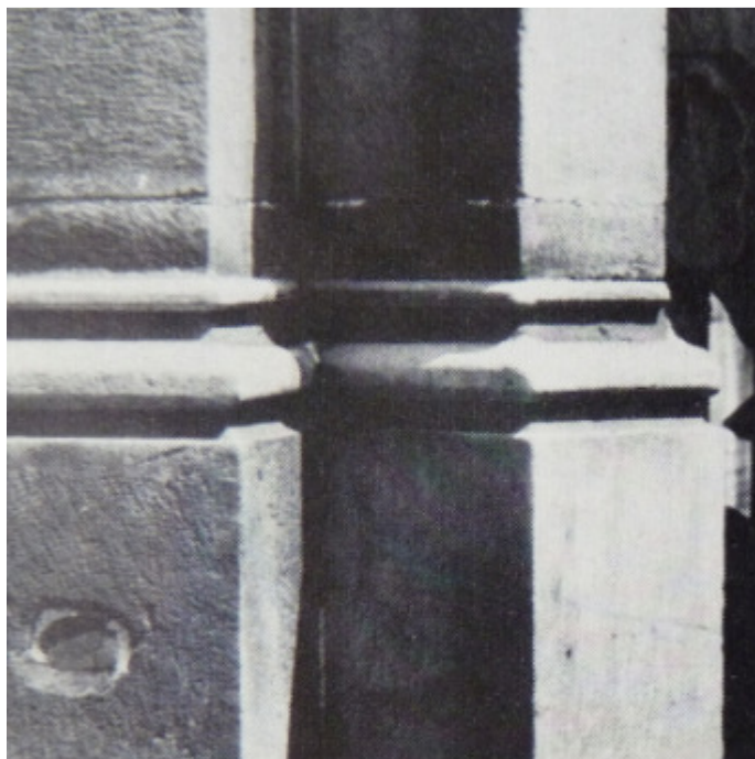
Abb. 52, Strebepfeiler Mailänder Dom, Mailand.
