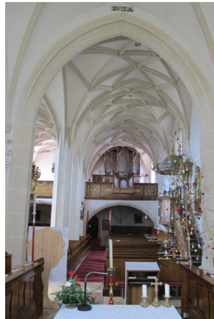
Abb.61, Pfarrkirche Maria Himmelfahrt in Kottes, Langhaus mit Netzrippengewölbe, bez.1515.
