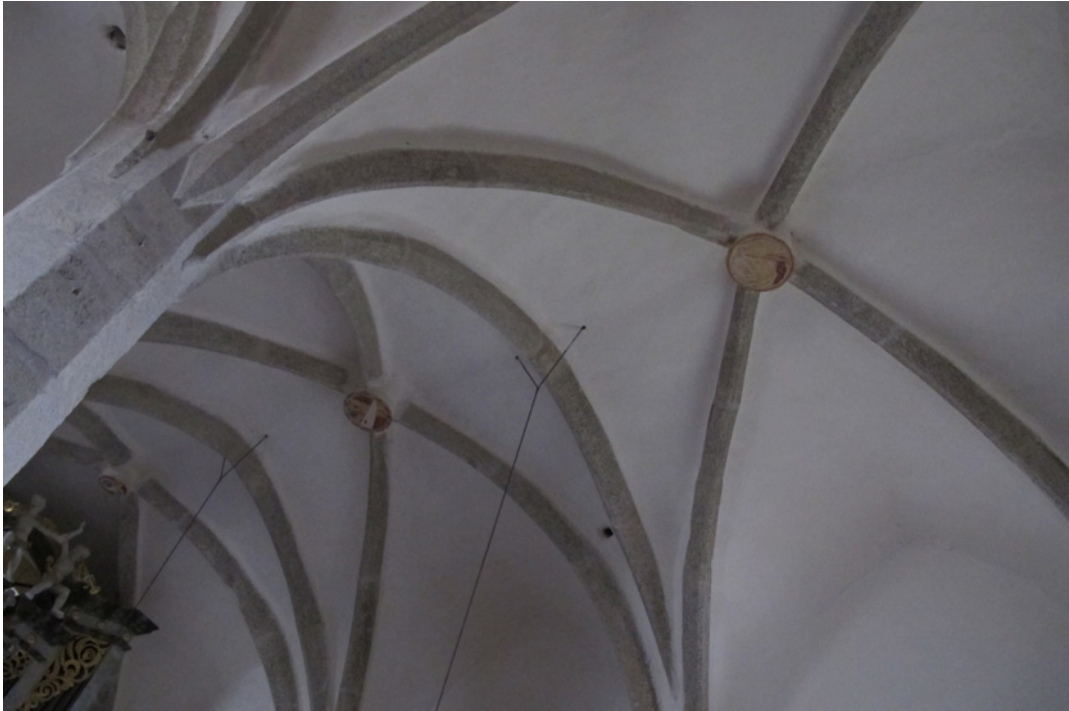
Abb.6, Kleinzwettl, Langhaus, Kreuzgewölbe auf drei achtseitigen Pfeilern, 15. Jhdt.
