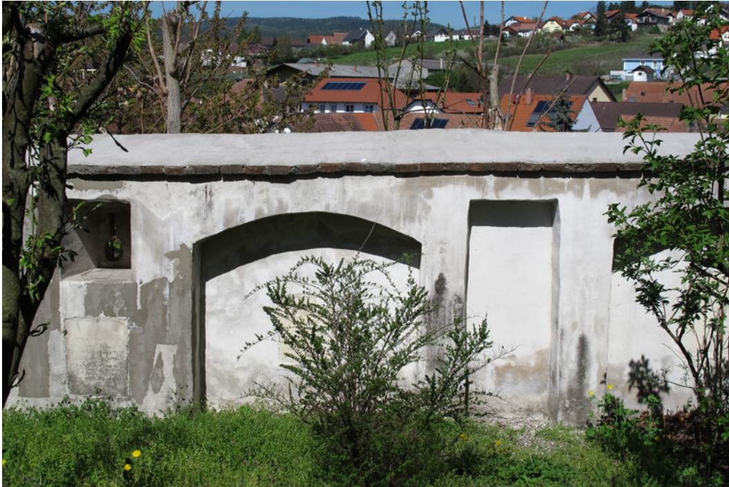
Abb.94, Pfarrkirche Hl. Pankratius in Lengenfeld, innen verputzte Wehrmauer mit Nischen und Schießscharten.
