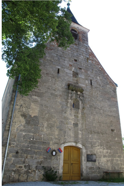
Abb.39 , Propsteikirche Hl. Johannes Ev. in Zwettl, Westfassade, mit vermauertem Hocheinstieg und Kragsteinen, den Resten des früheren Brückengangs, ab 1120.
