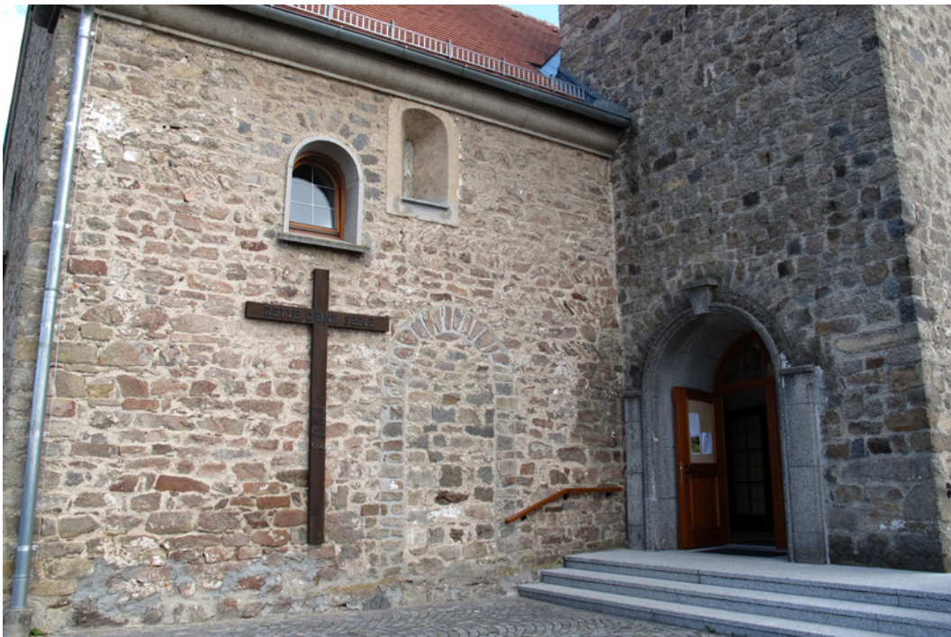
Abb.12, Seyfrieds, Südwand, vermauertes romanisches Rundbogenportal und darüber ein Rundbogenfenster, neben dem Turmportal von 1950.
