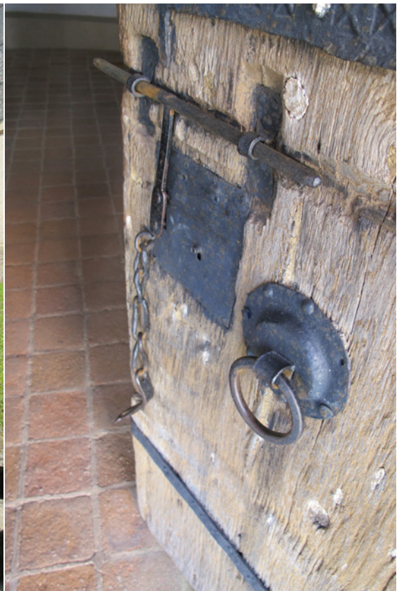
Abb.29 , Friedersbach, Karner, um 1360, Gotischer Eisenbeschlag der Eingangspforte.
