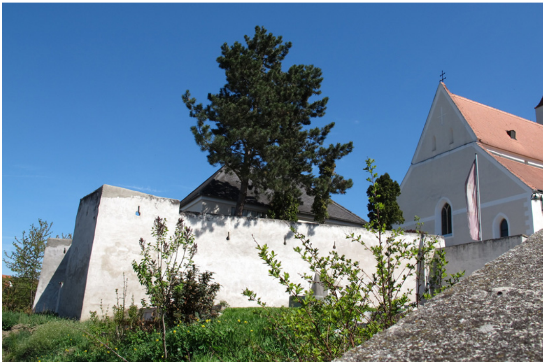
Abb.93, Pfarrkirche Hl. Pankratius in Lengenfeld, Wehrmauer mit innen offenen, vorkragenden Wehrtürmen und Schlüsselscharten.
