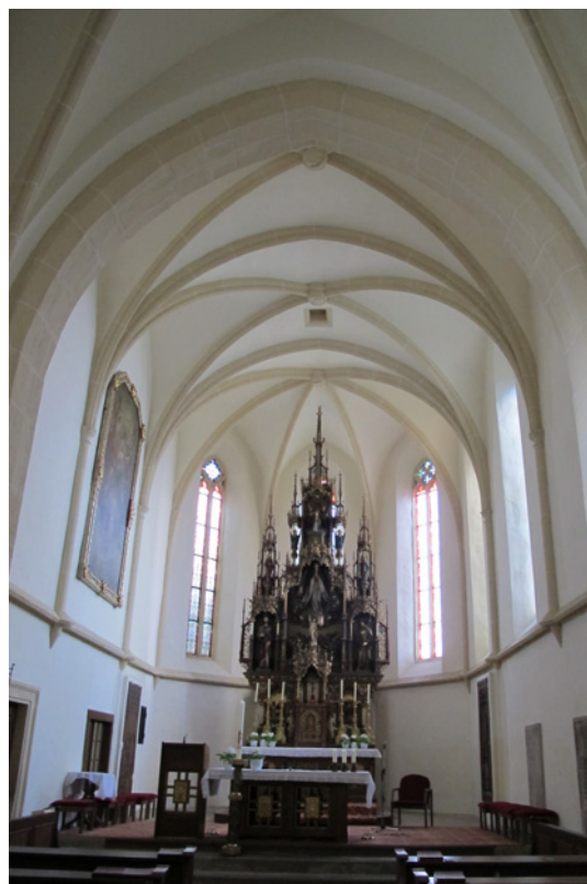
Abb.33, Pfarrkirche Maria Himmelfahrt in Altpölla, Blick in den Chor, Kreuzrippengewölbe auf gekehlten Kapitellen, Kaffgesimse und Hornkonsolen, 1.H.14.Jhdt.
