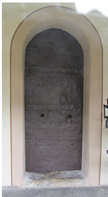
Abb.62, Kottes, Pfarrkirche Maria Himmelfahrt, gotische Tür im Süden, mit dreieckigem Schießloch und zwei kreisrunden Spählöchern.
