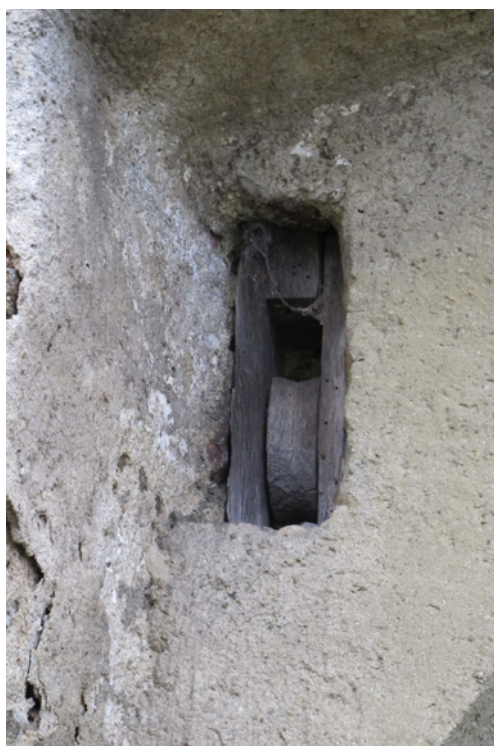
Abb.10, Kleinzwettl, Windenfalze am Kirchhoftor mit den Resten des Holzes der ehemaligen Zugbrücke.
