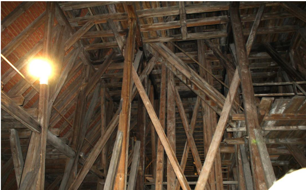
Einblick in den Neuberger Dachstuhl, Treppe zum Glockenturm, 1461-1496
