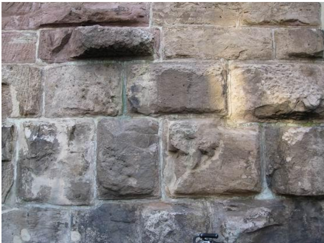
Buckelquadermauerwerk
