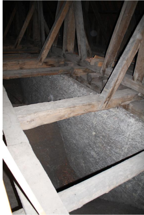
Dachkonstruktion mit Mauerauflagen, darunter Wölbungsansatz
