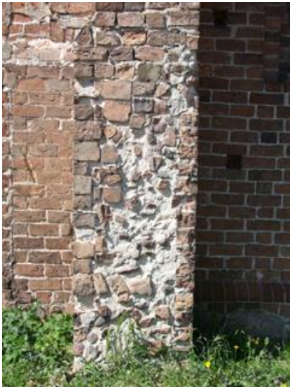
Schalenmauerwerk eines Kirchenbaus, 12. Jh., Backstein, Buckow, Havelland
