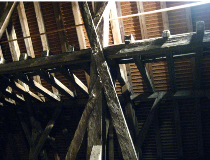
Original mittelalterliche Holzbearbeitungsspuren, Einblick in den Dachstuhl
