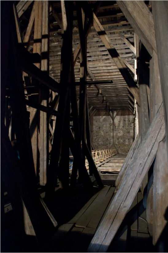
Einblick in den Dachstuhl, Seitenansicht 1461-1596
