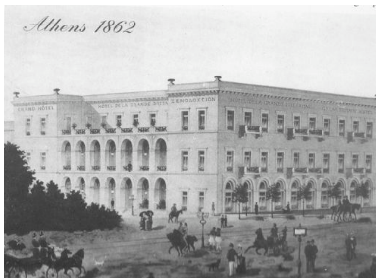
Abb. 15: Ansicht von Haus Dimitrios 1862.
