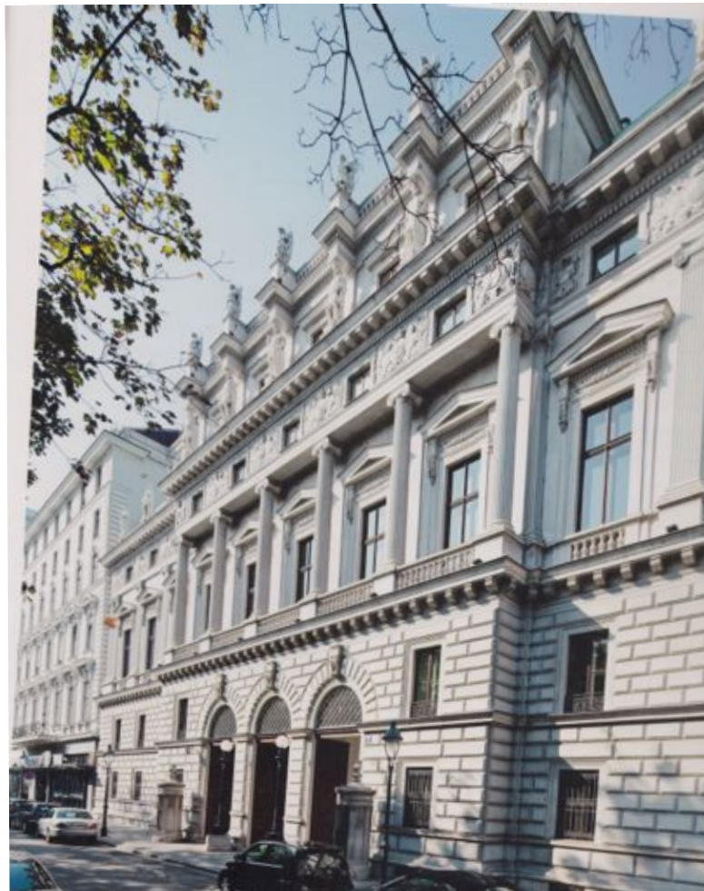
Abb. 99: Palais Erzherzog Wilhelm, Fassade.
