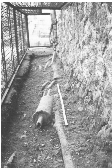
Abb.18 Wasserrohre aus Blei im Gehsteig verlegt
