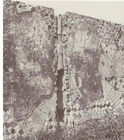
Abb.98 Fallrohr in der Wand der taberna VI 6,22
