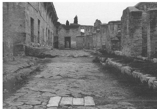
Abb.88 Via dei Balconi in Ostia mit Kanalabdeckung
