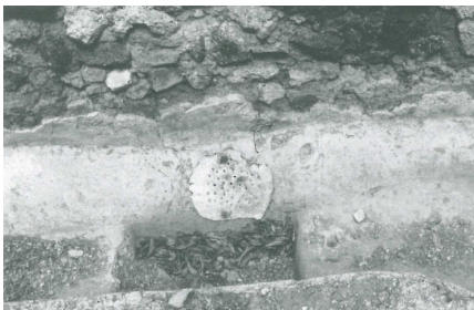
Abb.5 Sinkkasten in der Rinne des Peristyls mit durchlöcherter Blechabdeckung vor der Zisternenöffnung
