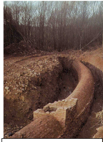
Abb.7 Leitung untern der Erde, Eiffelkanal
