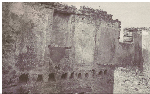
Abb.96 Latrine in Wandnische im Obergeschoss des Cenaculum VII 2,19
