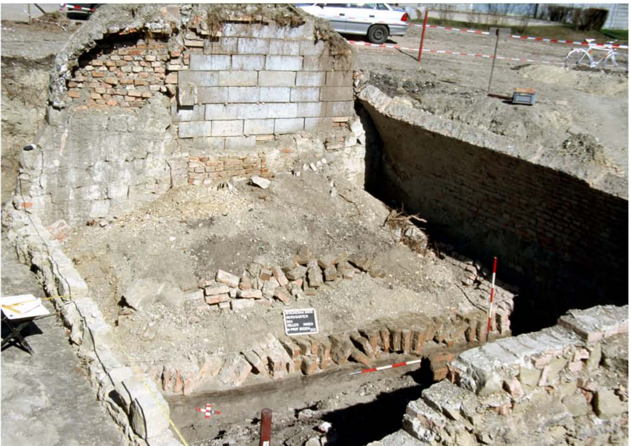
Abb. 40: S04, Keller, Innenseite der Nordmauer, Blickrichtung Nord
