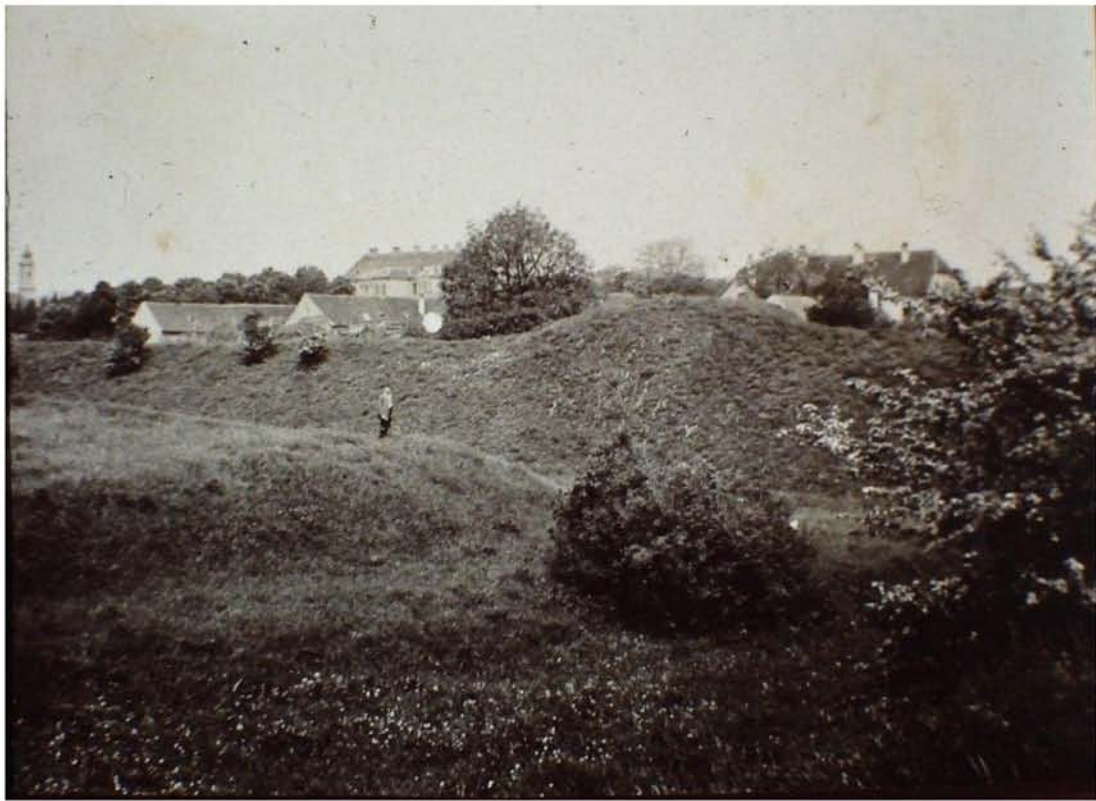
Abb. 5: Foto aus dem Burginneren in Richtung Nordwest, mit dem Kernwerkplateau und der Bastei im Hintergrund, um 1930
