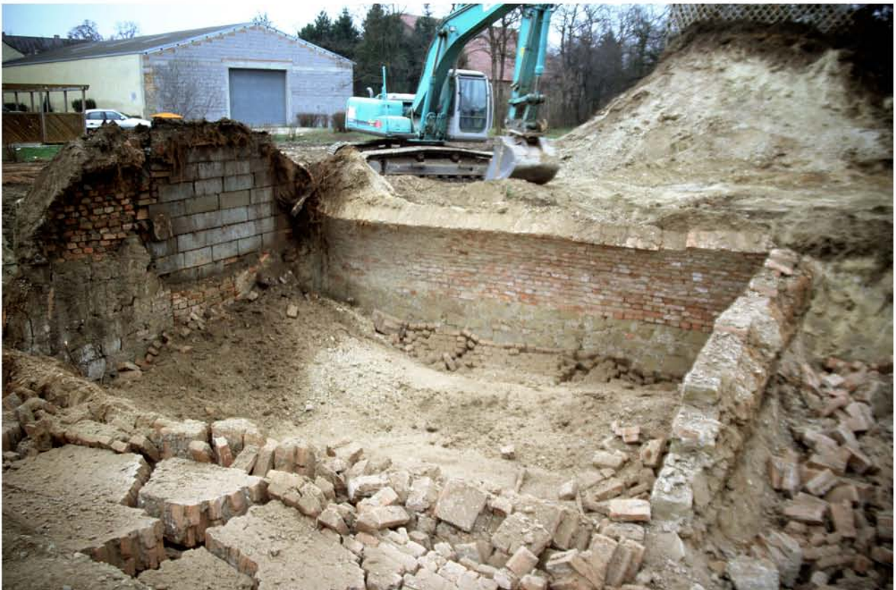
Abb. 44: S04, Innenseiten der Nord- und der Ostmauer des Kellers, Blickrichtung Nordost
