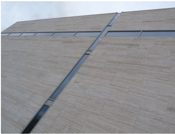
Abb.5. Die mit Travertin bedeckte Fassade vom Empfangsgebäude.
