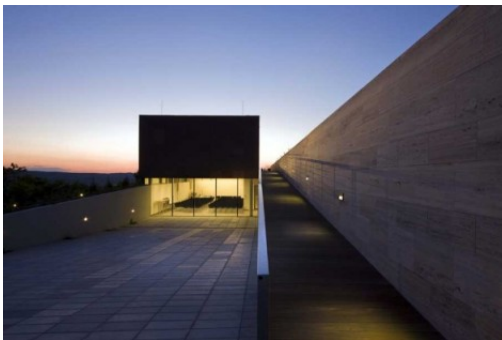
Abb.30. Das Besucherzentrum aus der Richtung des Empfangsgebäudes.
