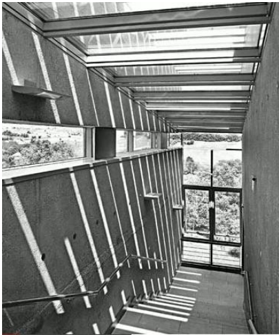
Abb.10. Das Treppenhaus vom Empfangsgebäude.
