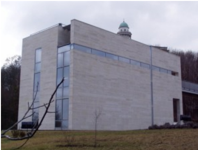
Abb.8. Das Empfangsgebäude von Hinten.
