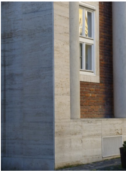
Abb.24. Die Eingangsfassade des Gymnasiums, 1943.
