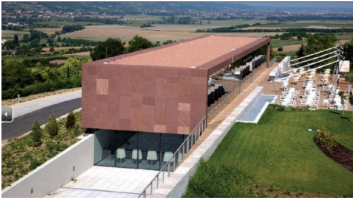
Abb.33. Das Restaurant mit der Terrasse.
