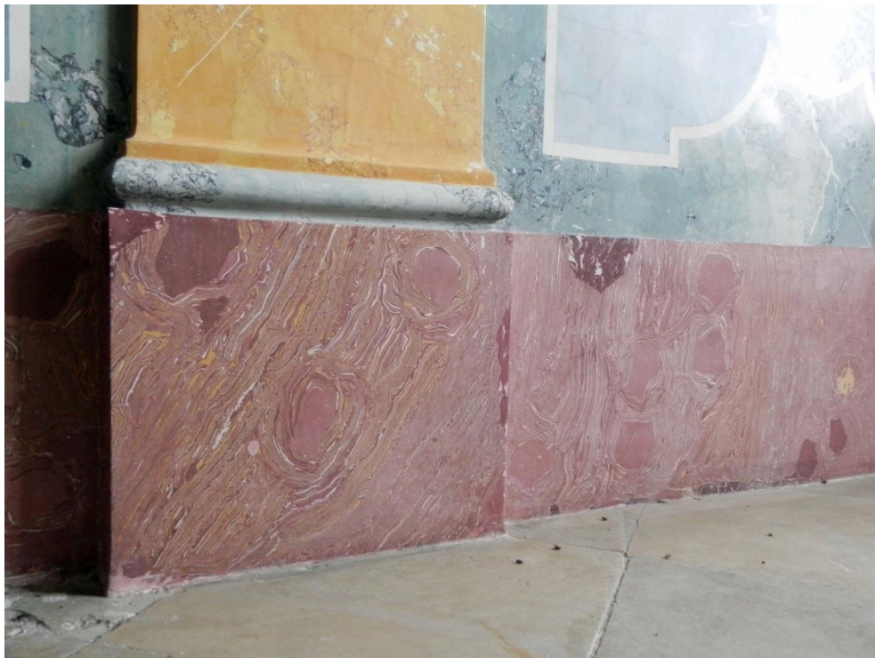
Abb. 52: Johann Georg Hoppel, Stuckmarmor, Nordwand, 1738-1741, zweites Marmorzimmer, Stift Altenburg, Detail: Sockelzone.
