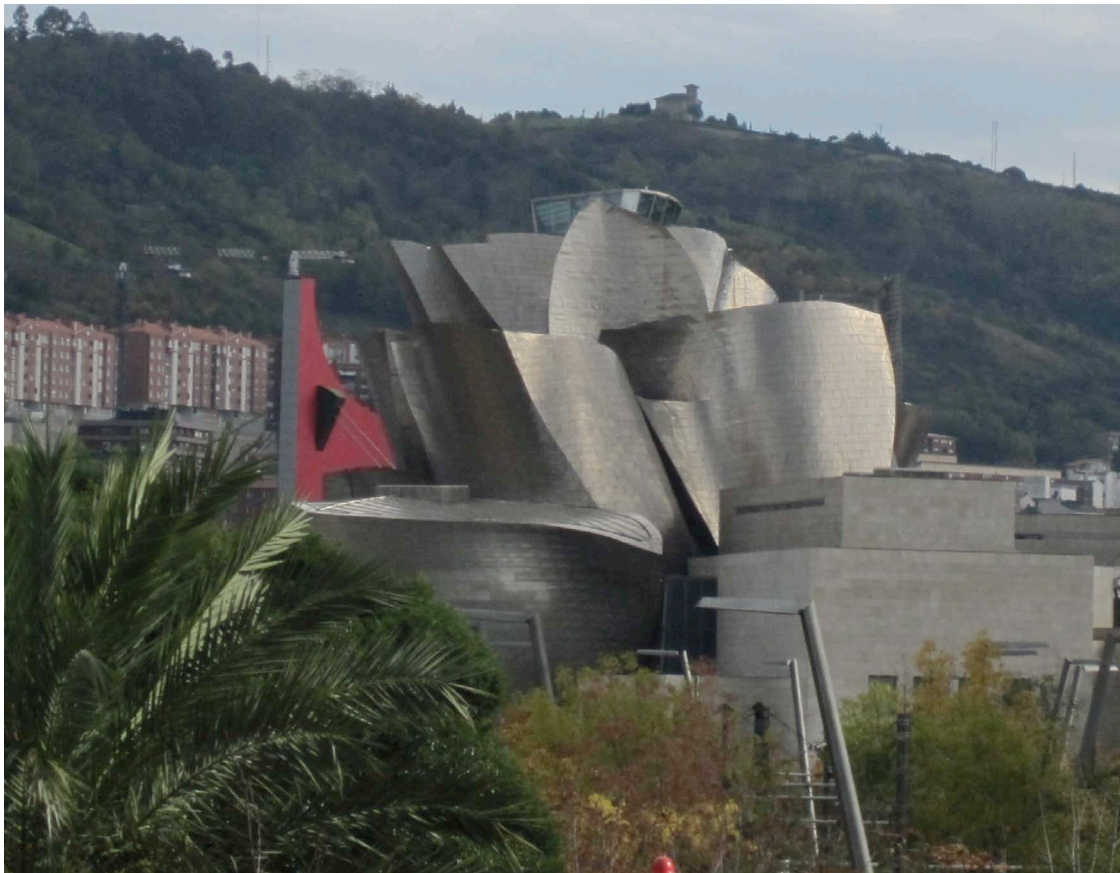
Abb. 46: Guggenheim Museum, Ansicht aus Nordwesten
