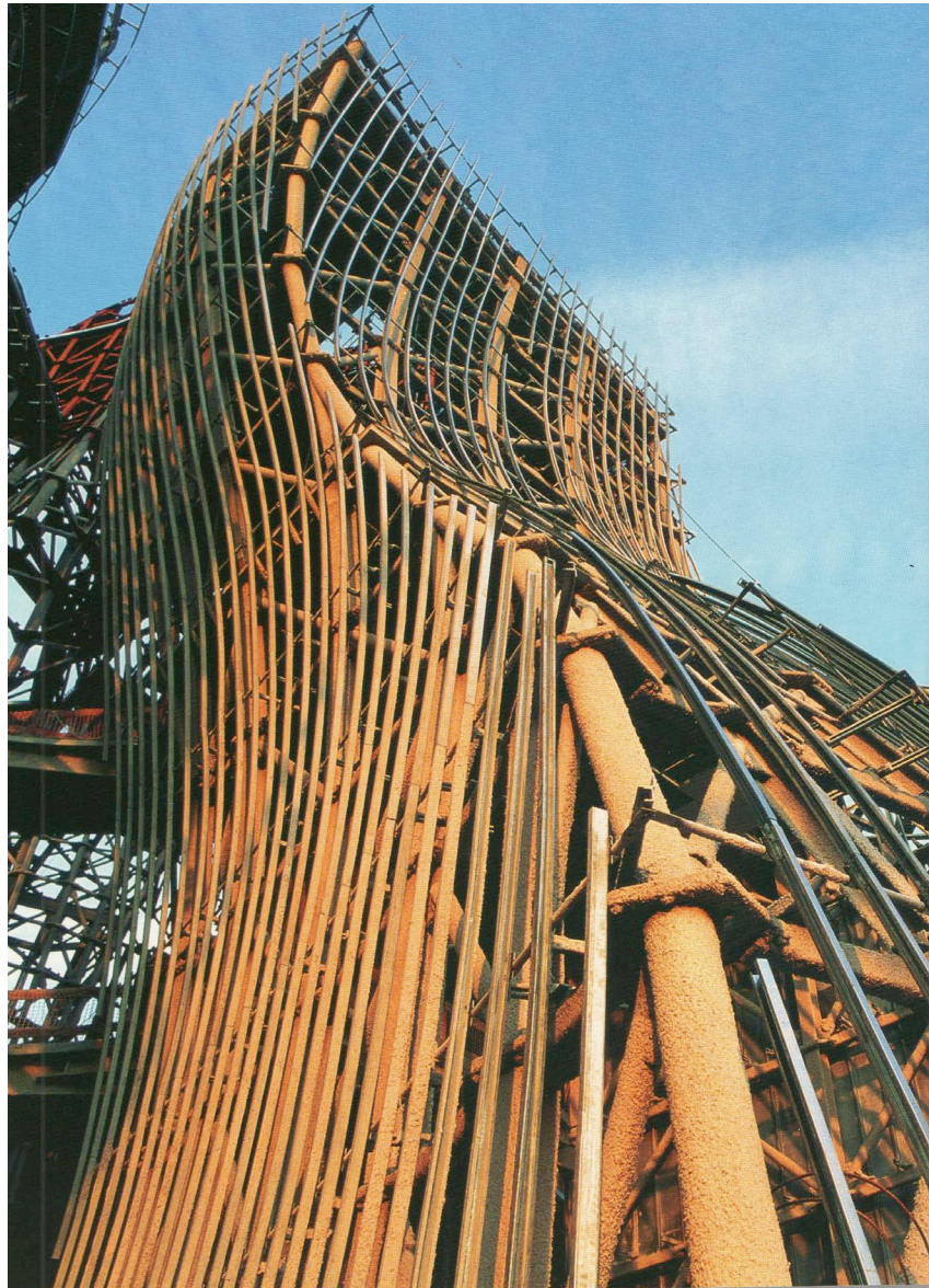
Abb. 29: Skidmore, Owings & Merrill, Stahltragwerk des Guggenheim Museums
