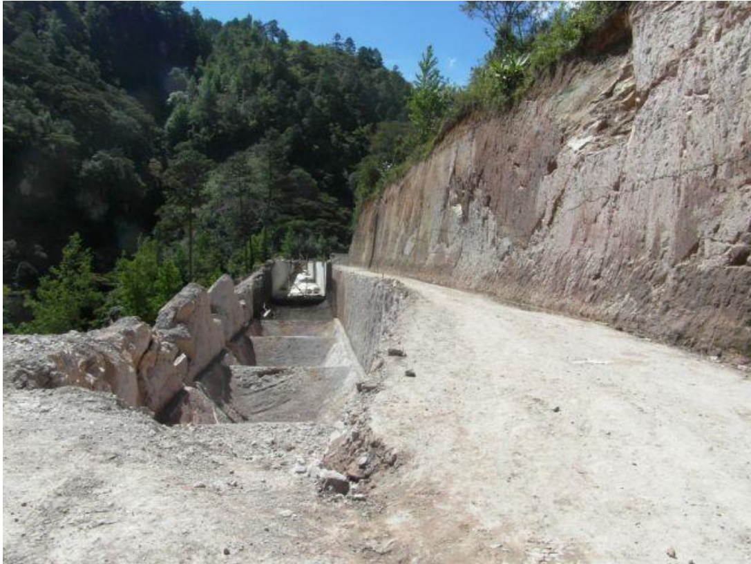
Senkrechte ungesicherte Wand beim Umleitungskanal; Foto: Magdalena Heuwieser, 1.4.2013
