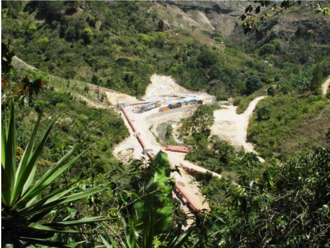
Druckkanal hinab ins Tal zum Turbinenhaus, Foto: Magdalena Heuwieser, 1.4.2013
