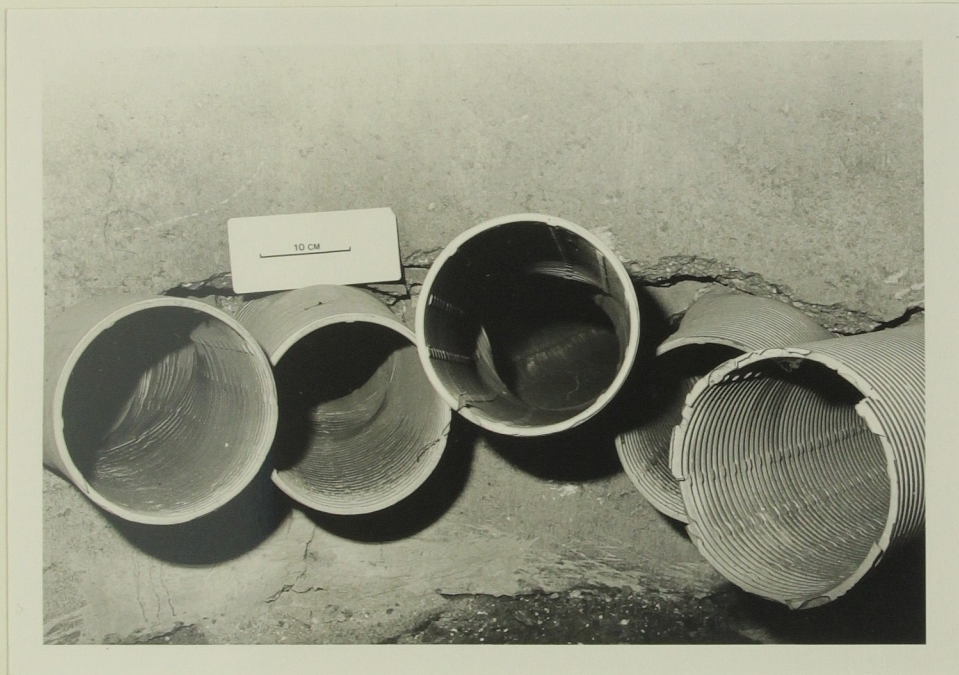
Abb. 4: Wärmetauschrohre in einem der Ansaugschächte (der horizontale Verlauf der Wärmetauschrohre ist ersichtlich)
