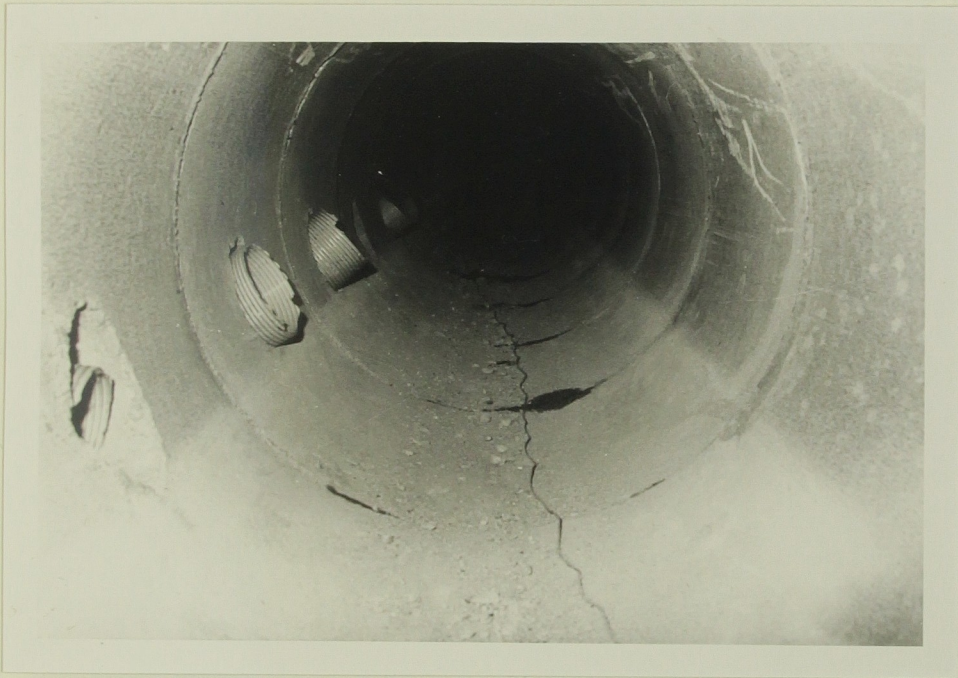
Abb. 6: Sammelkanal, in den die 20 Wärmetauschrohre einmünden
