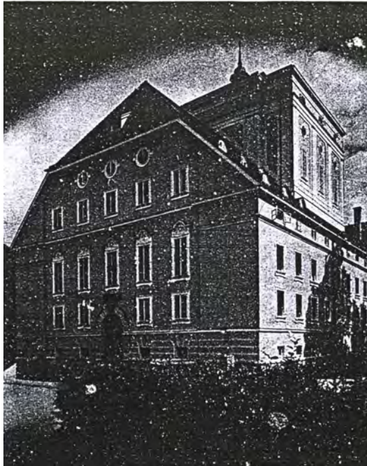
Abbildung 6: Bühnenhaus nach dem Umbau
