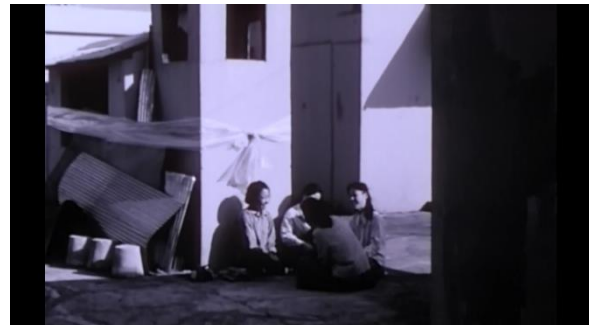
Abb. 45: Das Dach zu Chons Zeit 262
