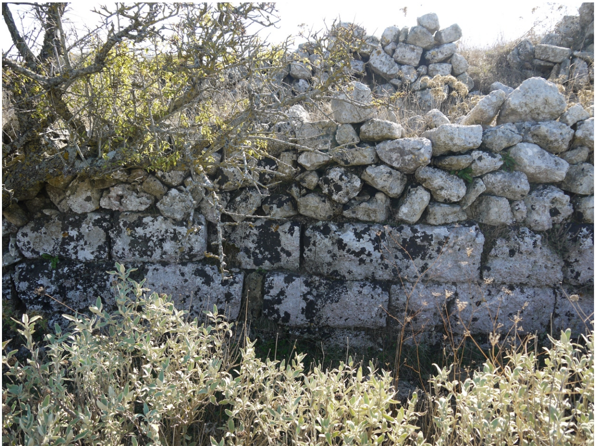
Abb. 32: Goulediana, Onythe, fortifikatorische Anlage, Detail
