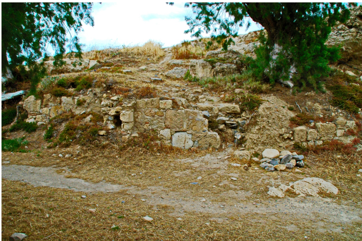
Abb. 64: Chersonesos, Rest der landseitigen Befestigungsmauer, von S
