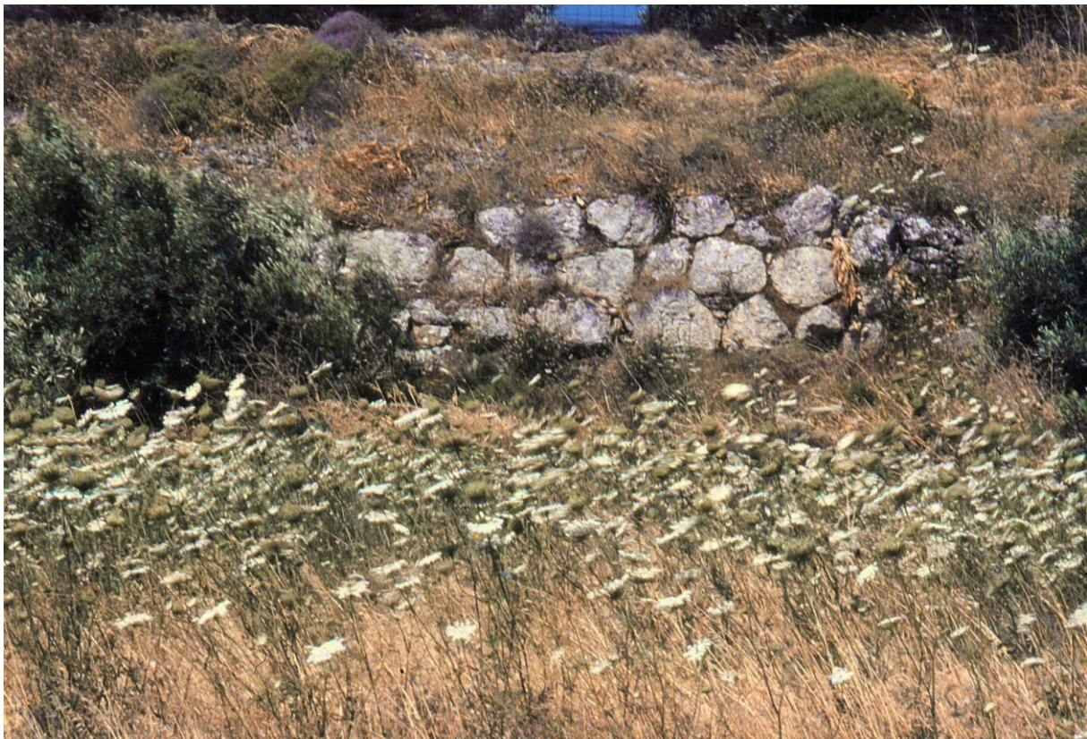
Abb. 23: Elyros, Ostmauer, von O
