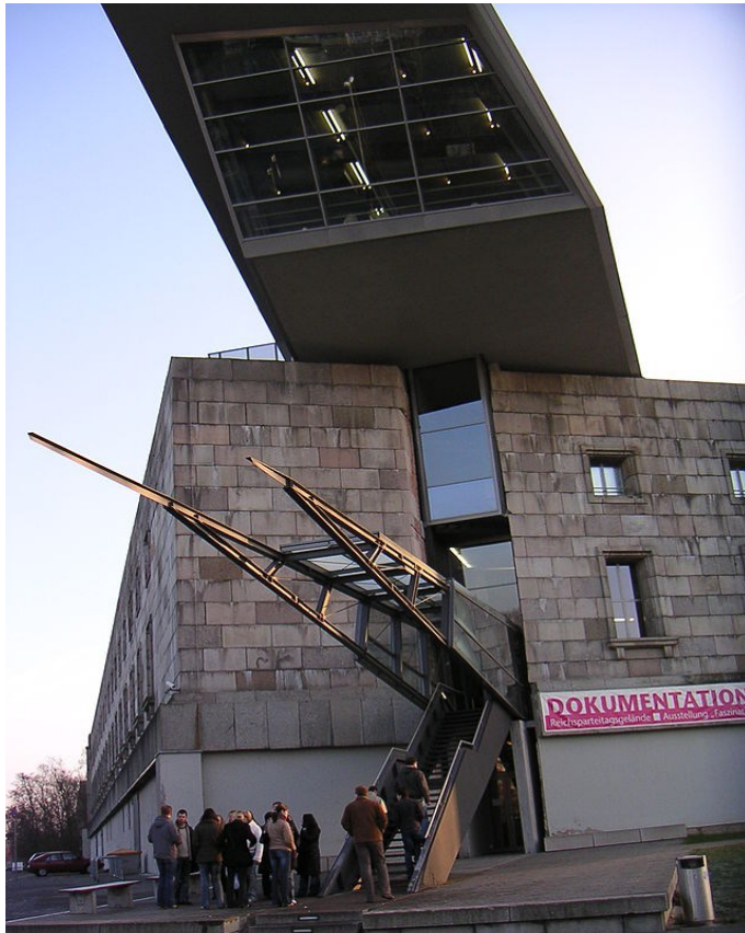
Abb 55: Domenig, Dokumentationszentrum Reichsparteitagsgelände, 1995, Eintritt des „Pfeils“ in den Baukörper der Kongresshalle.
