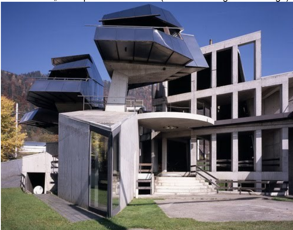
Abb 42: Die stählernen „Schwebesteine“ (im oberen Bereich des Bildes).
