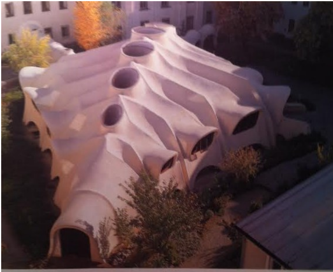
Abb 19: Domenig/Huth, Mehrzwecksaal der Schulschwestern Graz-Eggenberg, Zustand nach Fertigstellung.
