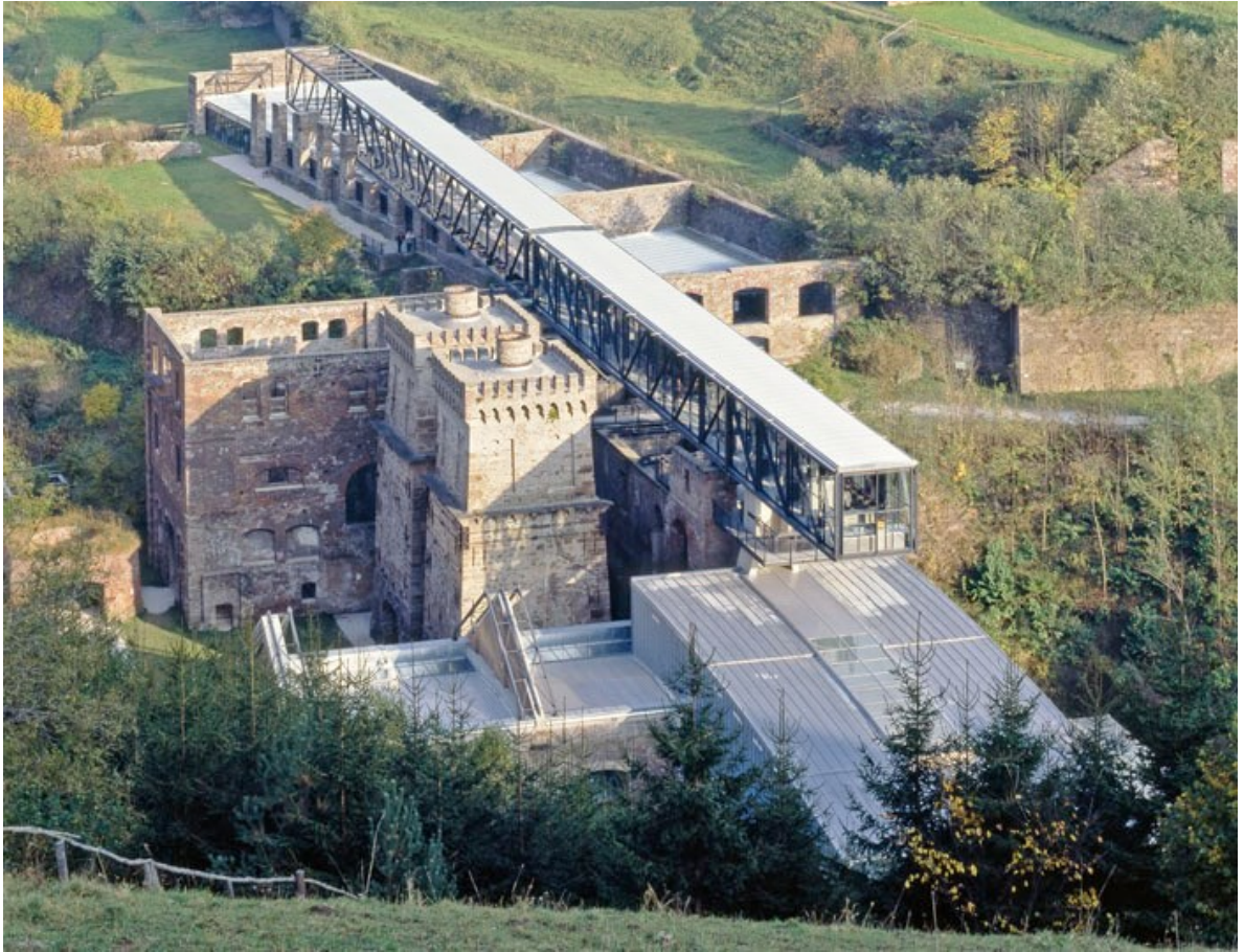
Abb 53: Kärntner Landesausstellung Hüttenberg, Stollenförmiger Anbau Günther Domenigs an den historischem Baubestand, 1993.
