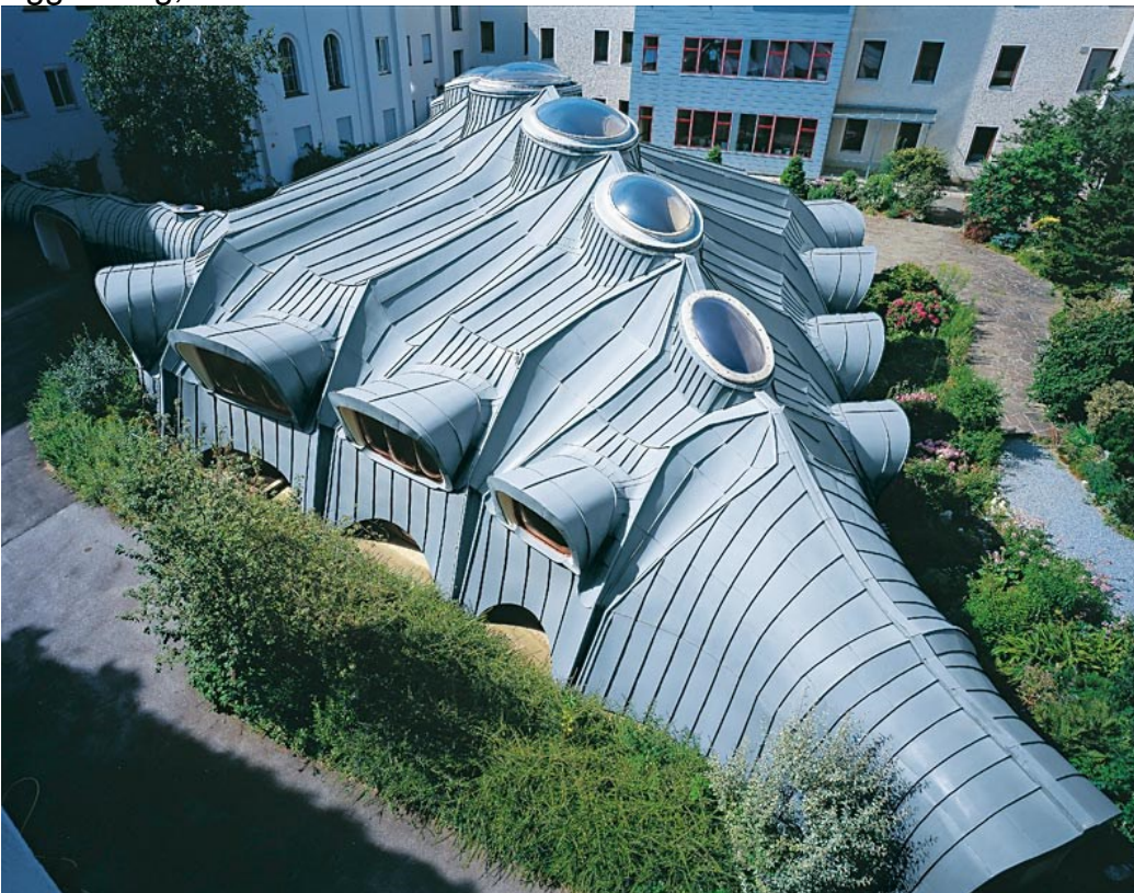
Abb. 22: Domenig/Huth, Mehrzwecksaal, heutiger Zustand.
