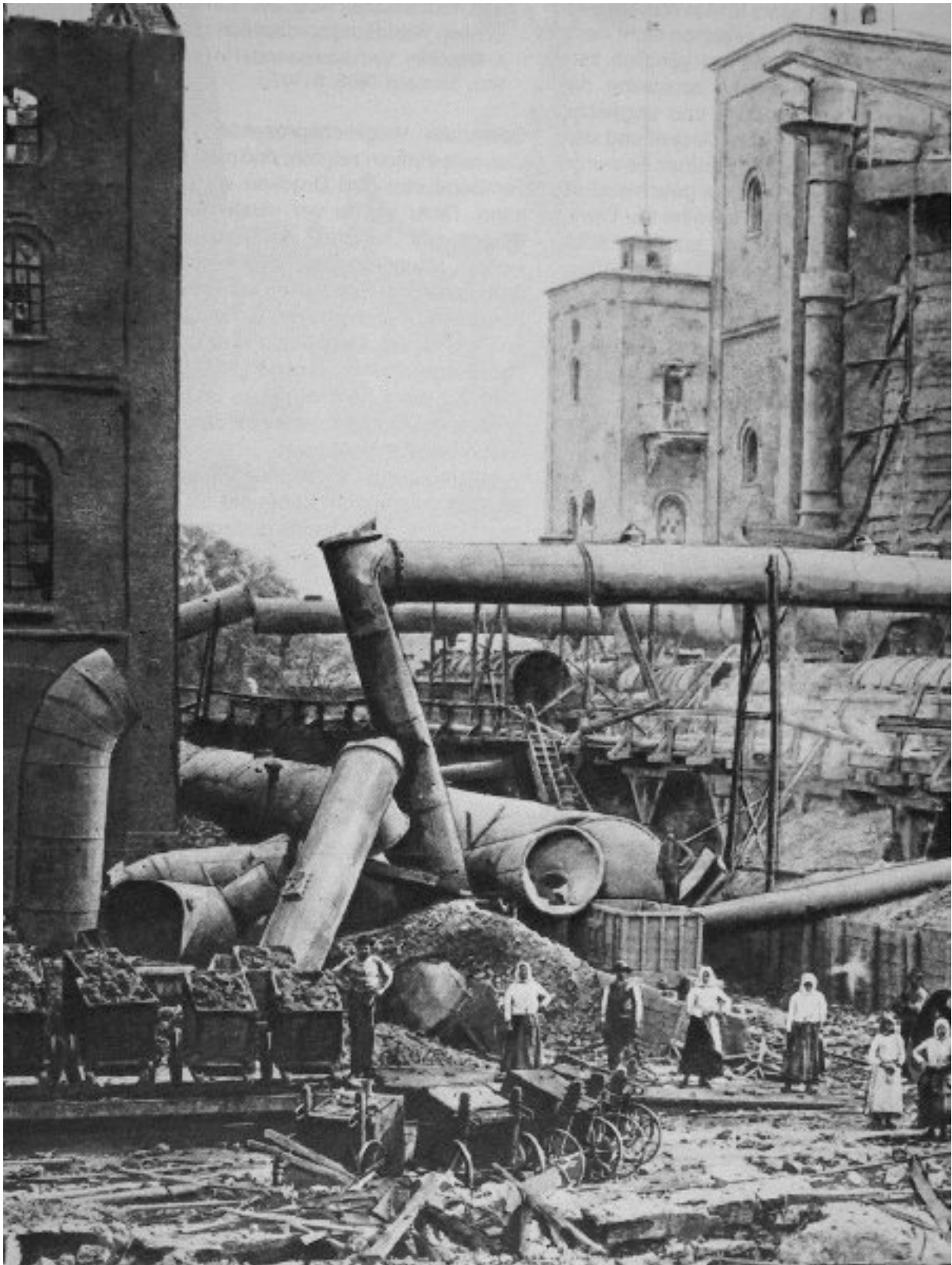
Abbildung 1: Dampfkesselexplosion in Marienberg 1906
