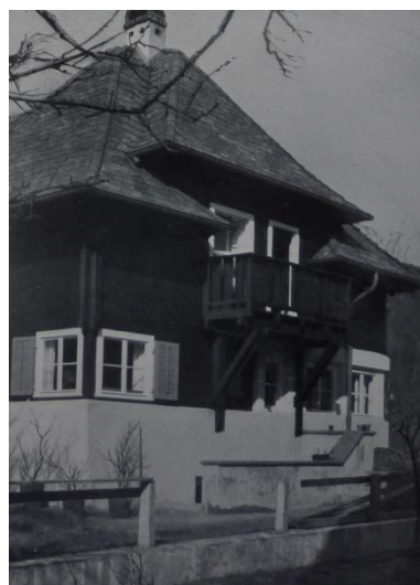
Abb. 03.02: Alfons Fritz, Haus Bohle, Dornbirn, Südansicht
