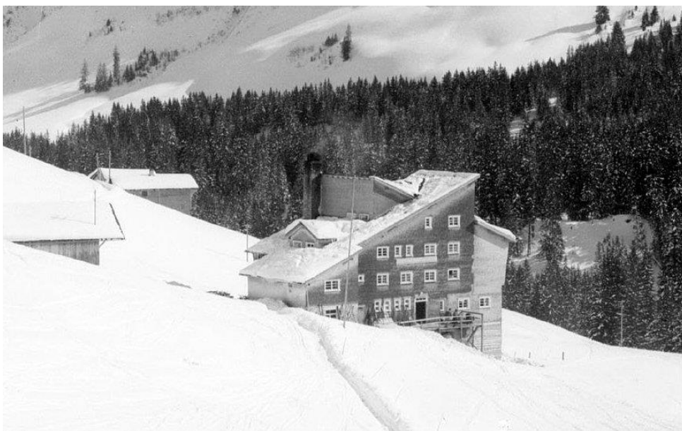
Abb. 28.15: Alfons Fritz, Berghotel Madlener, Damüls, Westfassade, Aufnahme 1942
