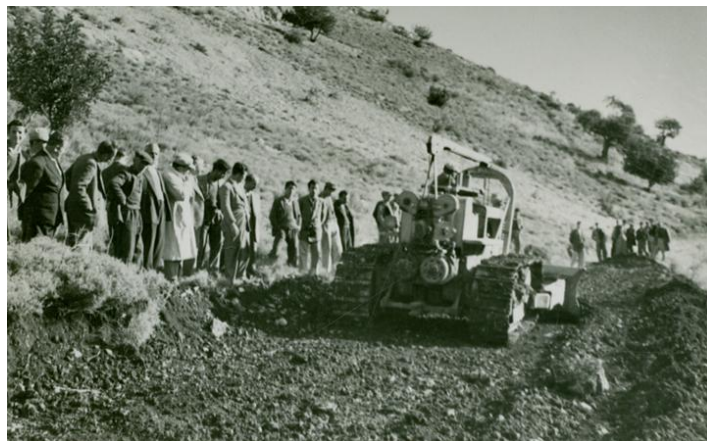
Abb. 3: Bau der Straße von Leonidio nach Argos. Foto: Emmanouil Rentoulis
